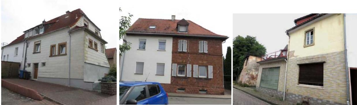
*Ortsuntypische Fassadengestaltung: links Komplettverkleidung mit Eternitplatten, mittig: durch energetische Sanierung wurde ortstypische Fassade zerstört, rechts: durch untypische Fliesen und Fensteröffnung entstellte historische Fassade.*
