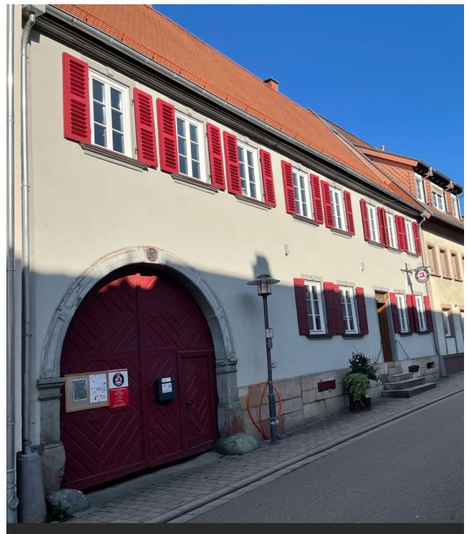
Positivbeispiel: historische Hofeinfahrt wurde in Form und Art erhalten
