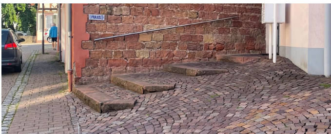
Positivbeispiele: Pflasterung mit ortstypischen Materialien
