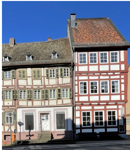
Typische vertikale Fassadengliederung bei traufständigen Gebäuden
