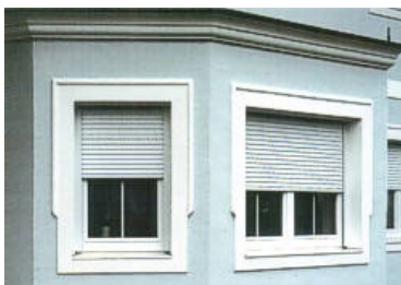
Positivbeispiel: Wenn Rollläden nicht vermeidbar sind, so müssen sie zumindest hinter der Fassadenfläche zurückbleiben.
