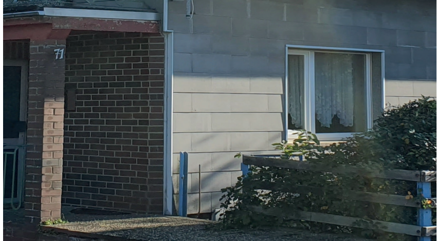
Beispiel für eine nicht ortsbildgerechte Materialität der Fassade
