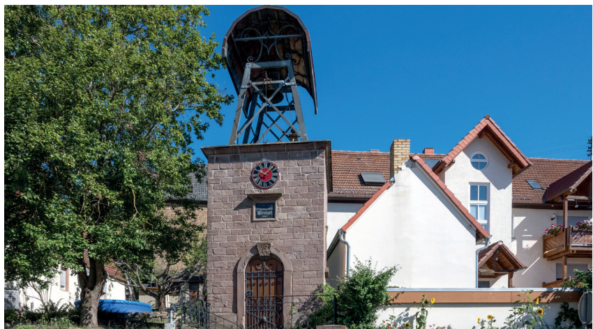
Denkmalgeschützter Glockenturm, Wörsbach
