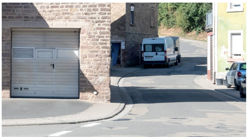
Funktionsmangel: nicht ortsbildgerechte Straßengestaltung
