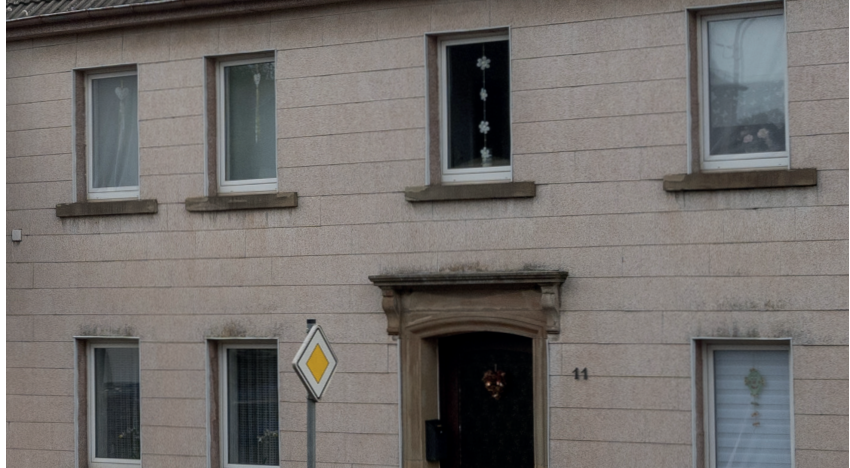
Missstand Beispiel: Materialität der Fassade (Faserzementplatten)
