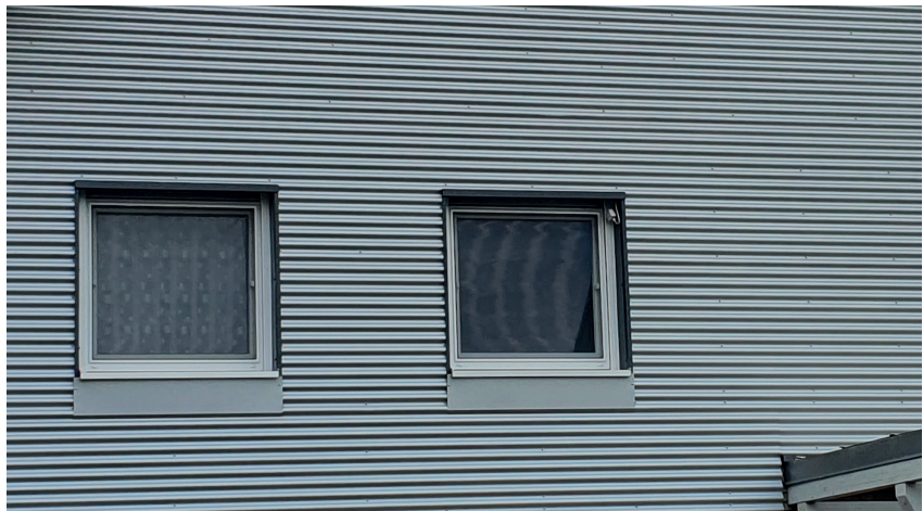
Missstand Beispiel: Materialität der Fassade (Aluminiumplatten)
