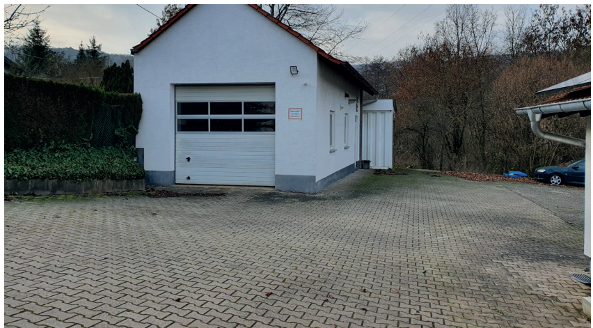
Platzfläche im Bereich des Feuerwehrgerätehauses
