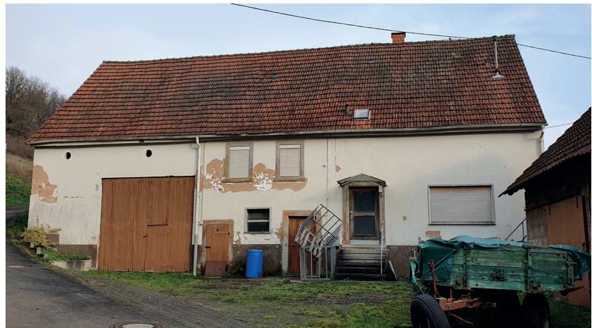
Leerstehendes Wohngebäude mit angrenzendem Stallgebäude im Bereich der Eckstraße
