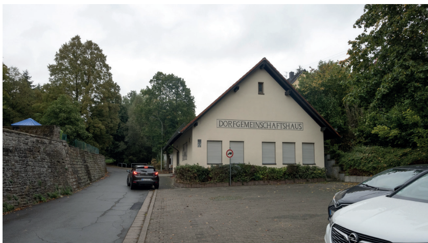
Platzfläche im Bereich des Bürgerhauses (Heimkirchen)
