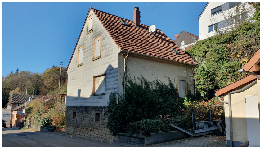
Leerstehendes Wohngebäude im Bereich der Heimkircher Straße
