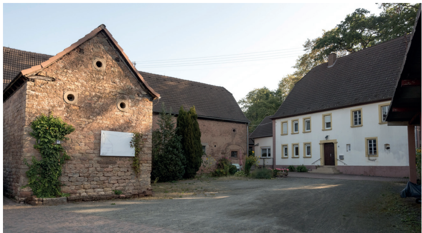
Denkmalgeschützte Mühle in der Bachstraße, Katzweiler
