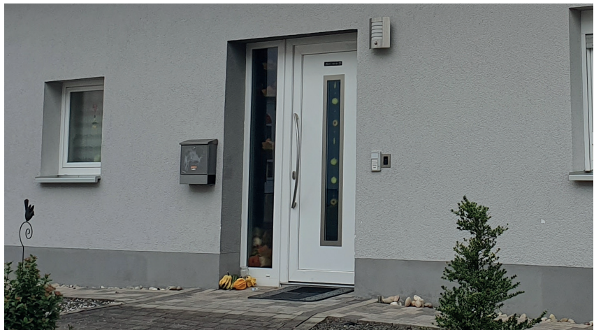
Modernisierungs- und instandsetzungsbedürftiges Gebäude mit geringem Bedarf
