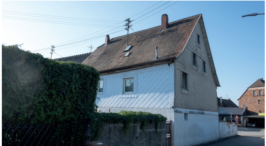
Missstand Beispiel: Materialität der Fassade
