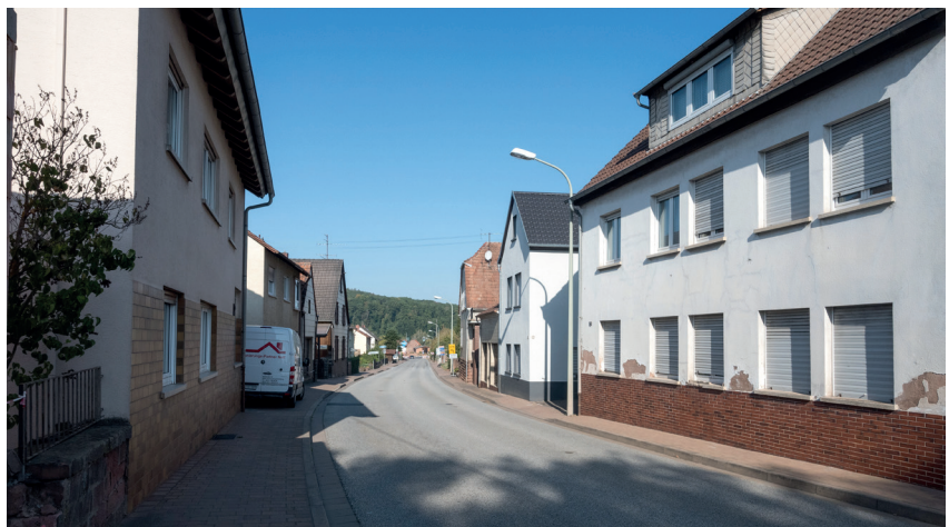
Funktionsmangel: nicht ortsbildgerechte Straßengestaltung
