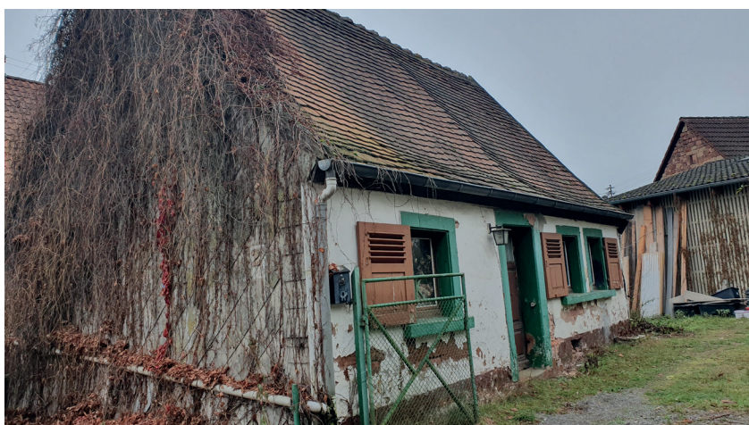
Leerstehendes Wohngebäude im Bereich Kircheck
