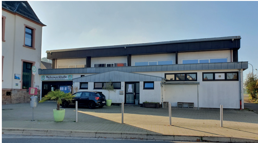
Barrierefreier Zugang zum Bürgerhaus/Mehrzweckhalle
