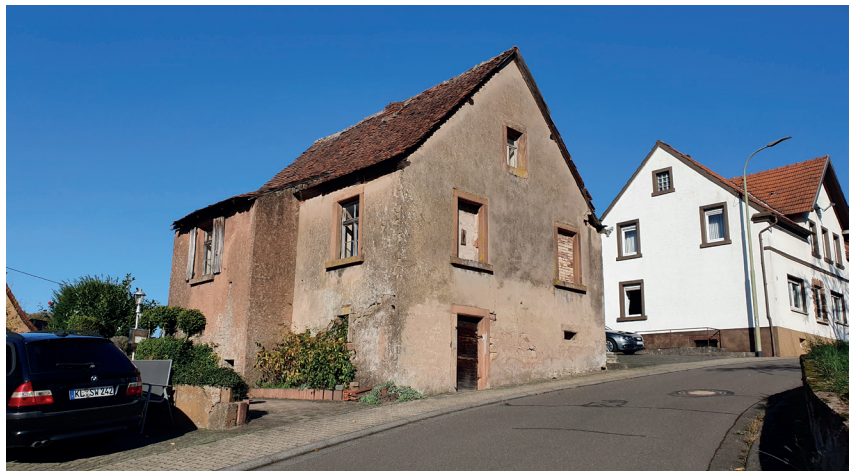
Leerstehendes Wohngebäude im Bereich der Rosenstraße
