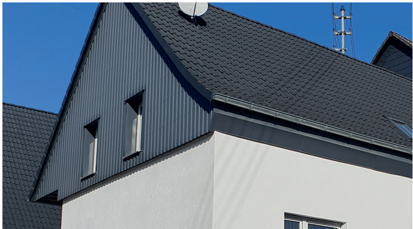
Modernisierungs- und Instandsetzungsbedürftiges Gebäude mit geringem Bedarf
