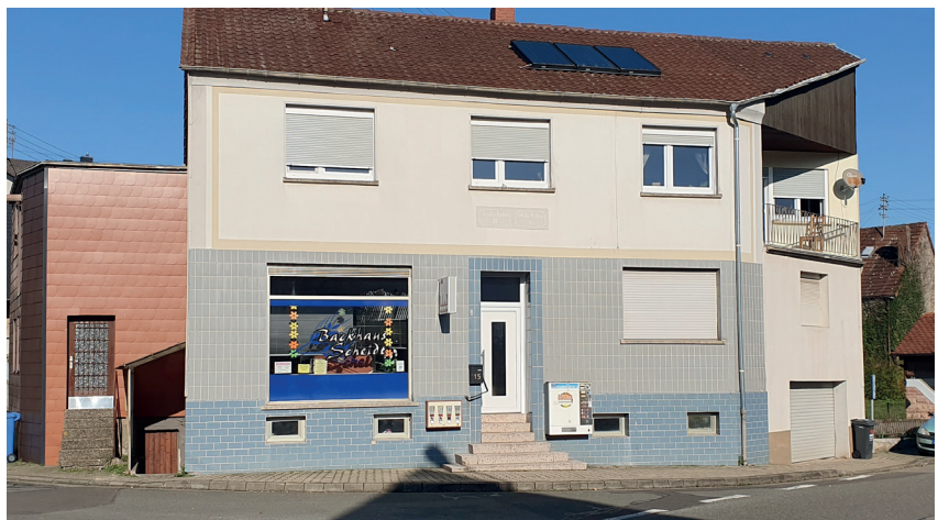
Bäckereifiliale Scheidt im Bereich der Hauptstraße
