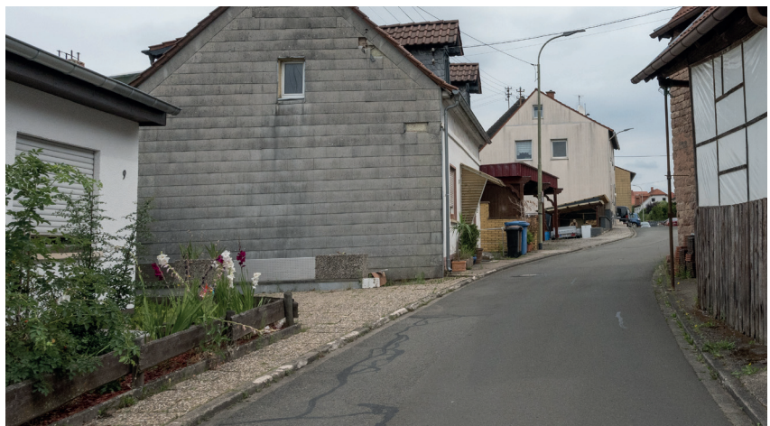
Funktionsmangel: nicht ortsbildgerechte Straßengestaltung
