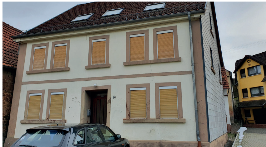
Leerstehendes Wohngebäude im Bereich der Blumenstraße
