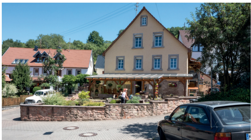
Ortsbildprägendes Wohnhaus, Talstraße 37, Frankelbach
