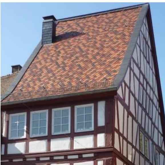
Technische bedingte Schieferbänder an Organg, First, Kehlen und Dachaufbauten akzentuieren die jeweilige Dachform.
