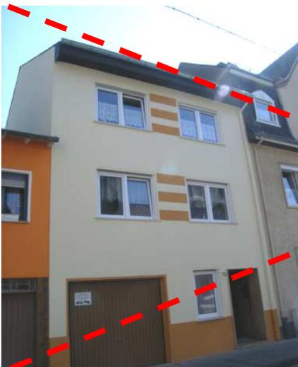
Direktes Übereinander einer fachgerechten und einer unsachgemäßen Fassadensanierung
