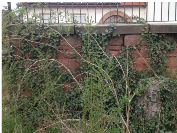
Die zugewucherte Mauer zur Hauptstraße hin, nur wenige Bereiche sind ohne Bewuchs
