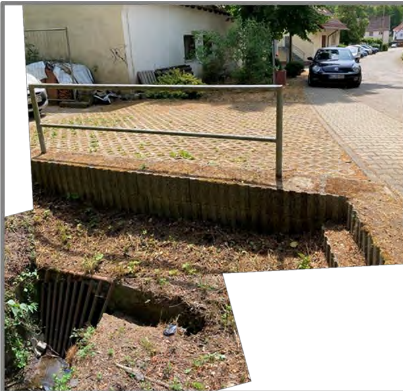
Abb. 156: Zulaufschacht am Beginn der Bornbachverrohrung
