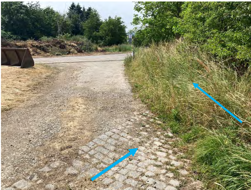
Abb. 99: Unbefestigter Weg von Norden und seitlicher Graben
