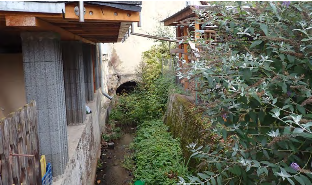
Abb. 47: Gewässer Weilerbach am Beginn der Verrohrung zum Odenbach
