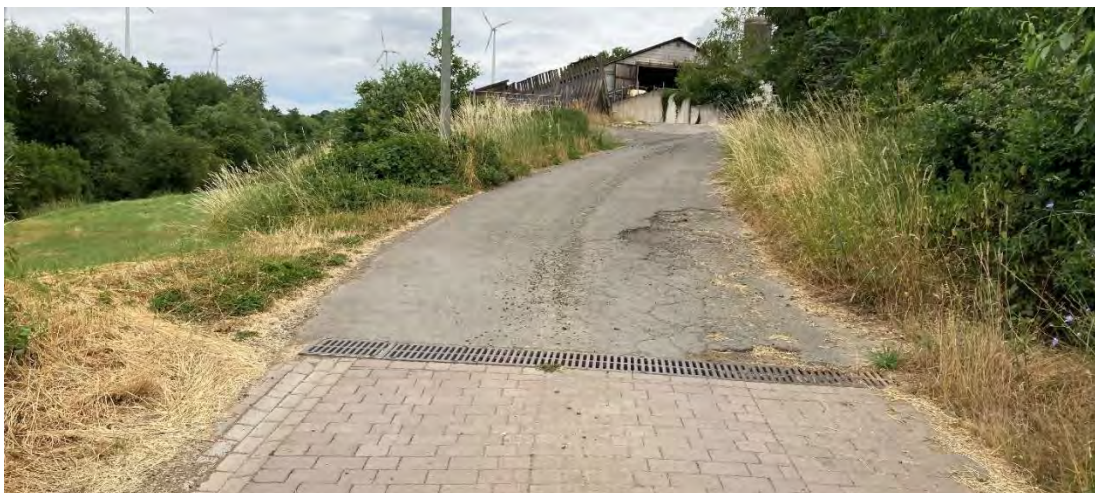
Abb. 148: Entwässerungseinrichtungen in der oberen Bergstraße
