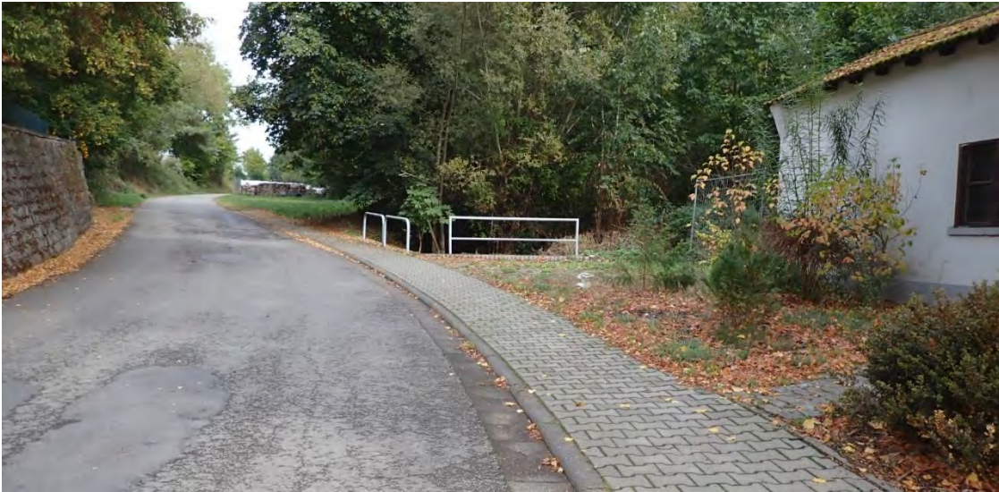
Abb. 153: Beginn der Bornbachverrohrung
