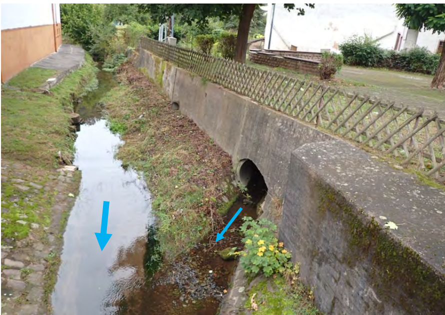
Abb. 37: Ausgebauter Odenbach mit Einmündung Weilerbach
