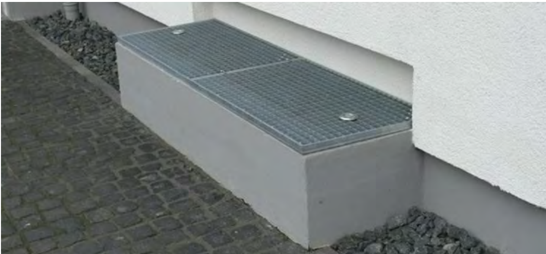
Abb. 15: Beispiel für die Sicherung eines niveaugleichen Lichtschachtes
