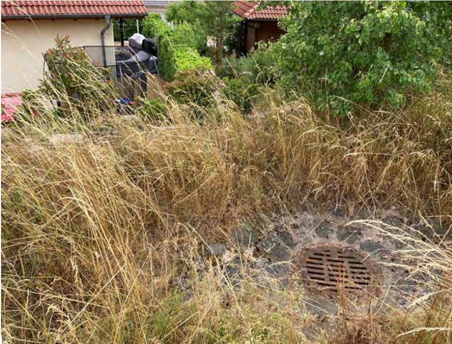
Abb. 189: Bodenablauf im Tiefpunkt des Abfangegrabens am Bebauungsrand
