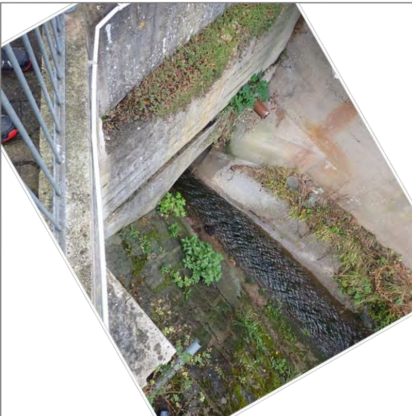
Abb. 126: Beispiel für eine Engstelle: Durchlass Heimkircher Straße
