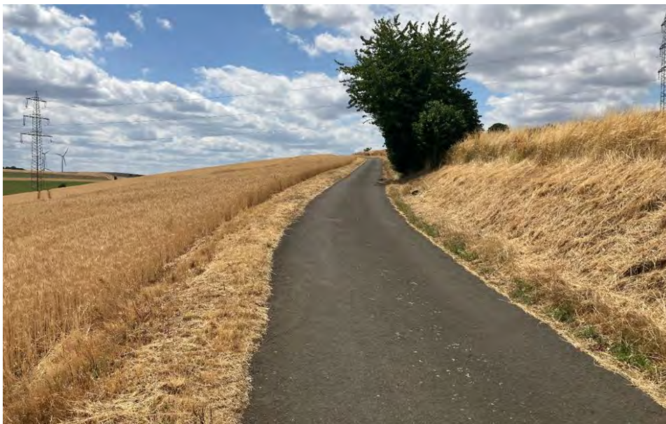
Abb. 198: Wirtschaftsweg zur Hochstraße
