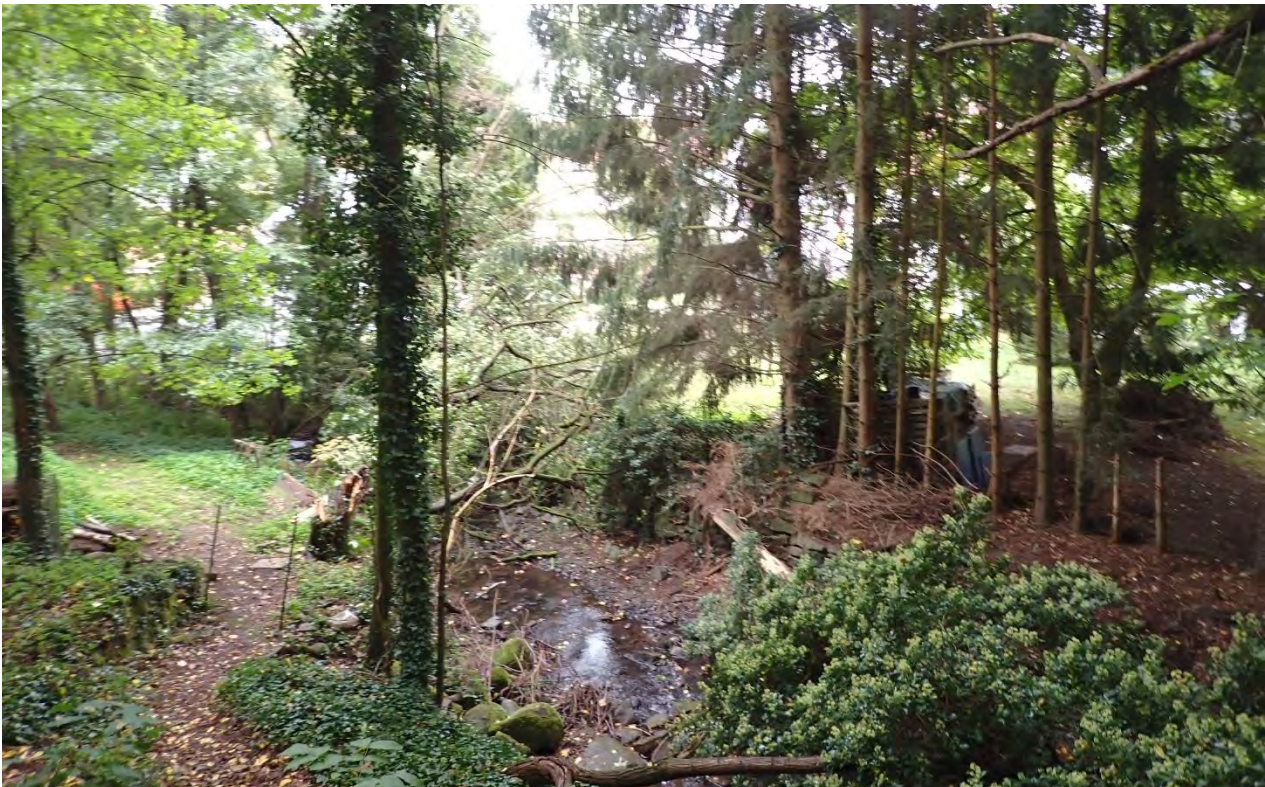
Abb. 49: Odenbach mit starker Eigendynamik (2020) und Sanierungsbedarf
