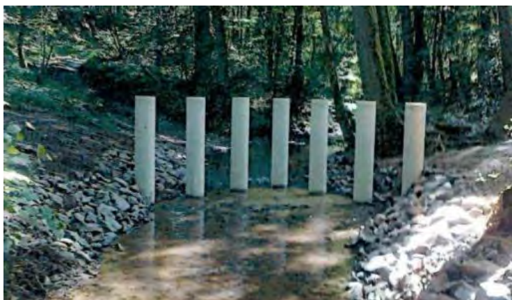
Abb. 112: Beispiel für Treibgutfänger aus Betonpfählen, Quelle: Broschüre „Hochwasser am Gewässer“ IBH-Informations- und Beratungszentrum Hochwasservorsorge RLP et.al. [9]
