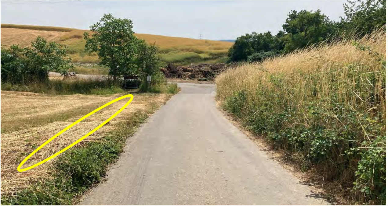
Abb. 96: Versandeter Graben oberhalb der Wegekreuzung
