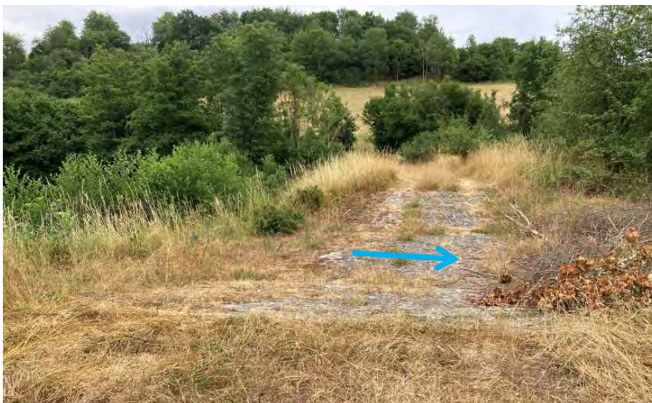
Abb. 159: Regenrückhaltebecken Selinger Tal mit Mönchbauwerk (Bild oben) und Dammscharte als 2. Hochwasserentlastung (Bild unten)
