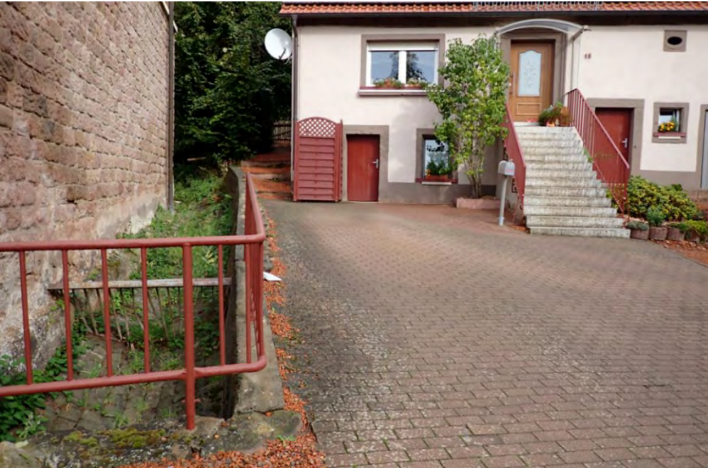
Abb. 92: Graben entlang der Hebelstraße an der Olsbrücker Straße
