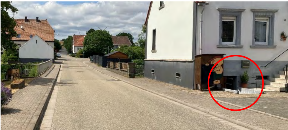
Abb. 208: Beispiel für potenziell überflutungsgefährdeten Kellerabgang in der Weierstraße
