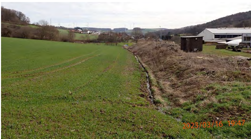
Abb. 172: Abfangegraben entlang Geländeaufschüttung
