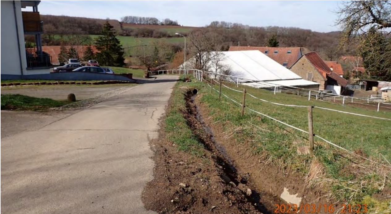
Abb. 134: Flutgraben entlang der Erschließungsstraße
