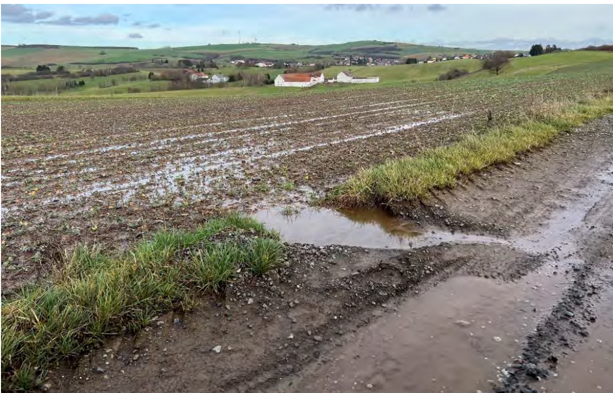
Abb. 9: Beispiel aus der Verbandsgemeinde für die Querentwässerung in die Fläche durch Öffnen des Banketts
