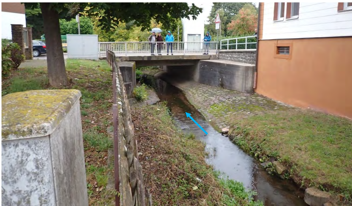
Abb. 38: Brücke Talstraße über den Odenbach
