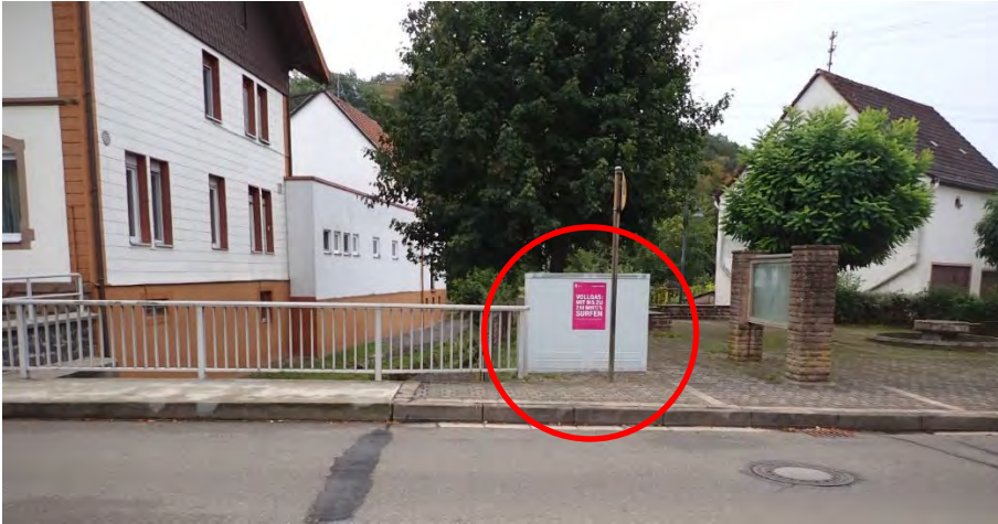
Abb. 5: Kritische Infrastruktur am überschwemmungsgefährdeten Odenbach in Niederkirchen
