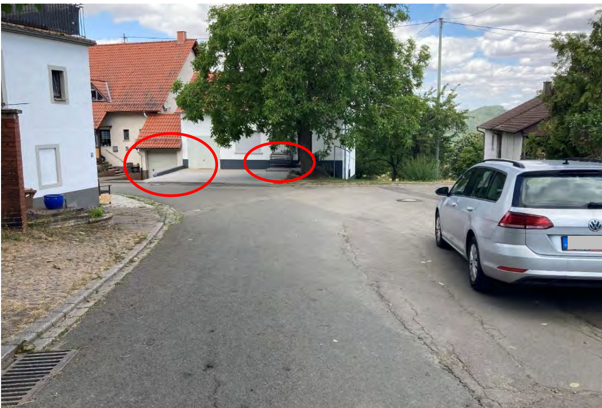
Abb. 200: Überflutungskritischer Kurvenbereich in der Hochstraße
