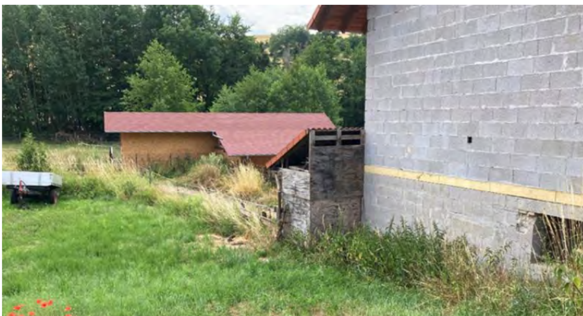
Abb. 122: Überflutungsgefährdetes Gebäude an der Heimkircher Straße
