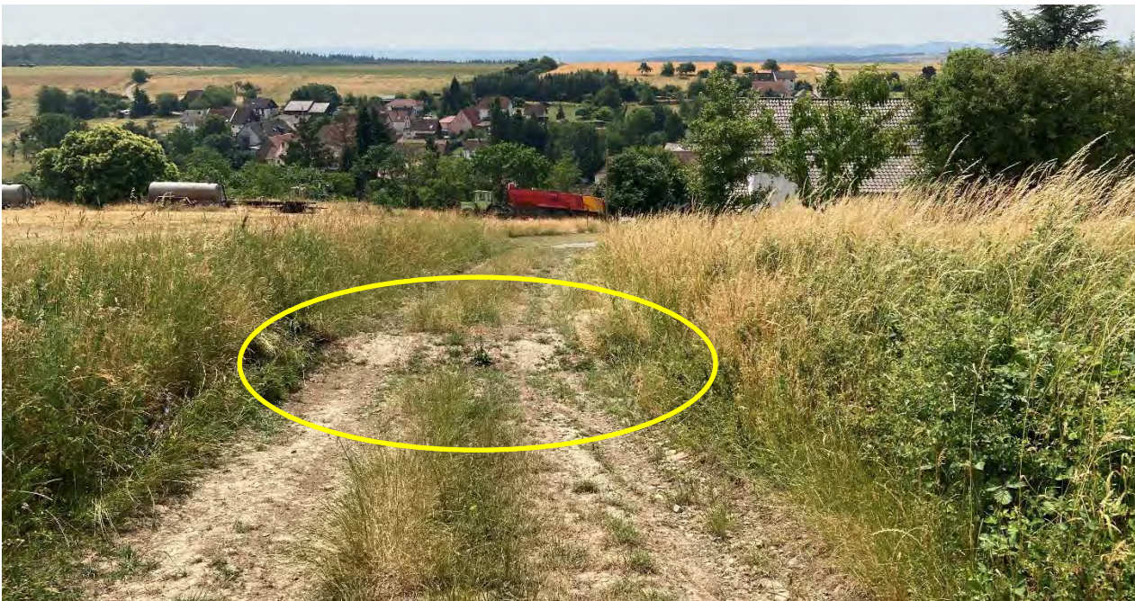
Abb. 87: Querrinne im unbefestigten Weg
