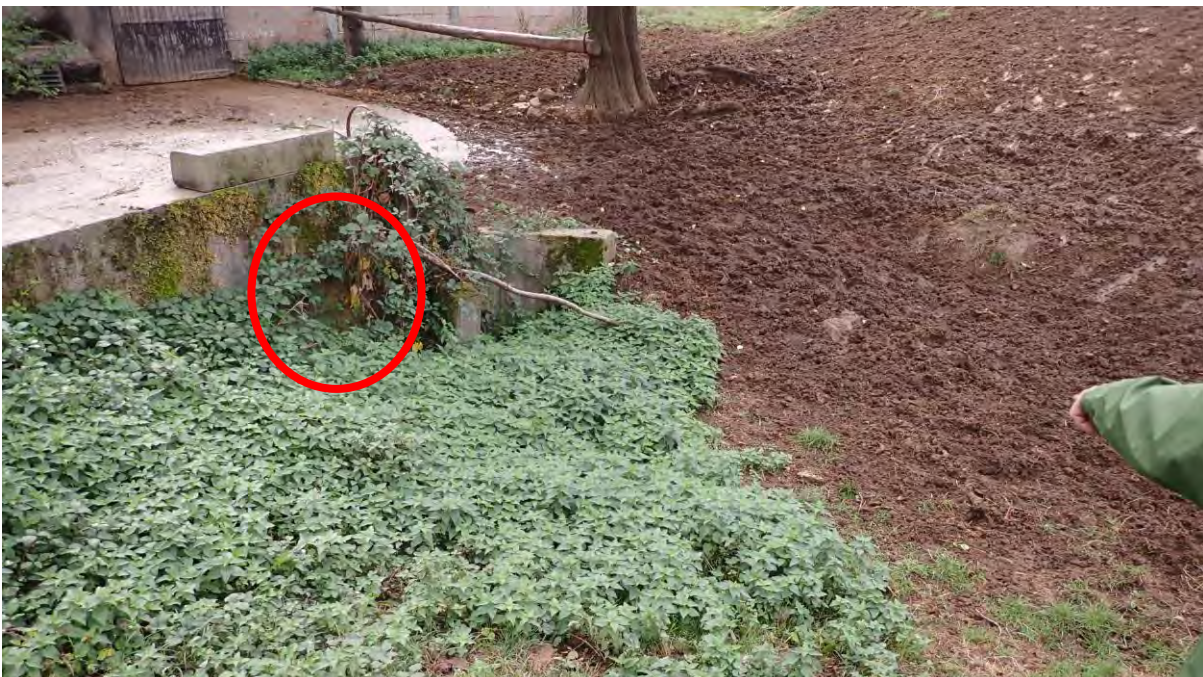
Abb. 72: Beginn der Verrohrung (rote Markierung) der Tiefenlinie aus Nordwesten
