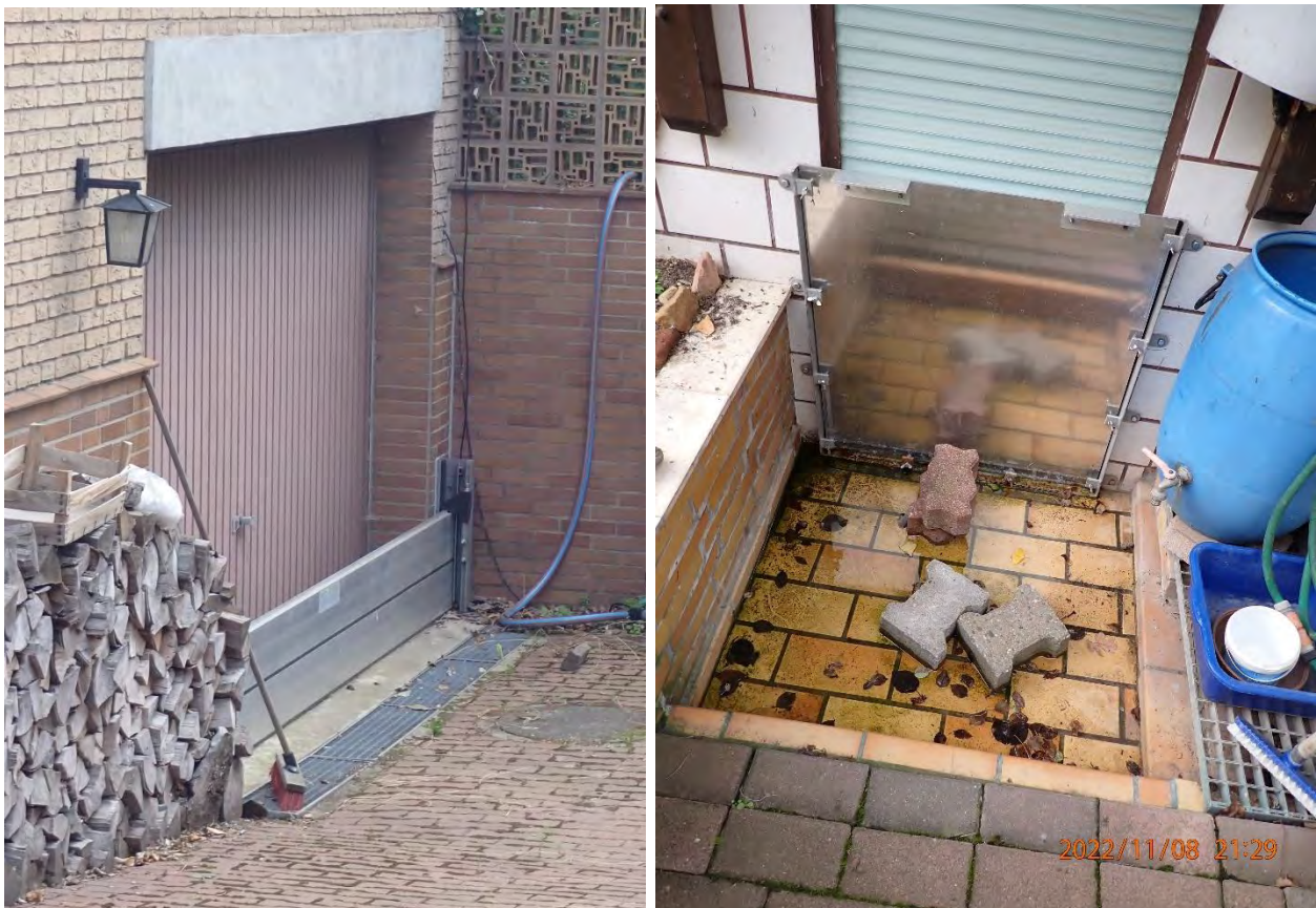
Abb. 17: Dammbalkenverschluss (links) und Schott (rechts)
