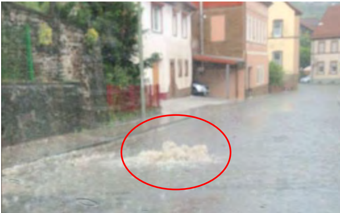
Abb. 46: Oberflächenabfluss und Kanalüberstau in der Morbacher Straße am 09.07.2018, Foto: Feuerwehr
