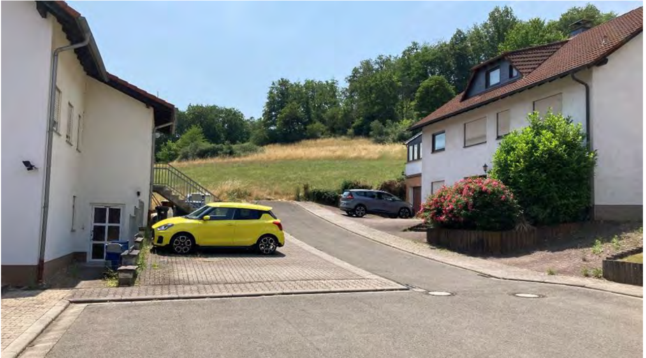
Abb. 34: Potenziell überflutungsgefährdete Wohnbebauung in der Straße „Im Tälchen“
