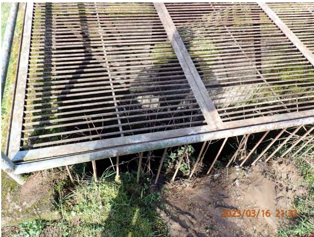
Abb. 137: Sandfang am Ende des Flutgrabens
