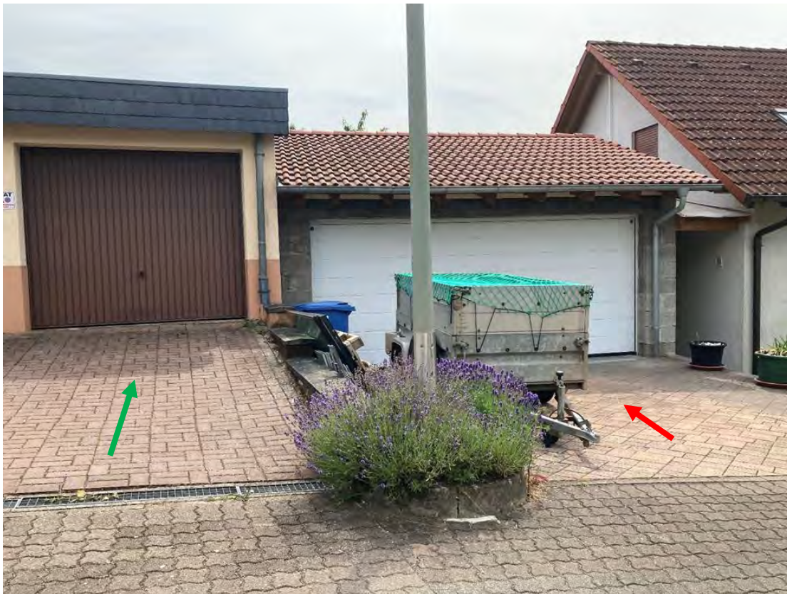
Abb. 14: Beispiel für überflutungsfördernde (rot) und überflutungsresiliente Bauweise (grün)
