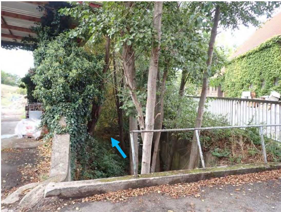
Abb. 119: Eingeengter Fließquerschnitt durch Bäume im Bachbett
