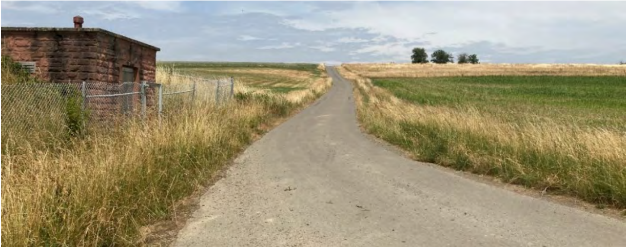
Abb. 84: Weg „Am Bornweg“ im Bereich „Hundseich“
