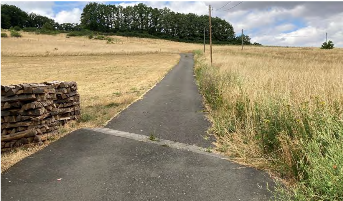
Abb. 188: Weg zur Straße „Am Burgberg“ mit Querrinne
