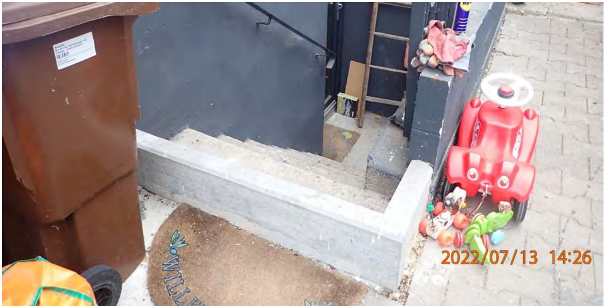
Abb. 16: Beispiel für die Sicherung eines außenliegenden Kellerzugangs
