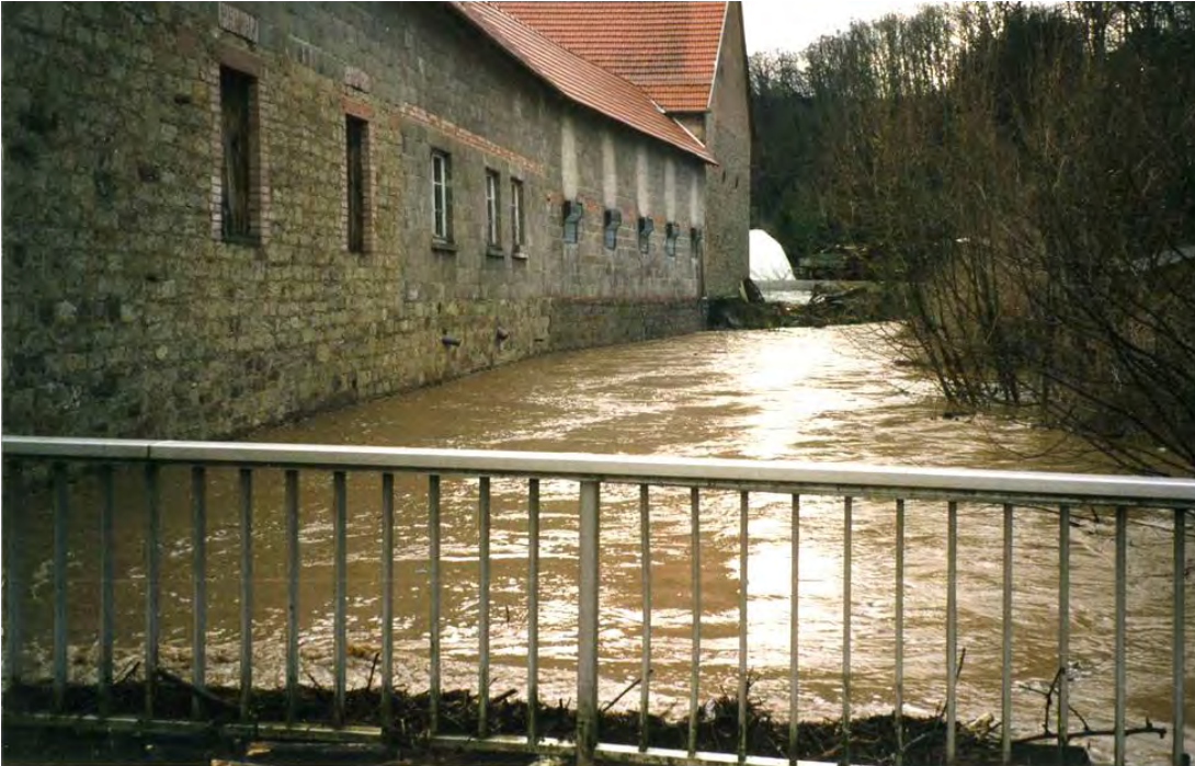
Abb. 50: Odenbach oberhalb der Brücke Schulstraße bei Hochwasser, Foto: Feuerwehr
