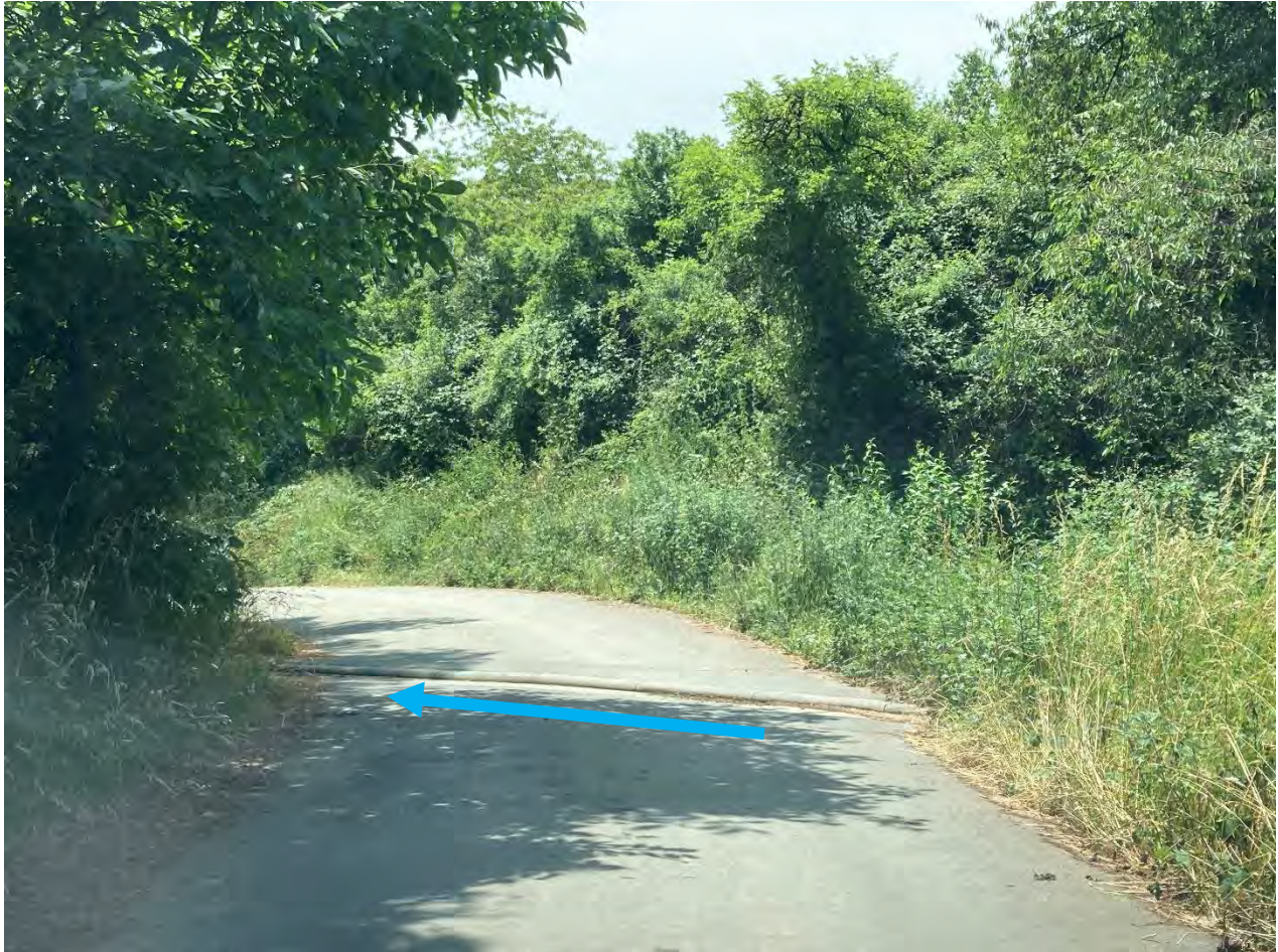
Abb. 102: Querrinne zum Graben im Kerbtal
