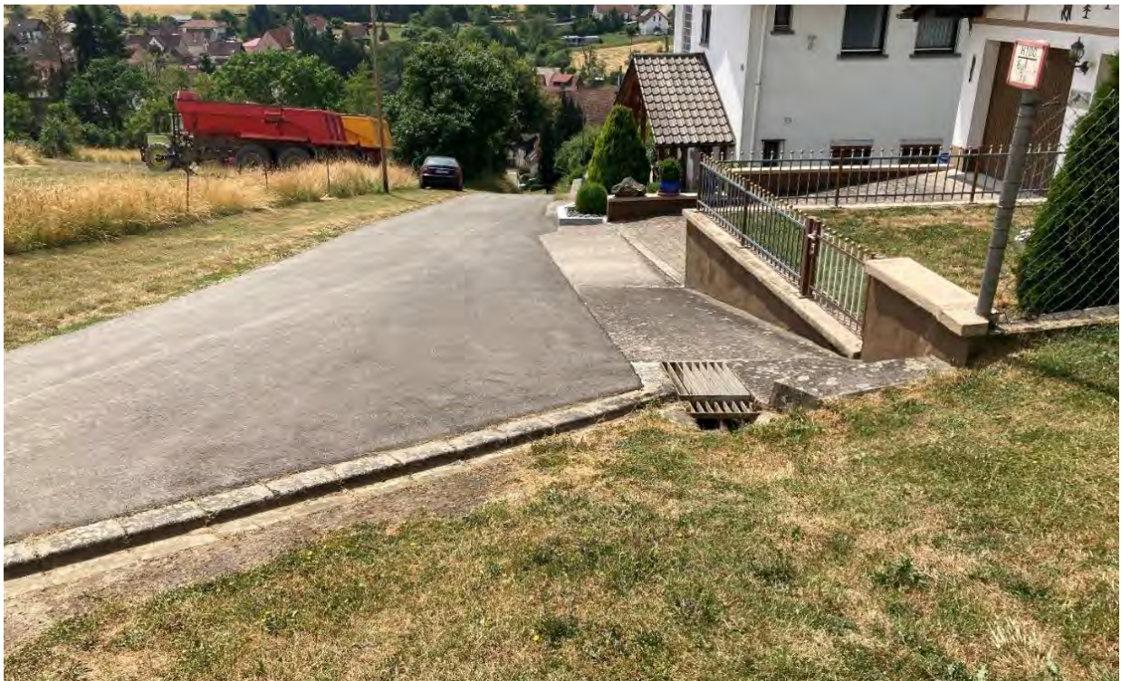
Abb. 88: Bordsteinrinne und Einlaufbauwerk zur Verrohrung am oberen Ende der Straße „Am Bornberg“
