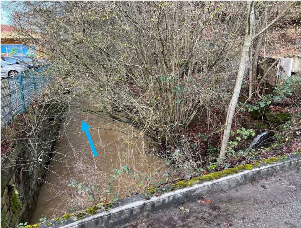
Abb. 30: Einkaufsmarkt am Odenbach unterhalb der Brücke Schorndelle, 01/2024
