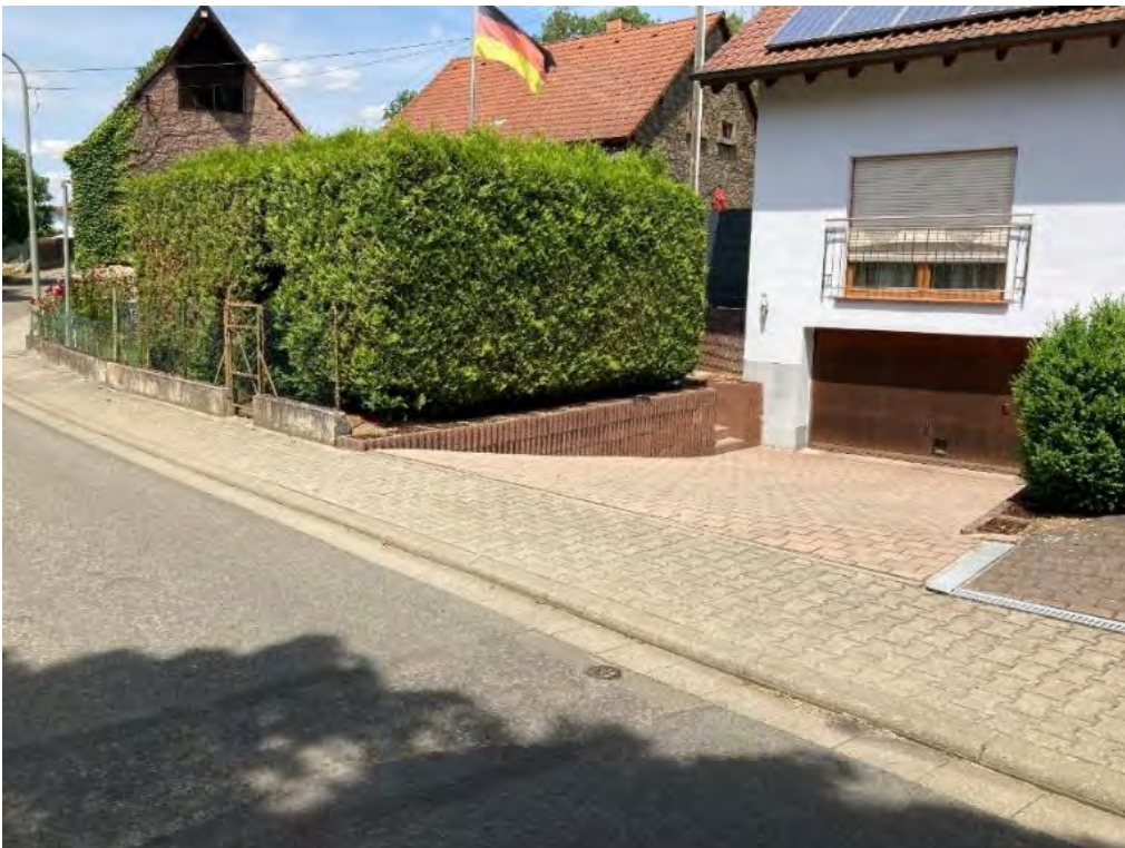
Abb. 114: Beispiel für überflutungsgefährdete Garage in der Brunnenstraße
