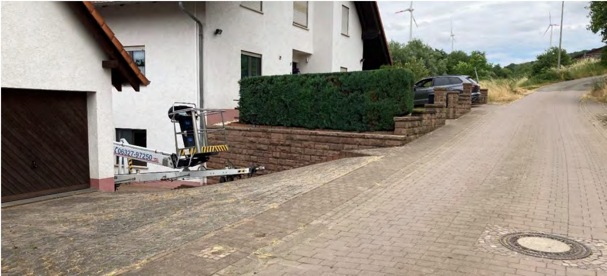
Abb. 151: Beispiel für überflutungsgefährdetes Gebäude in der Bergstraße
