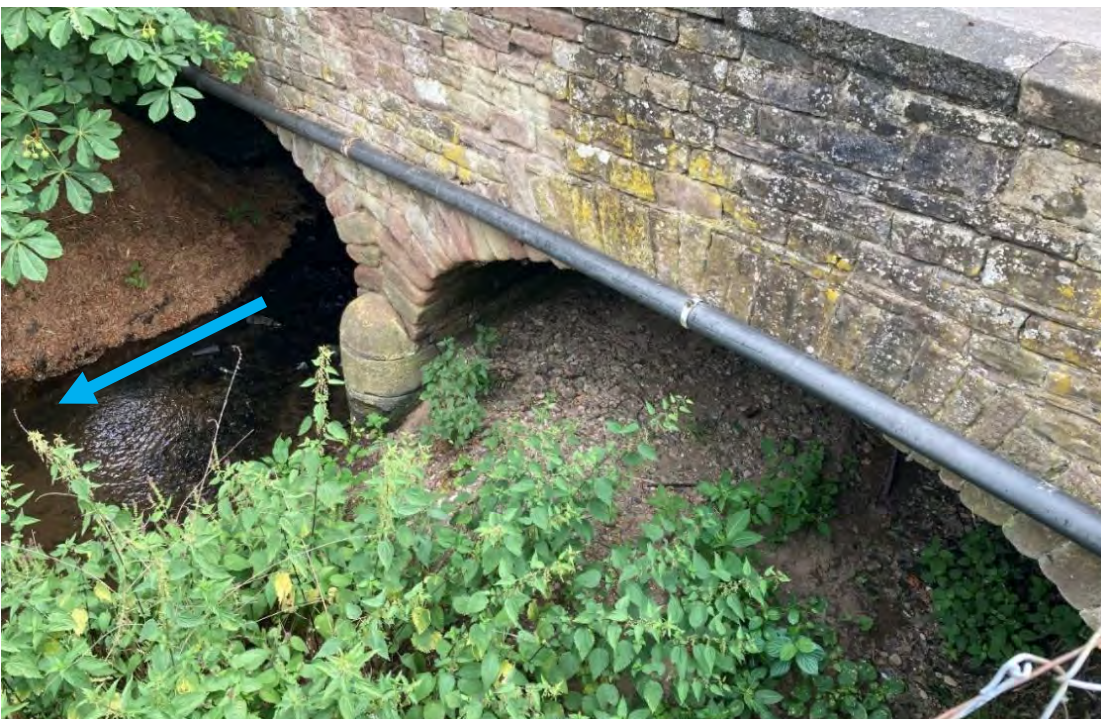
Abb. 51: Bogenbrücke Schulstraße über den Odenbach
