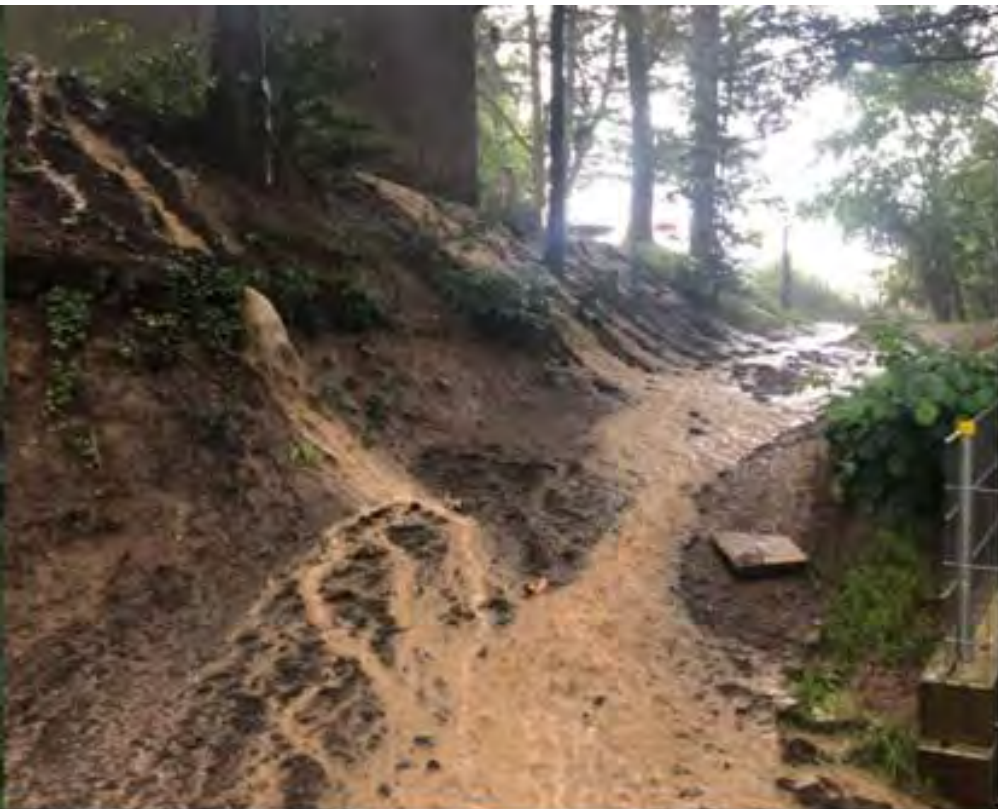
Abb. 93: Sturzflut auf die Hebelstraße am 16.07.2021, Foto: Anlieger
