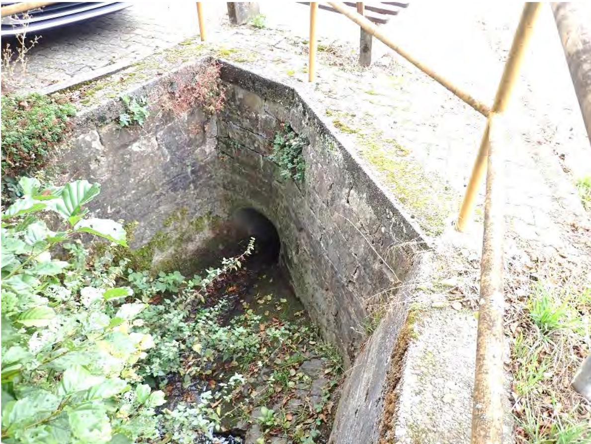
Abb. 163: Beginn der Elsbachverrohrung in der Straße „Am Steinhübel“
