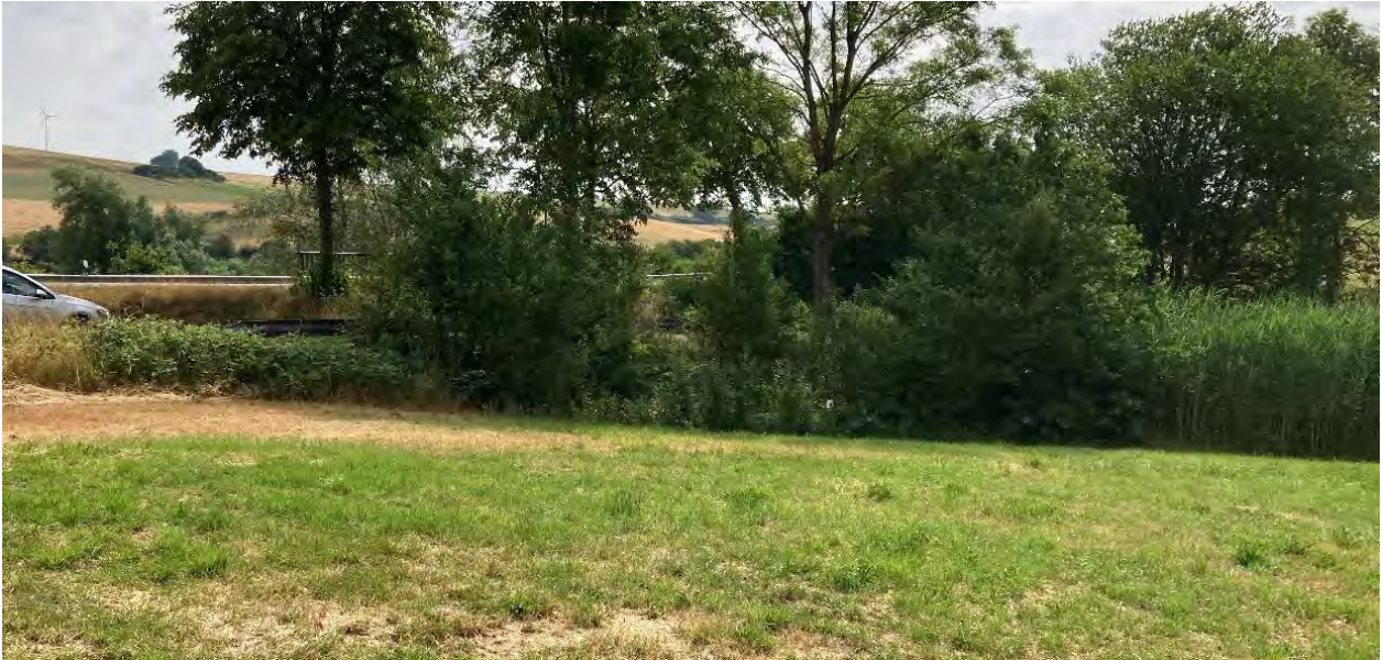
Abb. 69: Hochwasserrückhaltebecken an der L 382 im Hauptschluss des Neuhöfer Bachs
