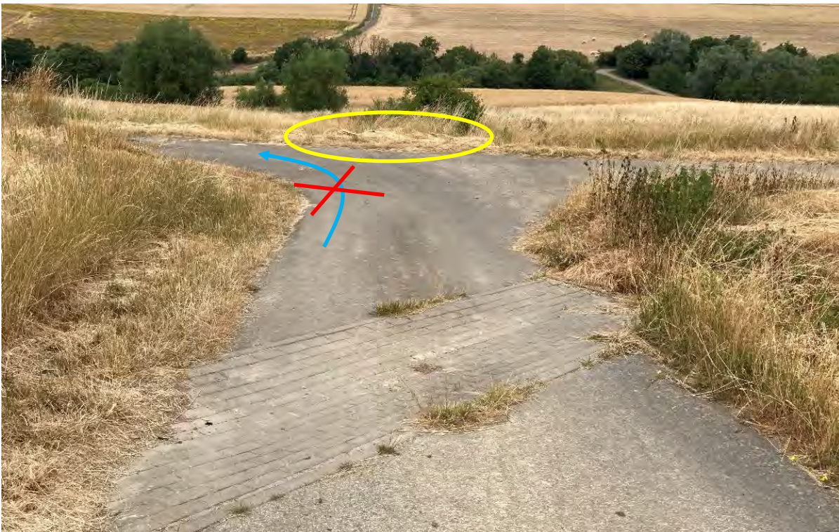
Abb. 147: Querrinne und potenzieller Abflussweg am Wegabzweig
