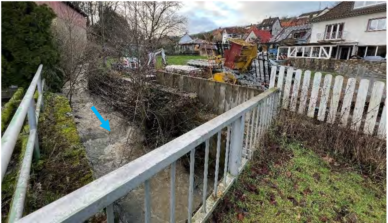
Abb. 182: Weilerbach oberhalb der Talstraße
