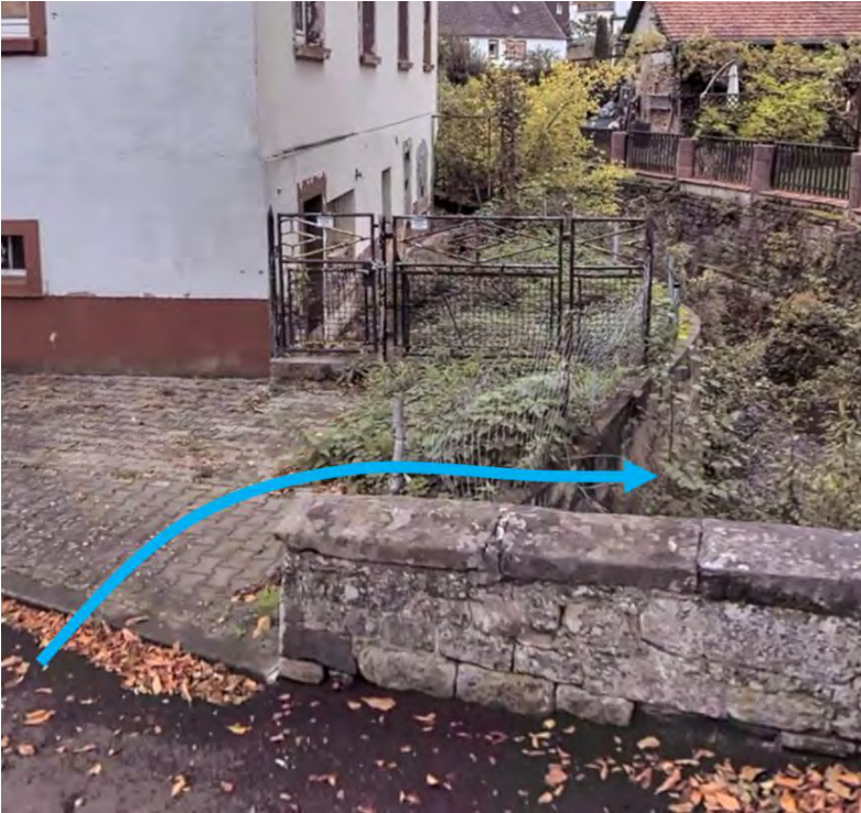
Abb. 56: Potenzieller Notabflussweg von der Schulstraße in den Odenbach
