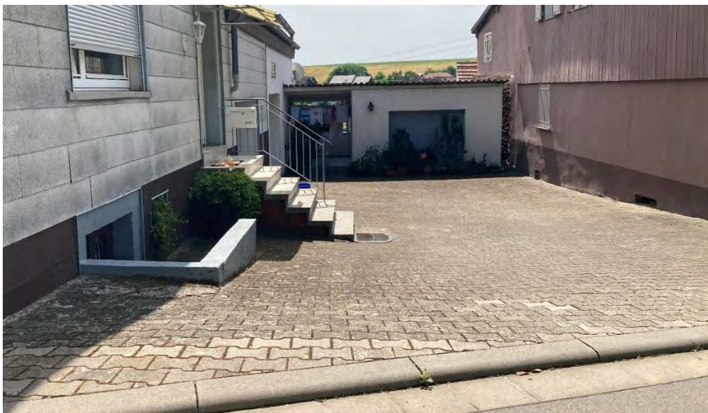
Abb. 94: Beispiele für potenziell überflutungsgefährdete Bebauung in der Hebelstraße
