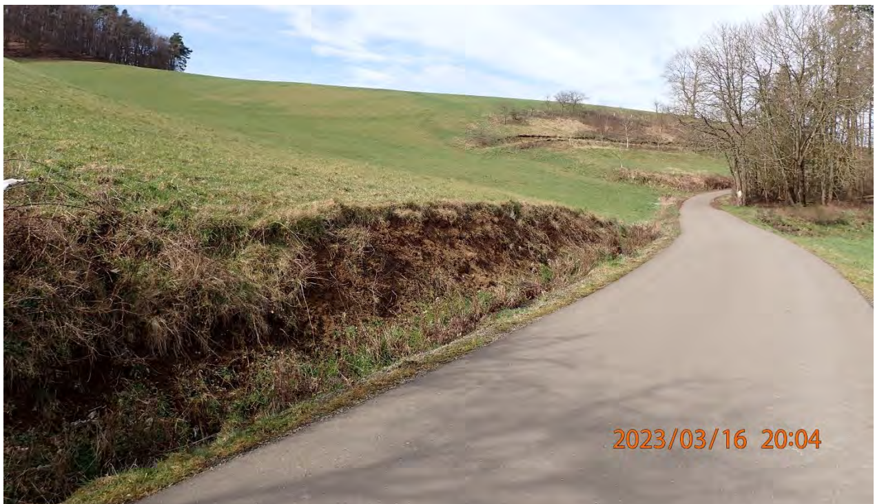
Abb. 60: Einzugsgebiet zur Kirchstraße
