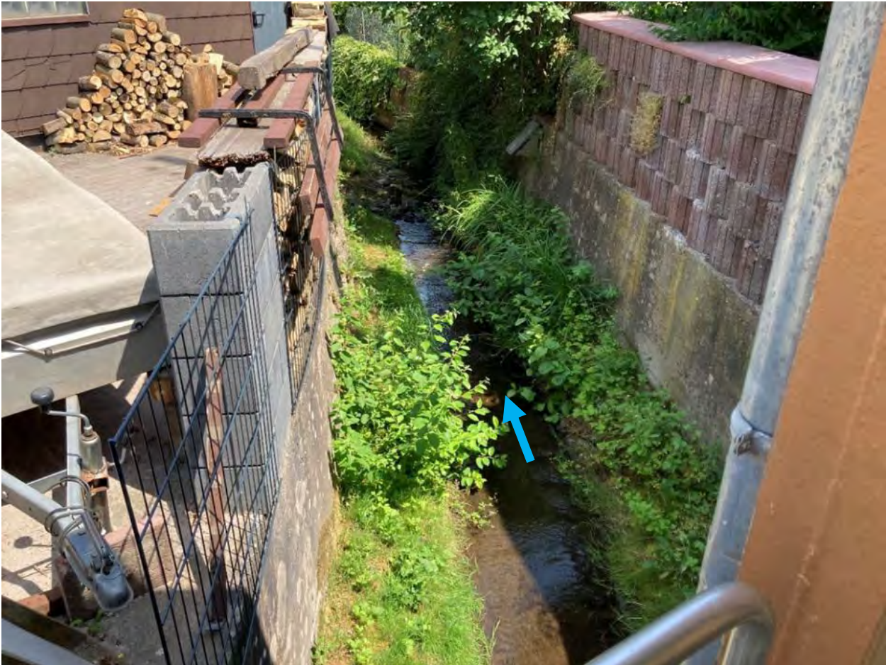
Abb. 183: Weilerbach nach Querung der Talstraße
