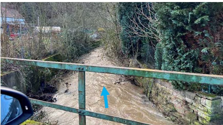
Abb. 58: Odenbach im Bereich der unteren Schulstraße bei leichtem Hochwasser 01/2024
