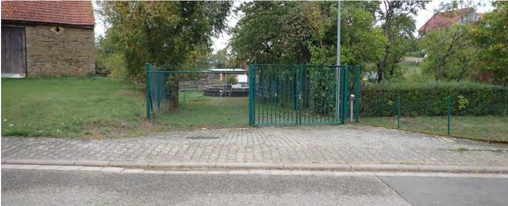
Abb. 207: Überflutungsgefährdetes Gelände am RÜB im Abstrom des Weihers
