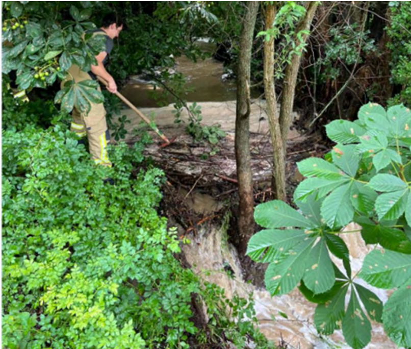
Abb. 155: Hochwasser im Bornbach bei Starkregen am 16.07.2021, Foto: Feuerwehr
