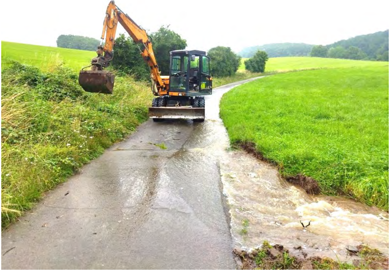
Abb. 162: Sofortmaßnahme 2003, Querschlag vom Weg zum Becken, Foto: Feuerwehr
