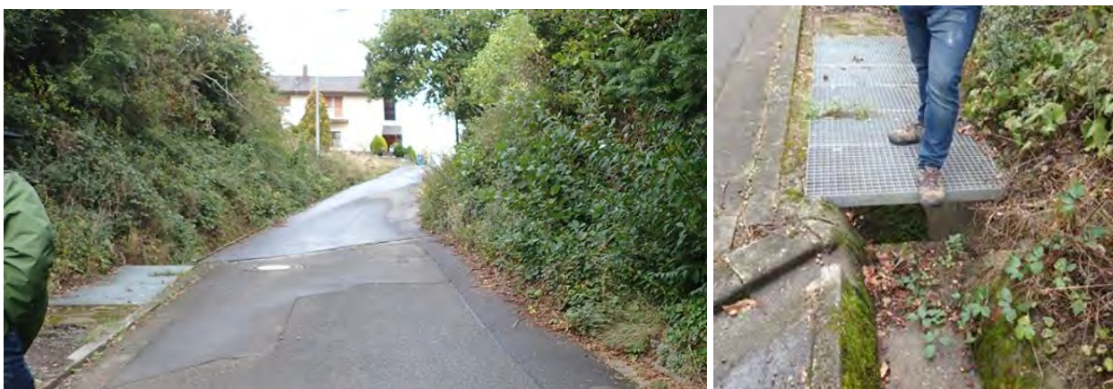
Abb. 89: Sandfang mit Querrinne in der Straße „Am Bornberg“
