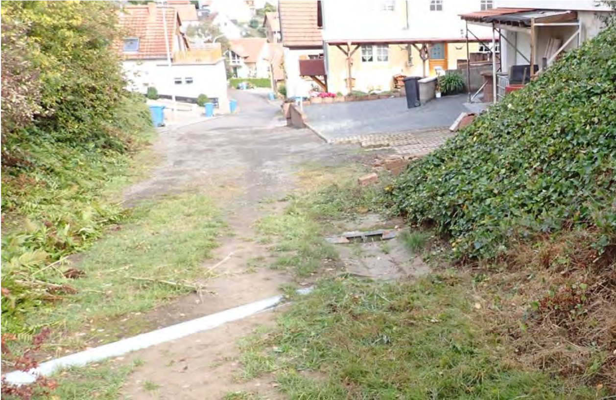
Abb. 79: Querrinne und Straßenablauf im Weg oberhalb der Eckstraße
