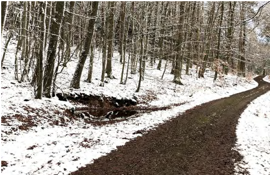
Abb. 8: Beispiel für einen Kleinrückhalt als Sickermulde neben einem Waldweg
