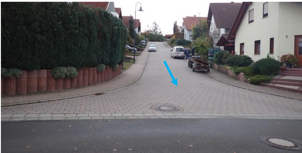
Abb. 53: Einmündung der Straße „Am Wildmannsacker“ auf die Kirchgasse
