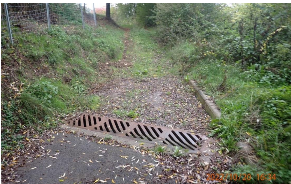
Abb. 16: Querrinne am Übergang des unbefestigten Weges auf den befestigten
