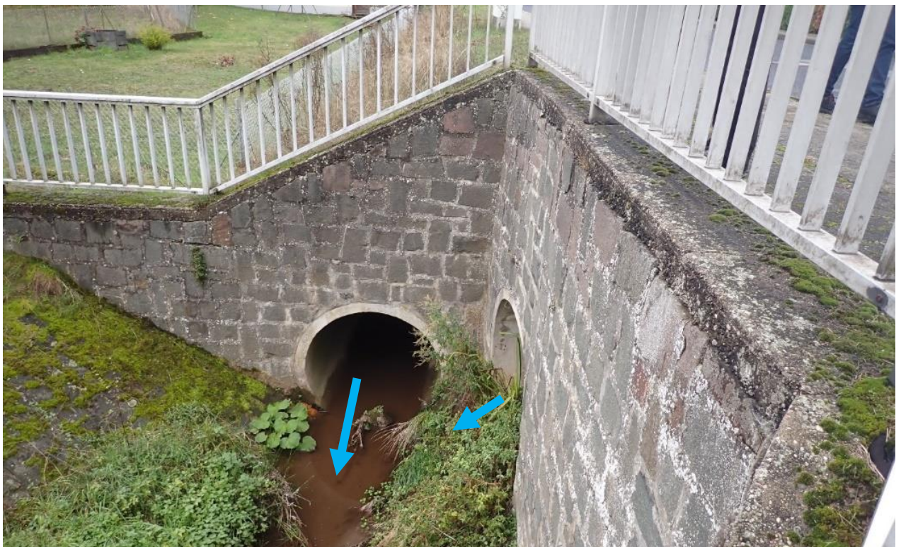
Abb. 36: Auslauf aus der Moschelbachverrohrung neben der Hauptstraße und Zufluss des namelosen Flutgrabens vom Heimkirchner Berg
