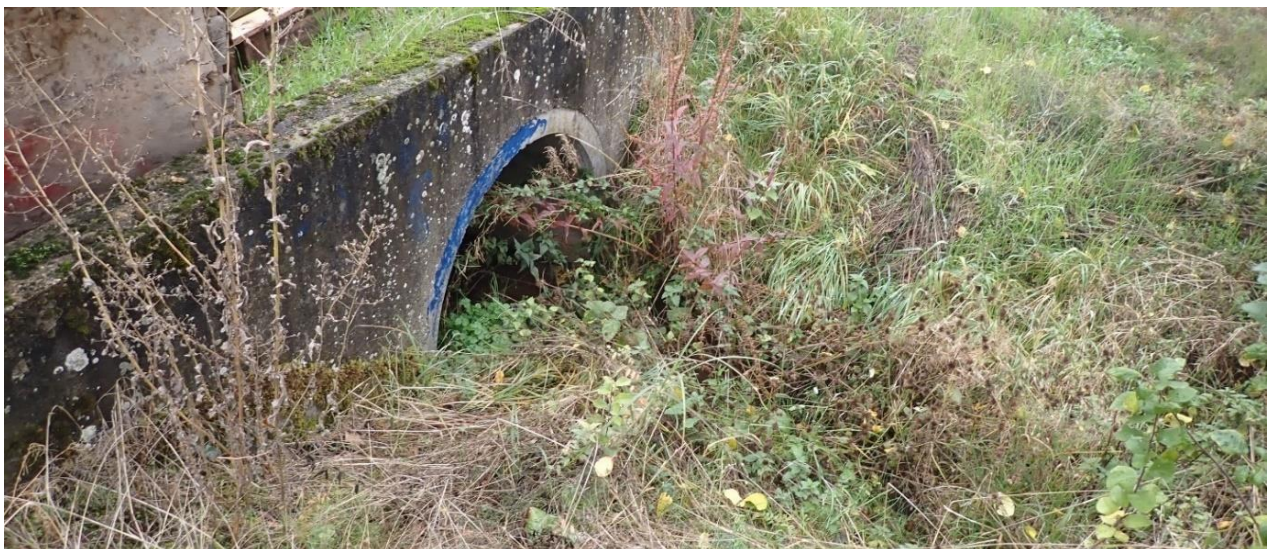
Abb. 40: Auslauf der Pfaffenbachverrohrung
