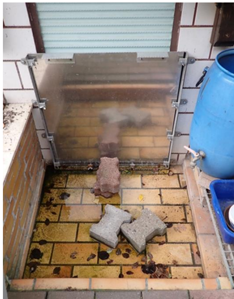
Abb. 19: Dammbalkenverschluss (links) und Schott (rechts)
