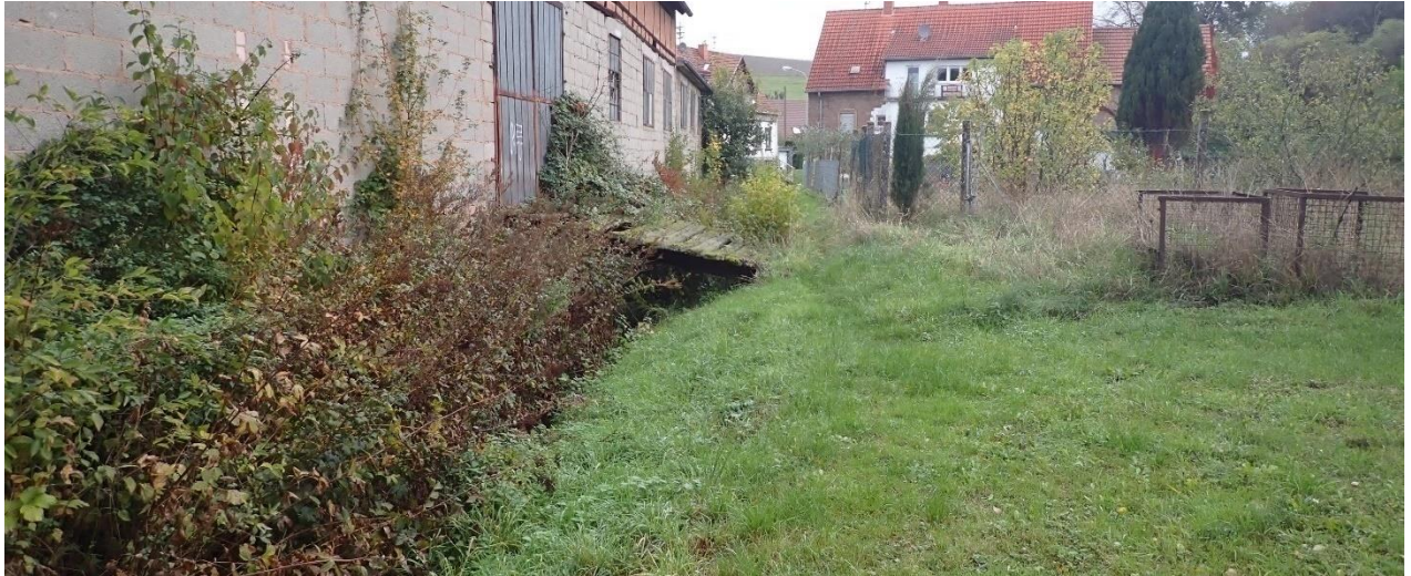
Abb. 35: Bebauung am Moschelbach mit ungenutztem Steg
