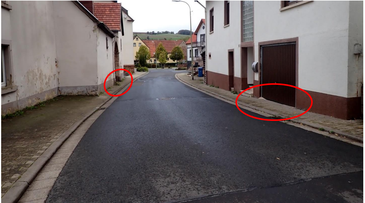
Abb. 32: Tiefliegende Gebäudeöffnungen im überflutungsgefährdeten Bereich
