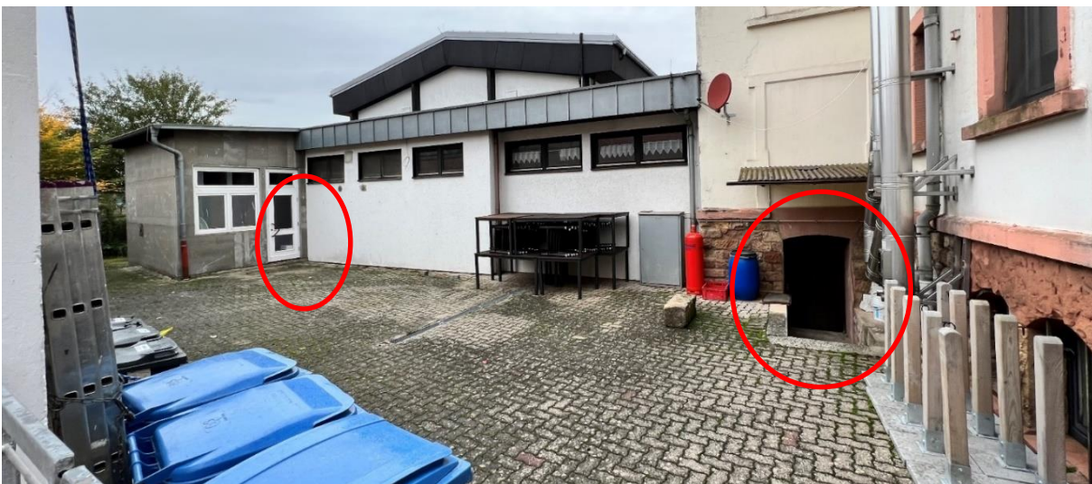
Abb. 27: Überflutungsgefährdete Gebäudeöffnungen der Mehrzweckhalle
