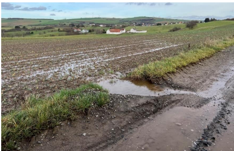
Abb. 6: Beispiel aus Schallodenbach für Querentwässerung in die Fläche durch Öffnen des Banketts
