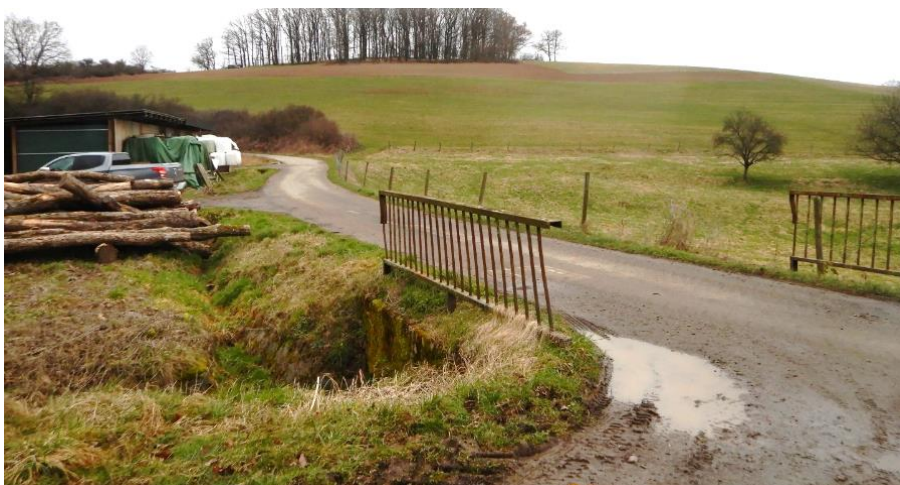
Abb. 47: Durchlass im Weg in Verlängerung der Bergstraße und Wegseitengraben von Norden
