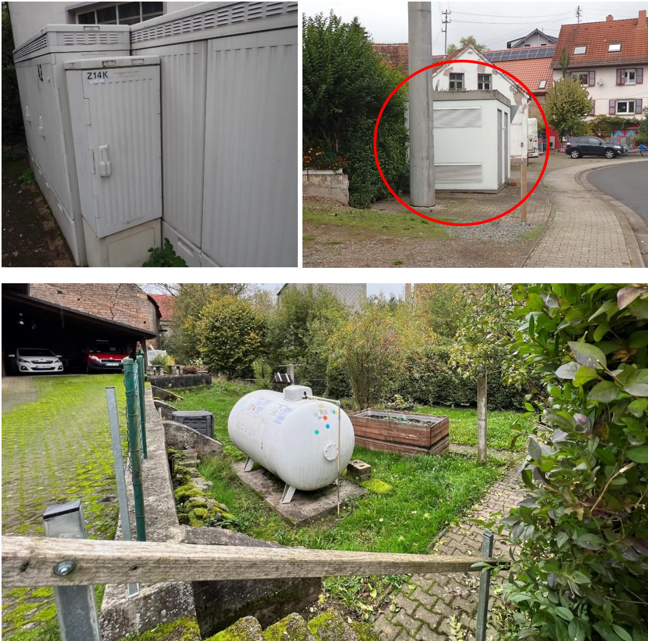
Abb. 44: Kritische Infrastruktur am Pfaffenbach im überflutungsgefährdeten Bereich
