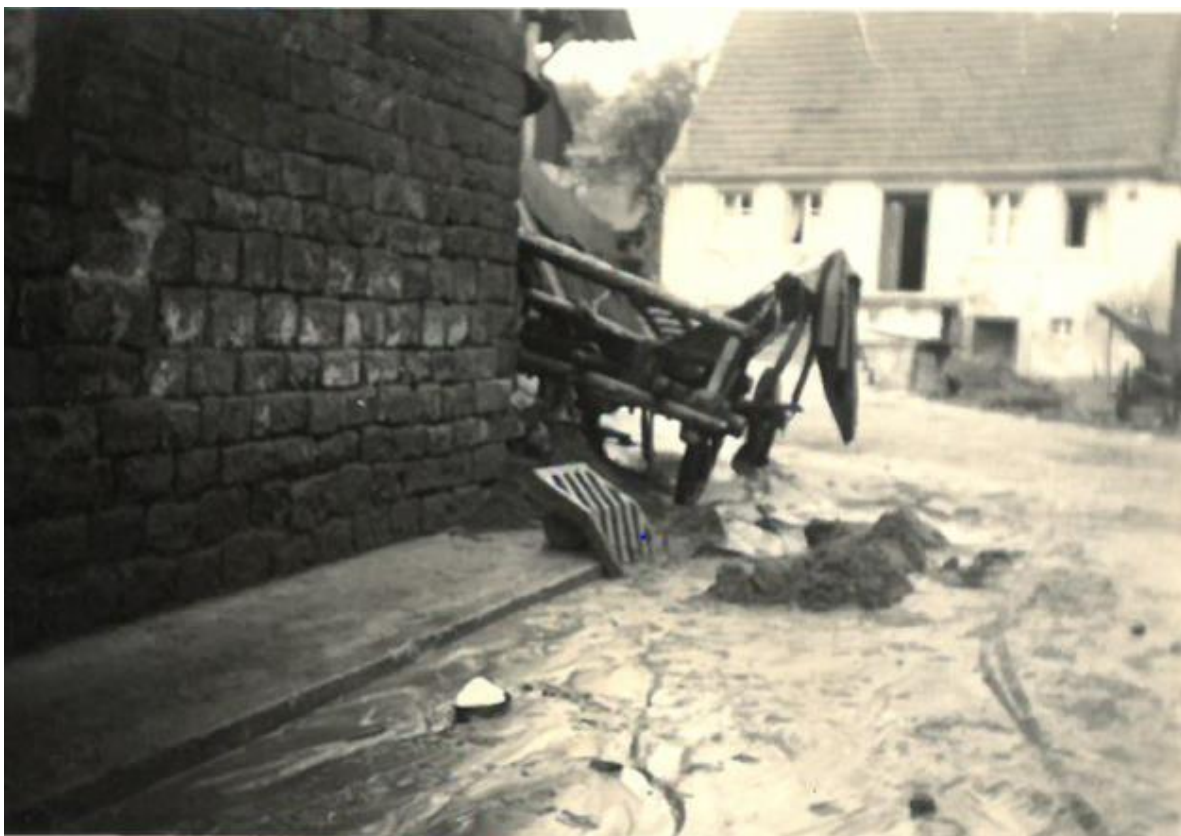
Abb. 91: Überflutung der Hauptstraße nach Gewitter 1965, Foto: Gehm
