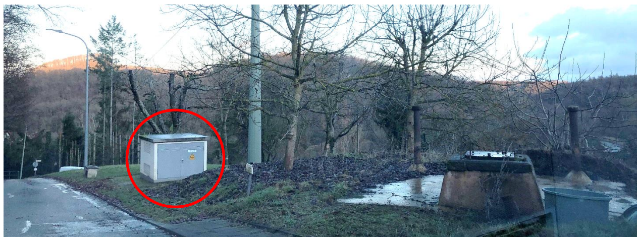
Abb. 108: Überflutungsgefährdete Hebelstraße mit Trafostation
