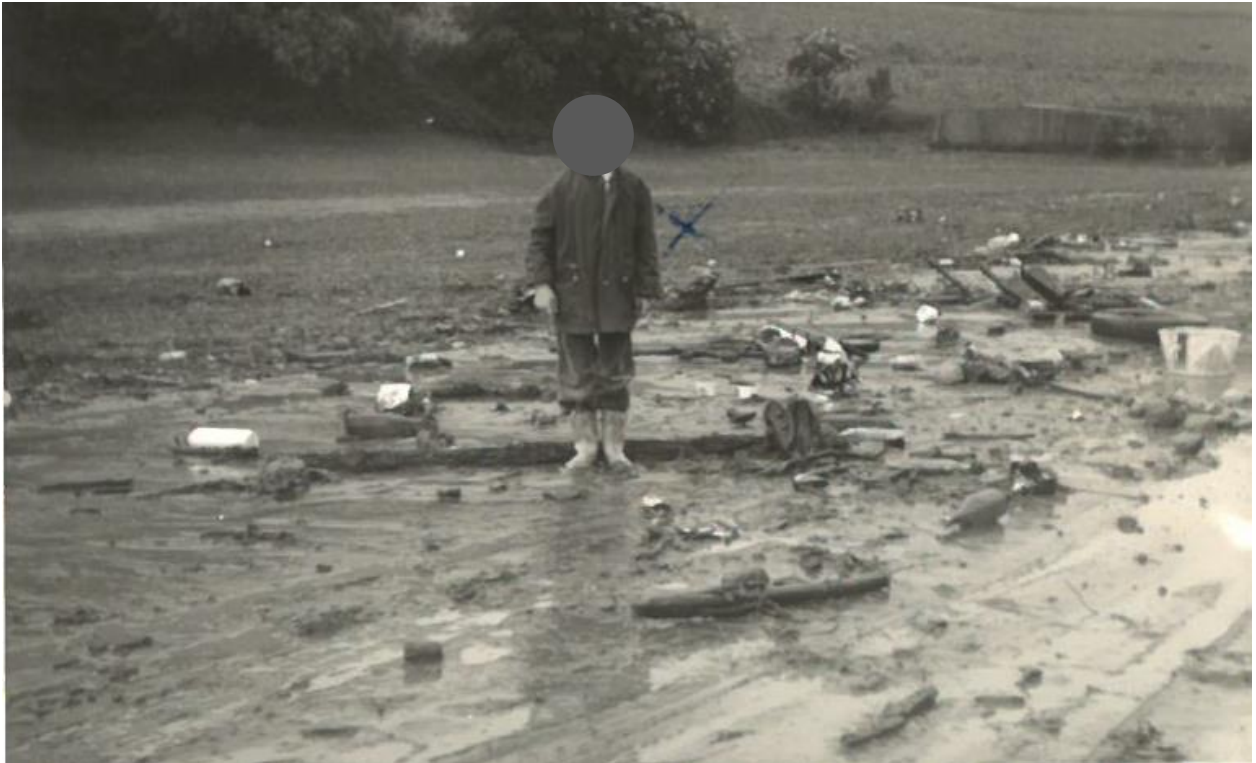
Abb. 78: Schadensbild nach Hochwasser 1975, Foto: Gehm
