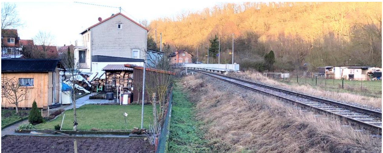
Abb. 29: Lagerung beweglicher Materialien im gesetzlich ausgewiesenen Überschwemmungsgebiet
