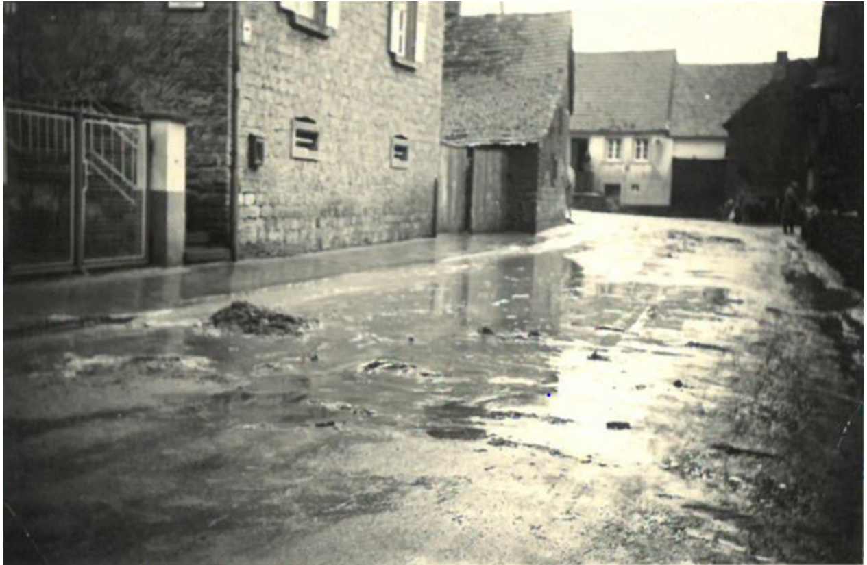
Abb. 97: Überschwemmung der Hauptstraße nach Gewitter 1965, Foto: Gehm
