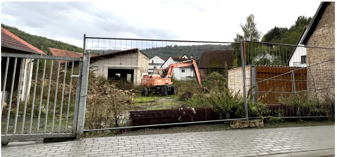
Abb. 88: Geländeauffüllung im natürlichen Retentionsraum
