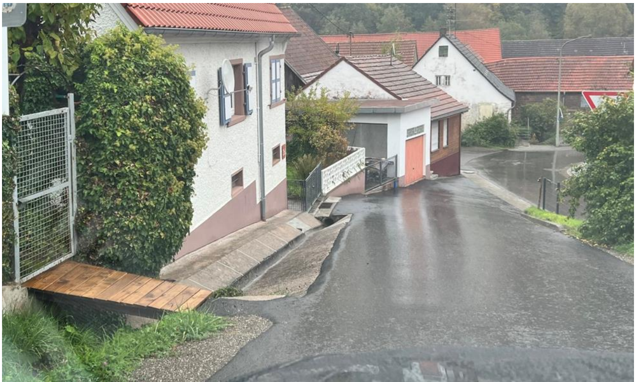
Abb. 94: Querrinne und Seitengraben im und am Weg vom Friedhof zur Hauptstraße
