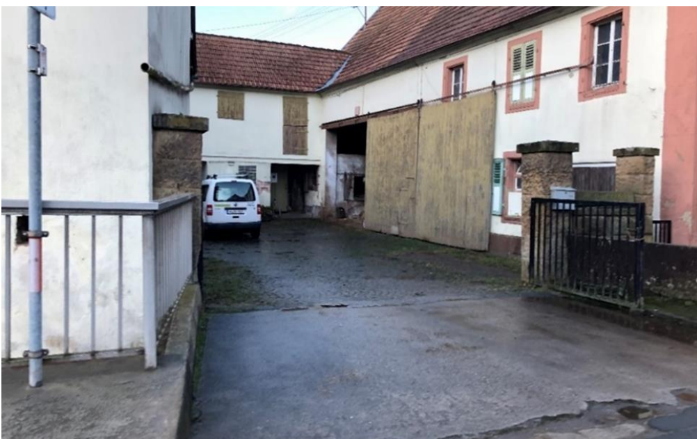
Abb. 39: Überflutungsgefährdete Bebauung am Sulzbach
