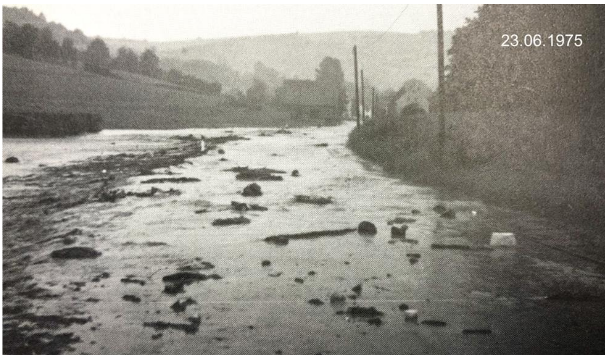
Abb. 77: Schadensbild nach Sulzbachhochwasser 1975, Foto: Gehm
