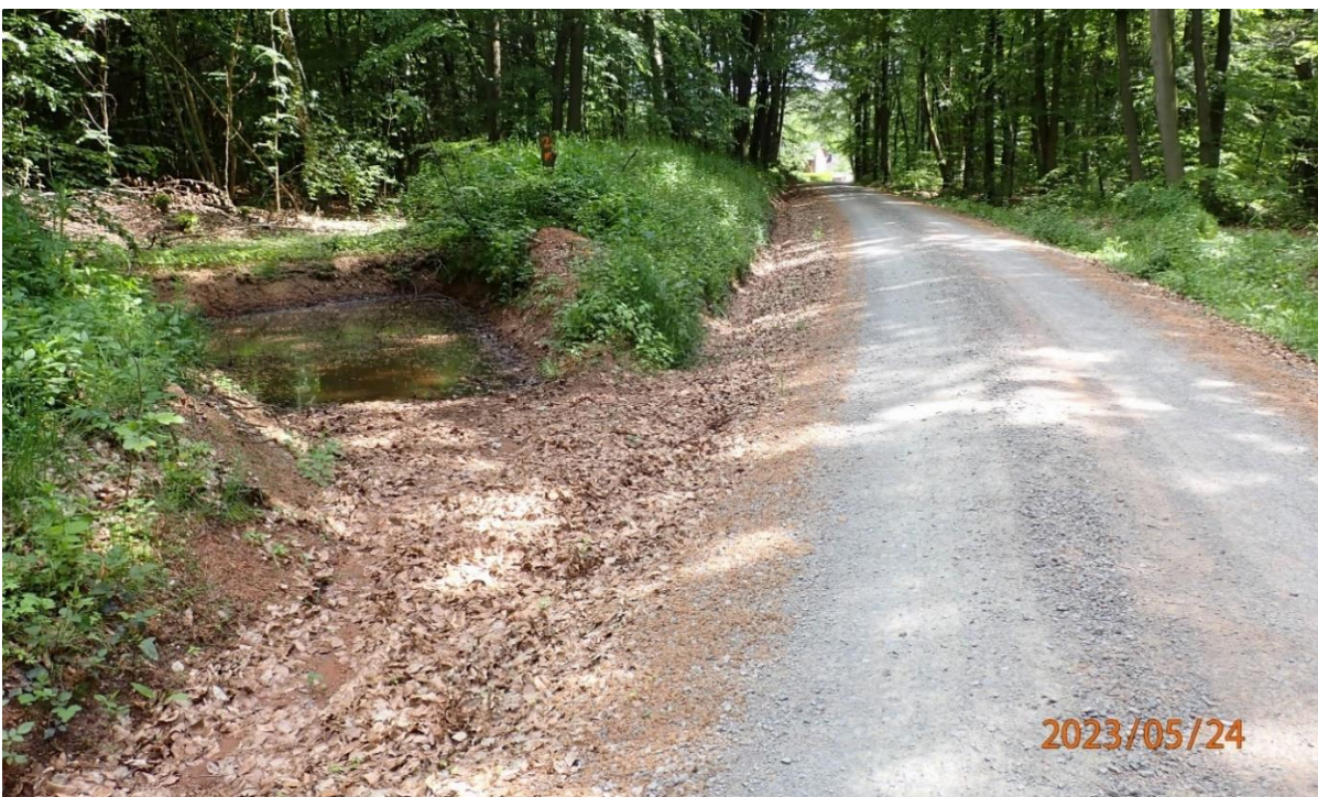
Abb. 12: Beispiele für querentwässerte Waldwege, oben in die Fläche, unten in Kleinrückhalt
