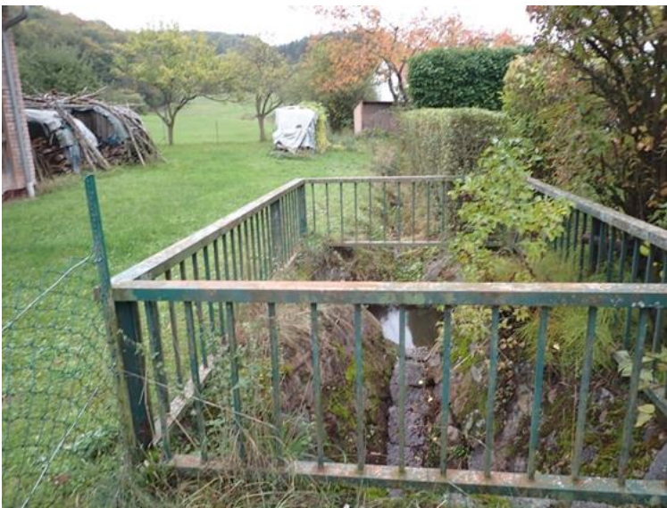
Abb. 75: Sandfang und Zulaufbauwerk zur Verrohrung als kritische Engstelle
