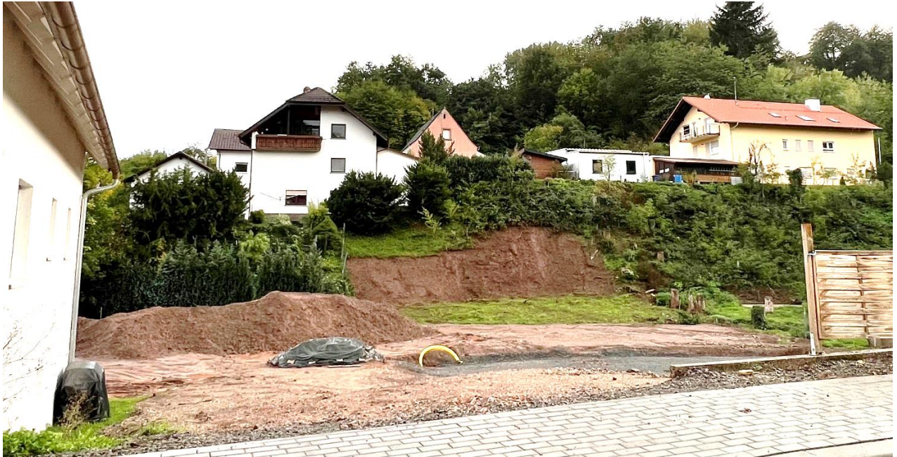
Abb. 87: Grundstücksvorbereitung für Neubau im überflutungsgefährdeten Bereich, Stand 2022
