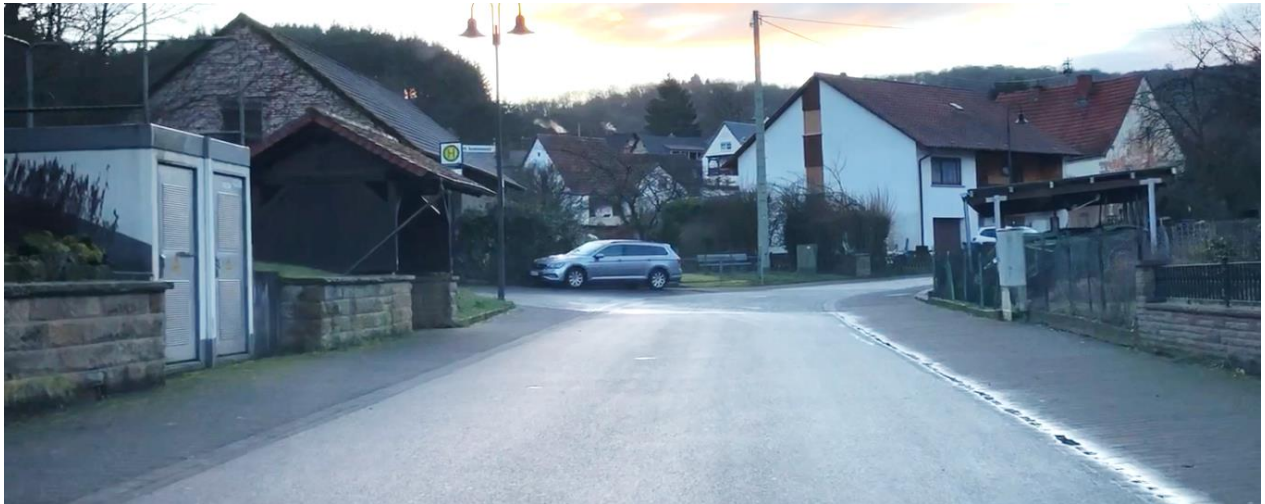
Abb. 66: Überflutungsgefährdete Trafostation in der Ortsstraße
