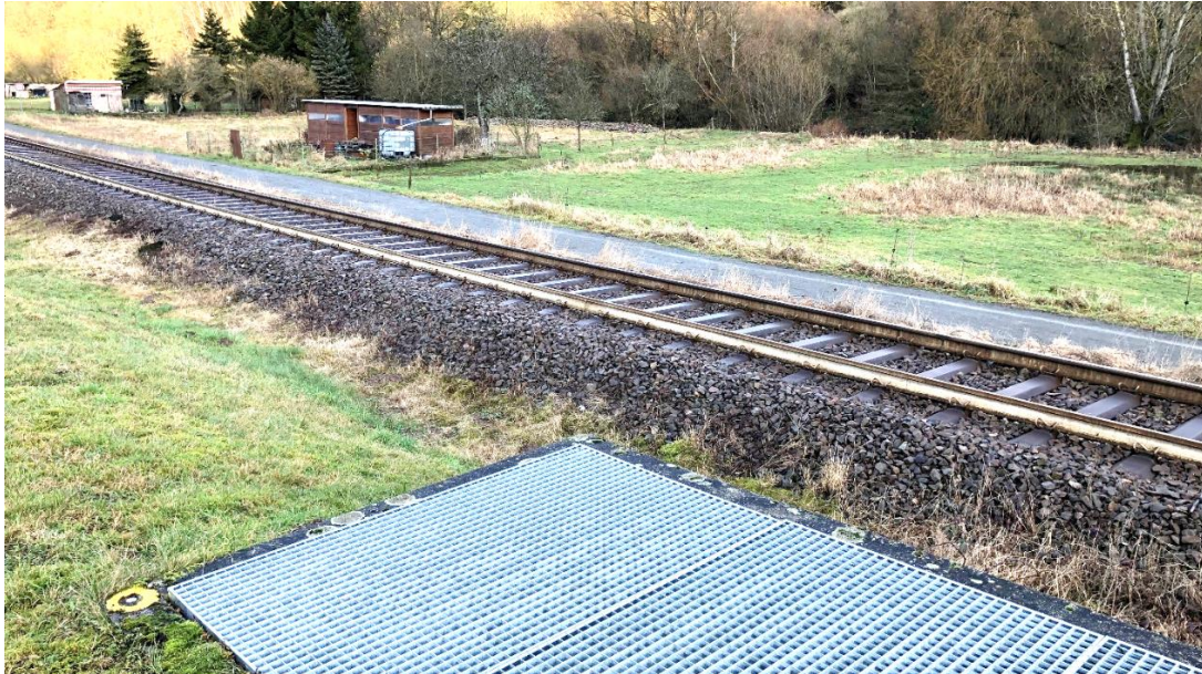
Abb. 101: Sandfang Schlanggraben und offener Graben zur Lauter
