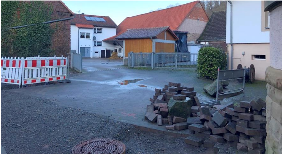
Abb. 40: Überflutungsgefährdete Bebauung an der Hauptstraße
