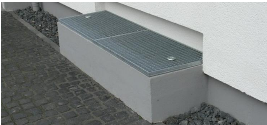
Abb. 19: Beispiel für die Sicherung eines niveaugleichen Lichtschachtes
