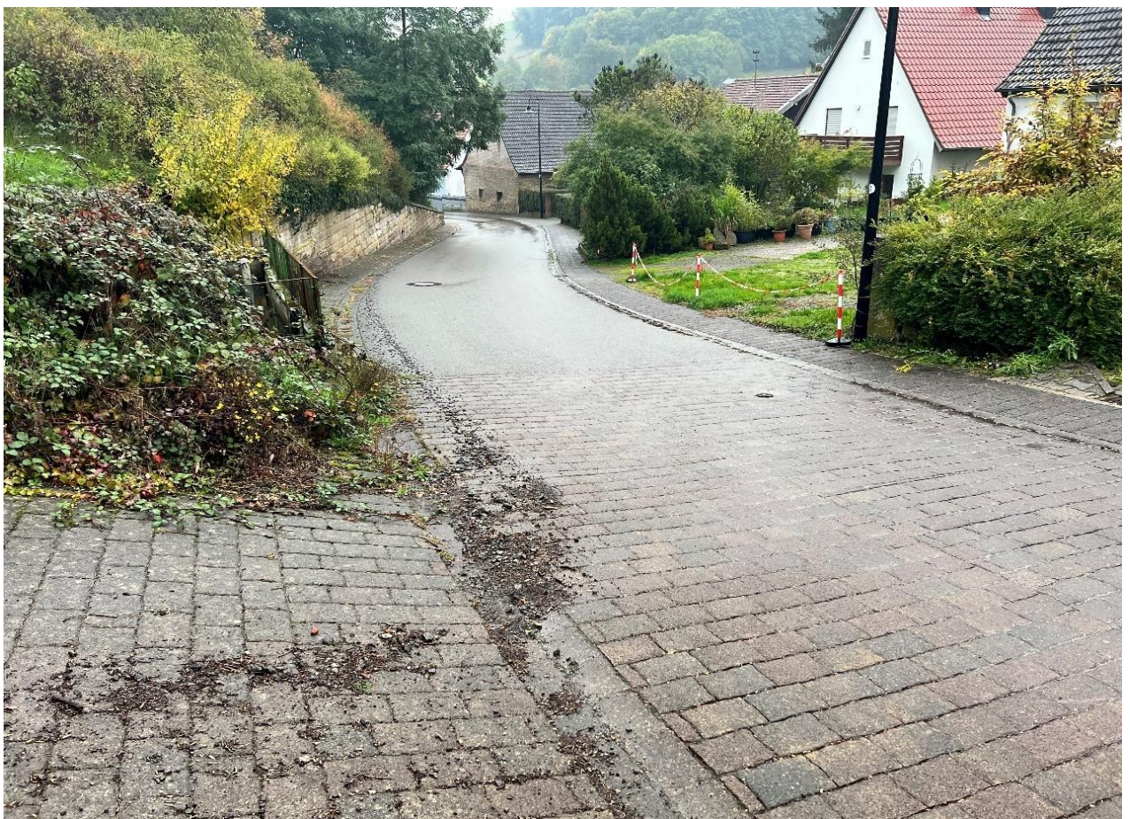
Abb. 57: Geschwemmselfahne auf der Ortsstraße nach Regen am 29.09.2022
