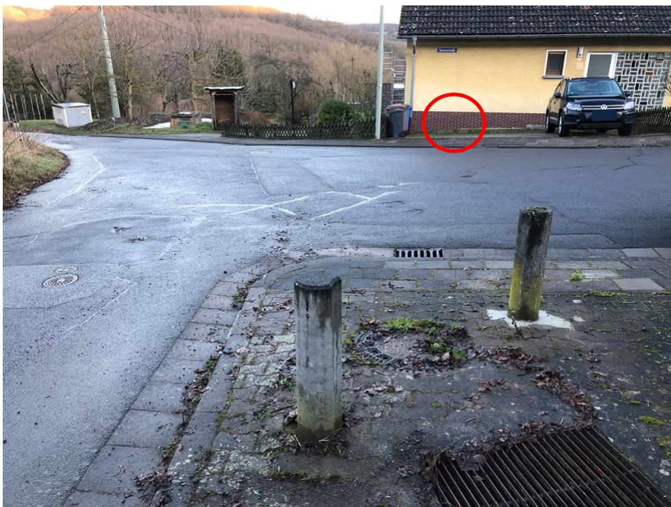
Abb. 106: Abzweig Sonnenstraße von der Hebelstraße und Einlauf Straßendurchlass
