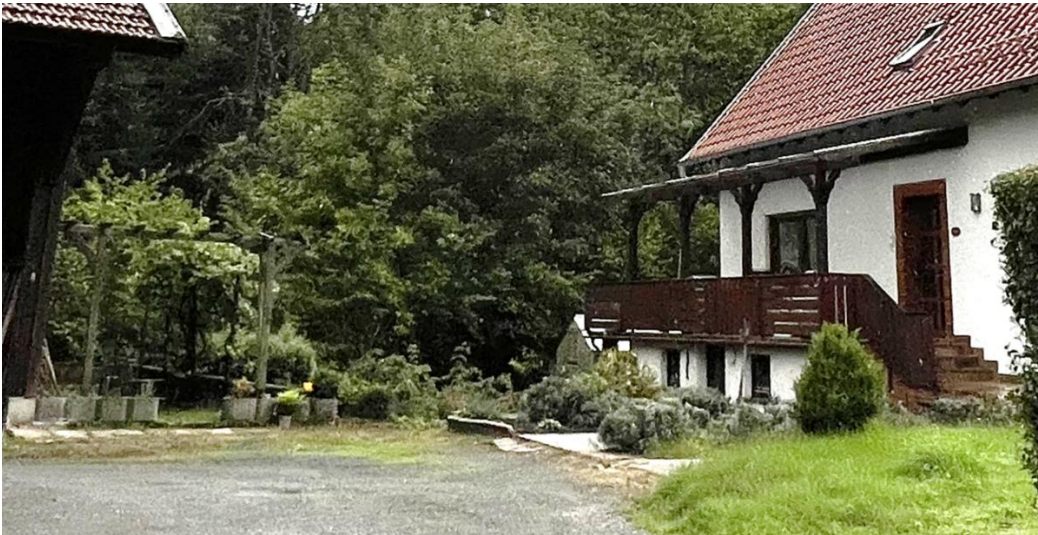
Abb. 62: Talseitige Gebäude an der Ortsstraße entlang des offenen Sulzbachs
