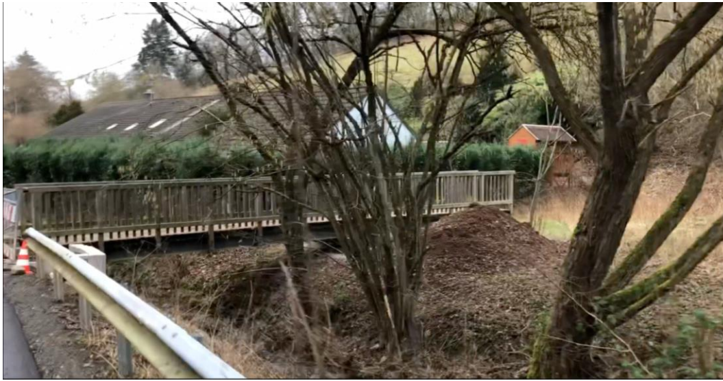
Abb. 84: Brücke am Sportplatz über den Sulzbach
