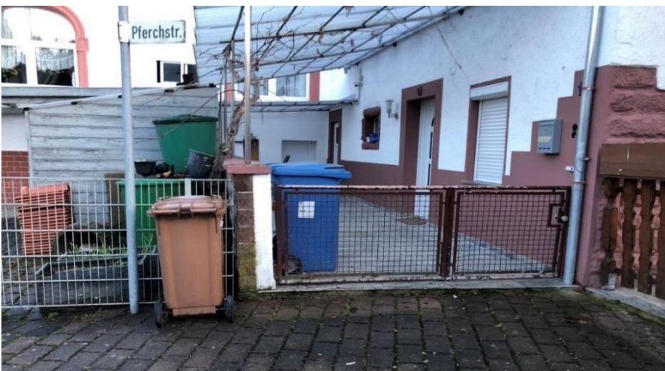
Abb. 27: Überflutungsgefährdete Gebäude in der Pferchstraße
