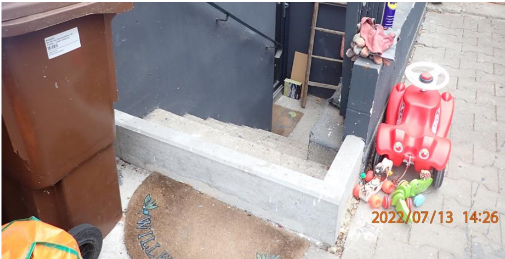
Abb. 20: Beispiel für die Sicherung eines außenliegenden Kellerzugangs
