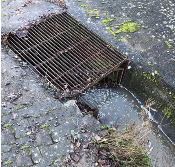
Abb. 105: Zulauf zum Straßendurchlass Sonnenstraße
