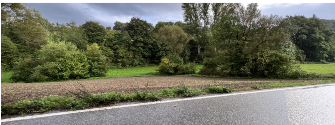
Abb. 81: Ende der Sulzbachverrohrung und offener Bachlauf
