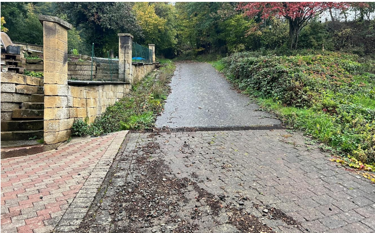
Abb. 55: Wirtschaftsweg mit Seitenrinne zu einer Verrohrung
