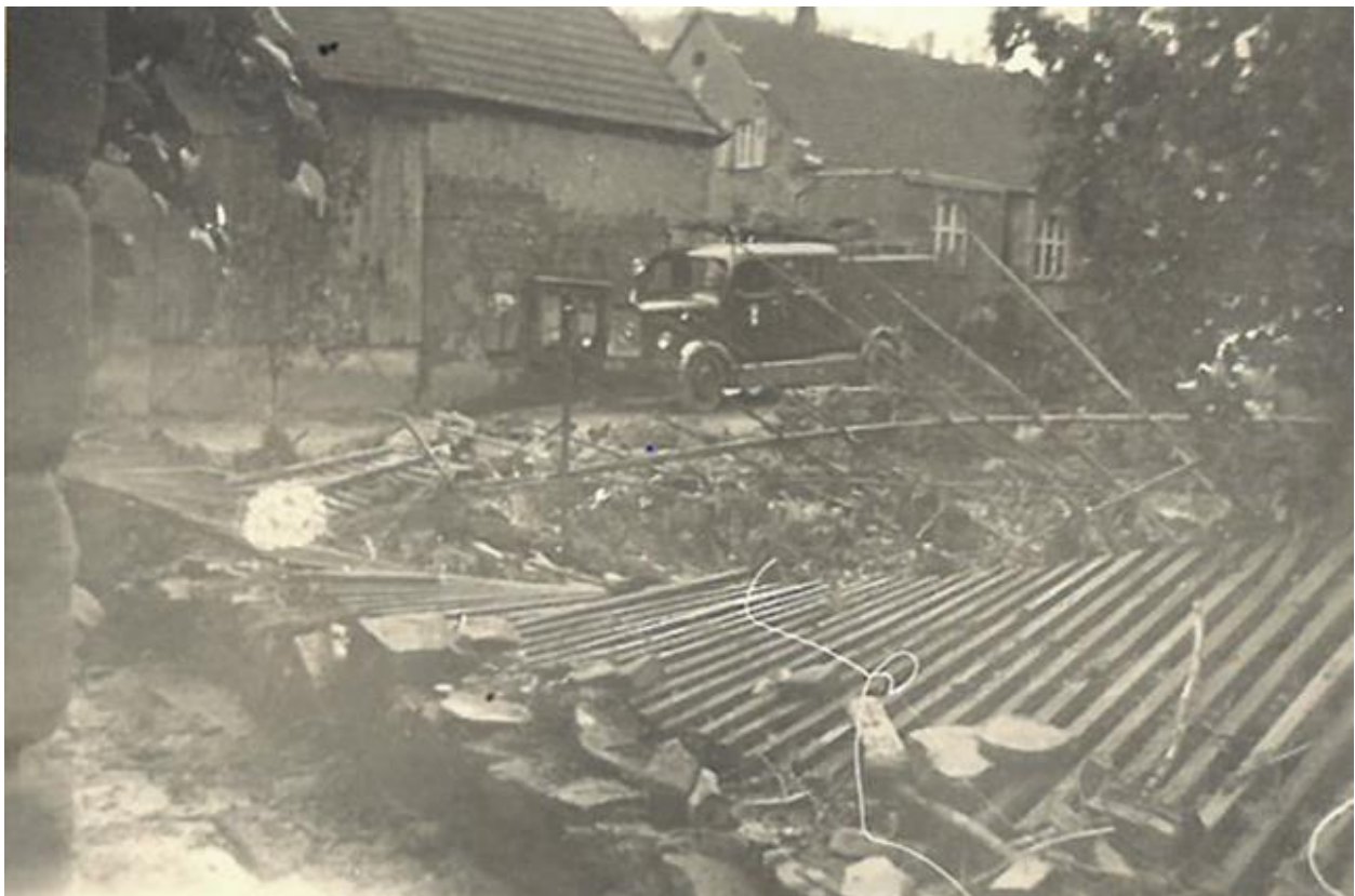
Abb. 2: Zerstörung in der Hauptstraße nach Sulzbachhochwasser am 24.06.1953, Foto: Gehm
