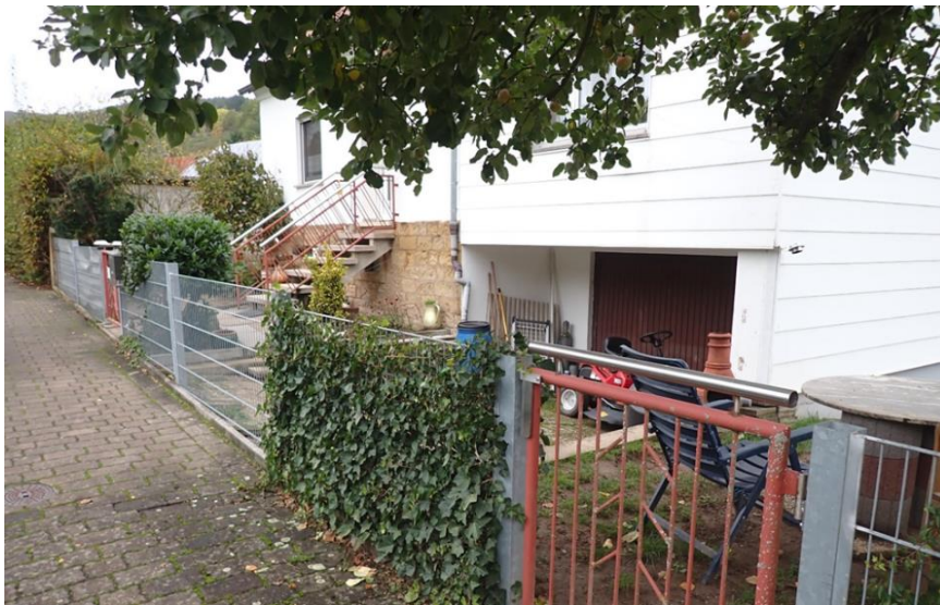
Abb. 73: Überflutungsgefährdetes Wohnhaus in der Schulstraße
