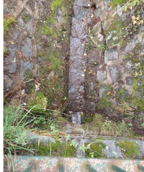
Abb. 75: Sandfang und Zulaufbauwerk zur Verrohrung als kritische Engstelle
