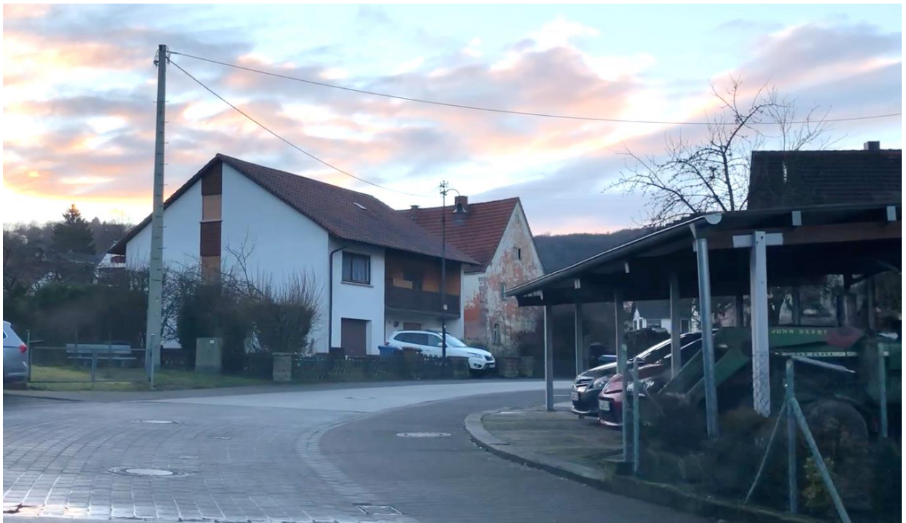
Abb. 76: Überflutungsgefährdete Gebäude an der Ortsstraße
