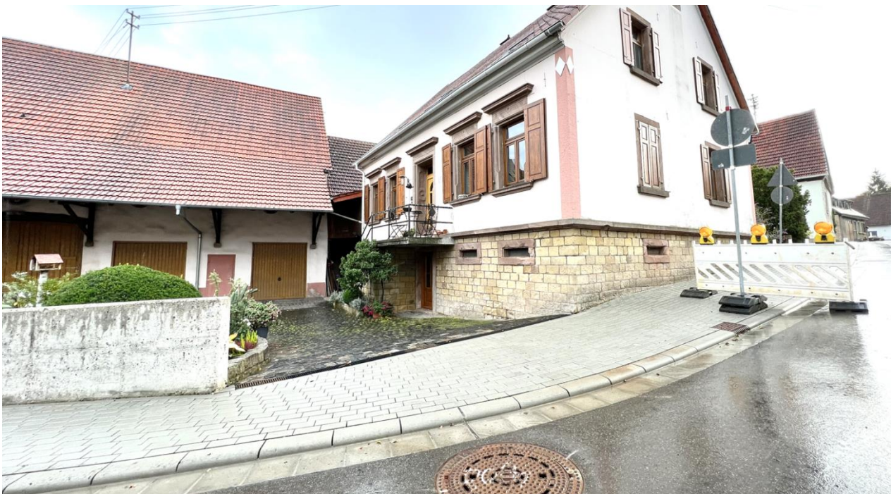
Abb. 96: Potenziell überflutungsgefährdetes Anwesen in der Hauptstraße
