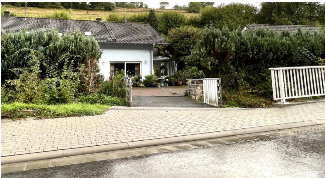
Abb. 85: Brücke als Zufahrt zu einem überflutungsgefährdeten Wohnhaus
