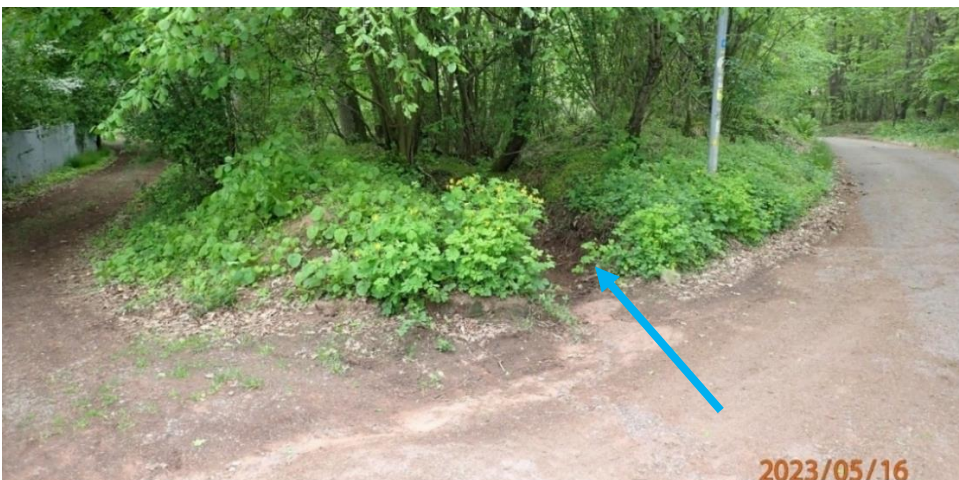
Abb. 65: Querschlag und Kleinrückhalt an der Straße „Schlossberg“
