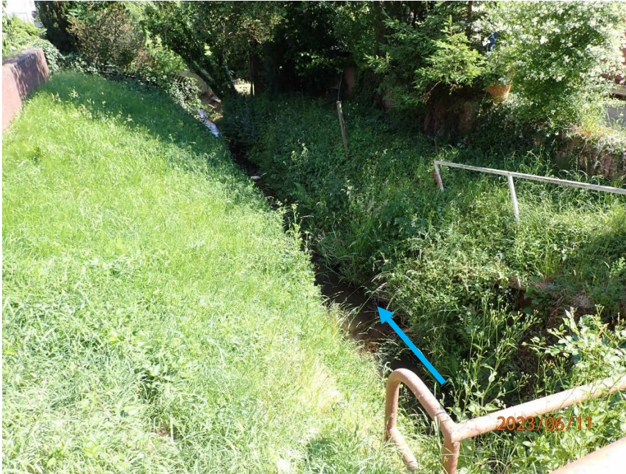
Abb. 86: Ende der Verrohrung Grafenthaler Bach an der Straße „An der Unkenbach“
