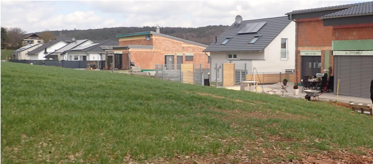
Abb. 24: Beispiel für eine extrem überflutungsgefährdete Bebauung in Hanglage, auch weil die Vorgaben des Bebauungsplans auf den Baugrundstücken nicht umgesetzt wurden
