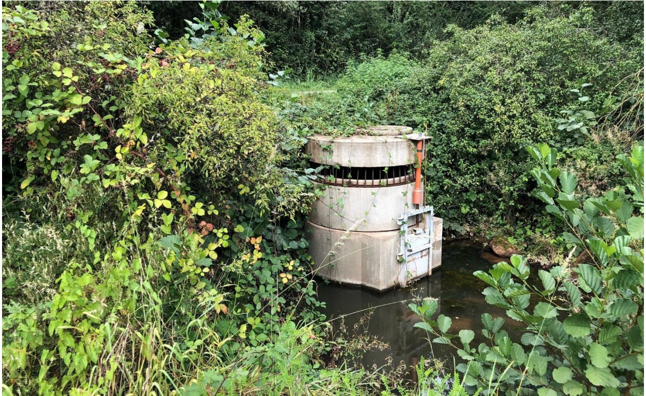
Abb. 189: Zentrales Drosselbauwerk im Rückhalte-/Versickerungsbecken
