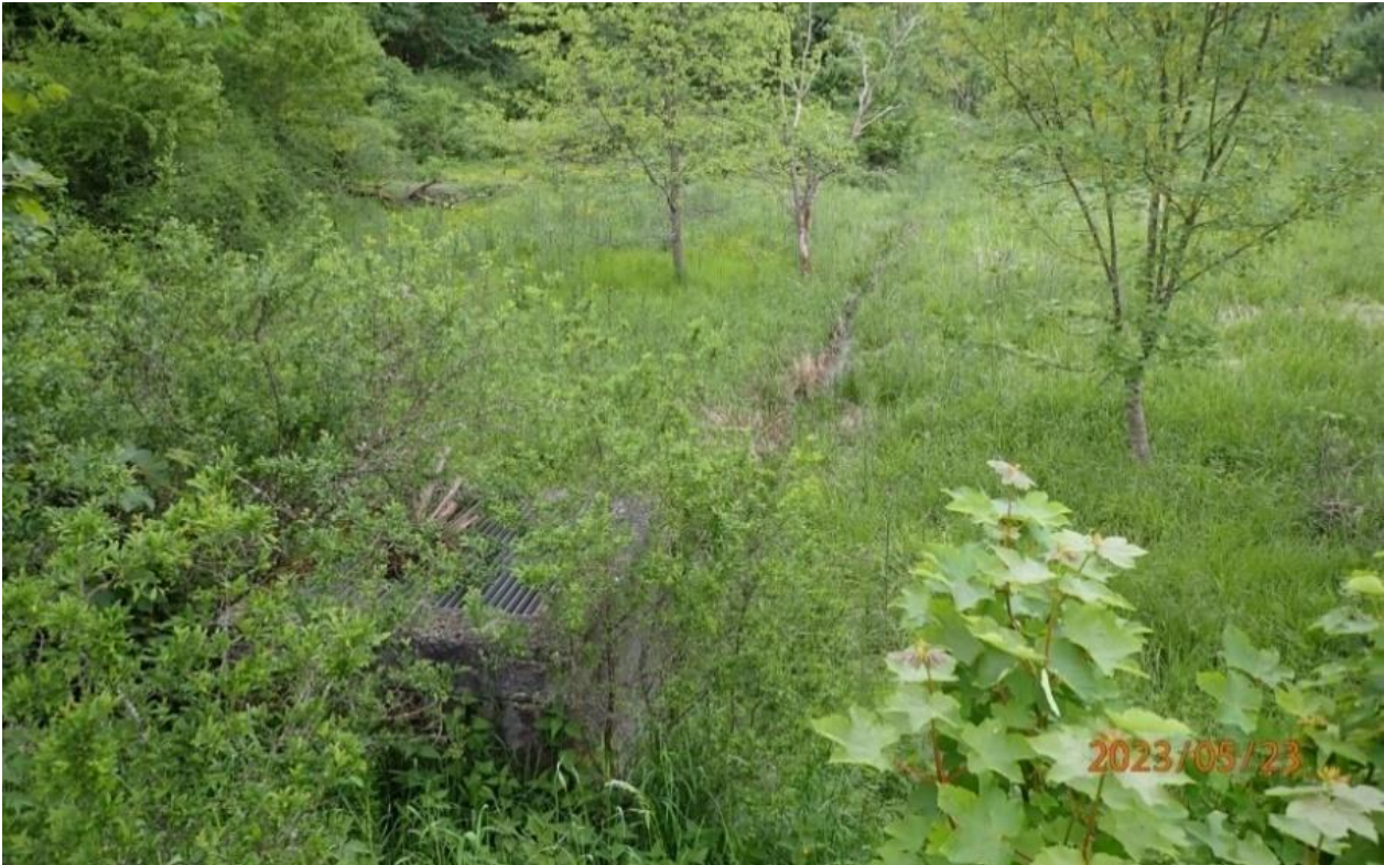
Abb. 77: Rückhaltebecken im Hauptschluss des Grafenthaler Bachs
