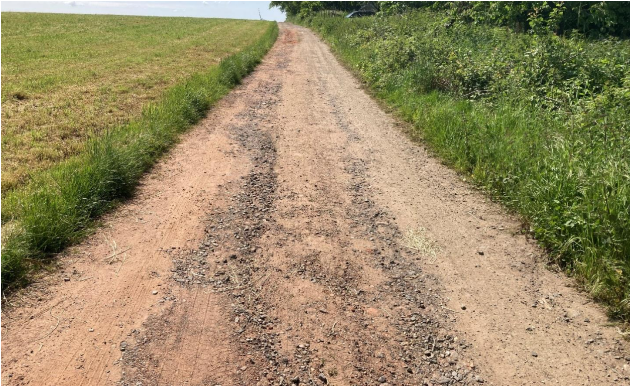
Abb. 249: Wirtschaftsweg zum Hochbehälter
