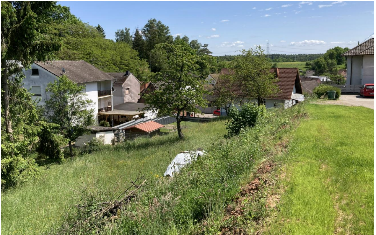
Abb. 214: Überflutungsgefährdete Bebauung im Amseltal
