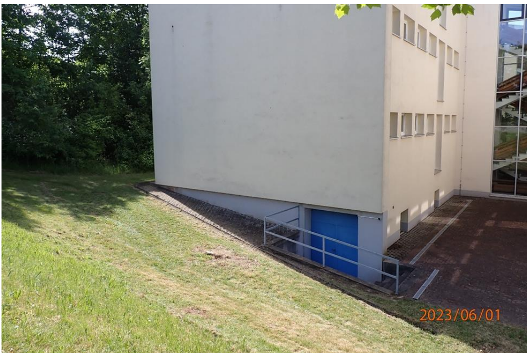
Abb. 136: Überflutungsgefährdete Gebäude der IGS
