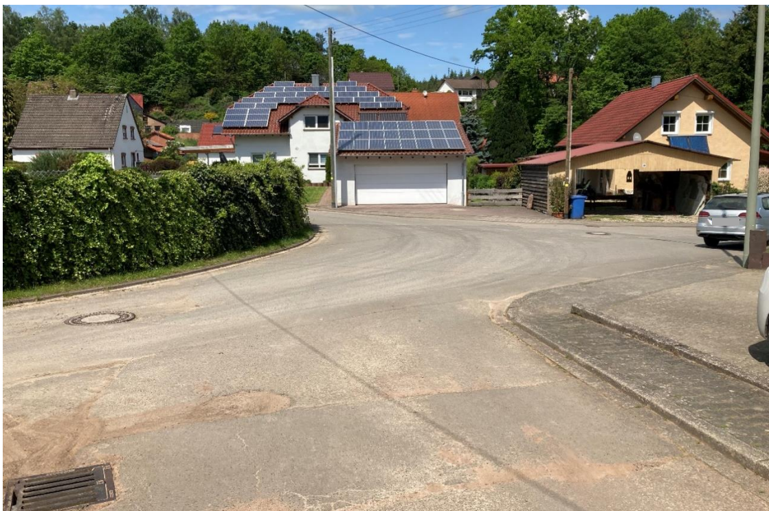
Abb. 219: Potenziell überflutungsgefährdete Bebauung
