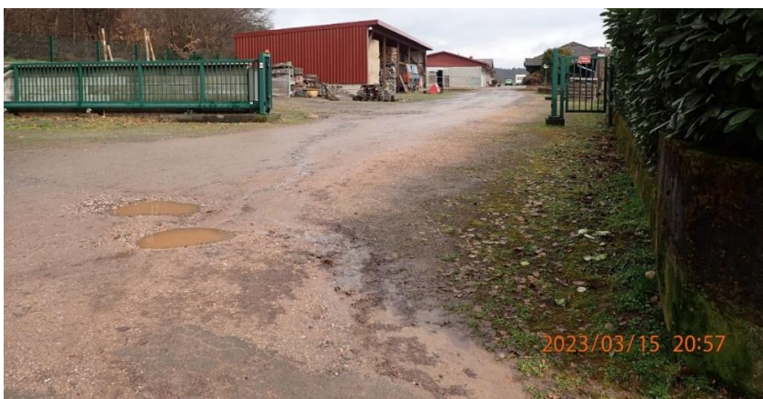
Abb. 196: Oberflächenabfluss auf die Waldstraße
