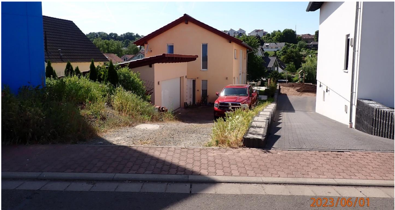
Abb. 179: Beispiel für potenziell überflutungsgefährdetes Gebäude in der Lauterer Straße
