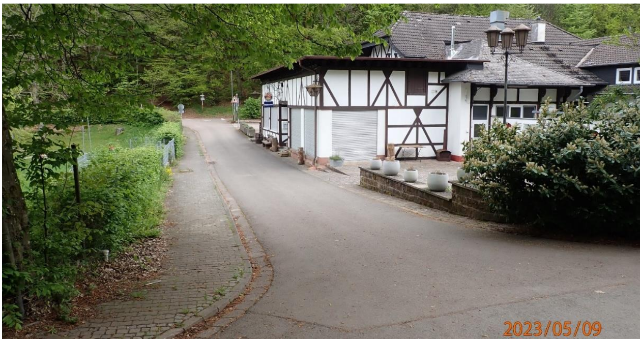
Abb. 46: Tiefpunkt oberhalb des Schwimmbads und potenziell überflutungsgefährdete Gaststätte
