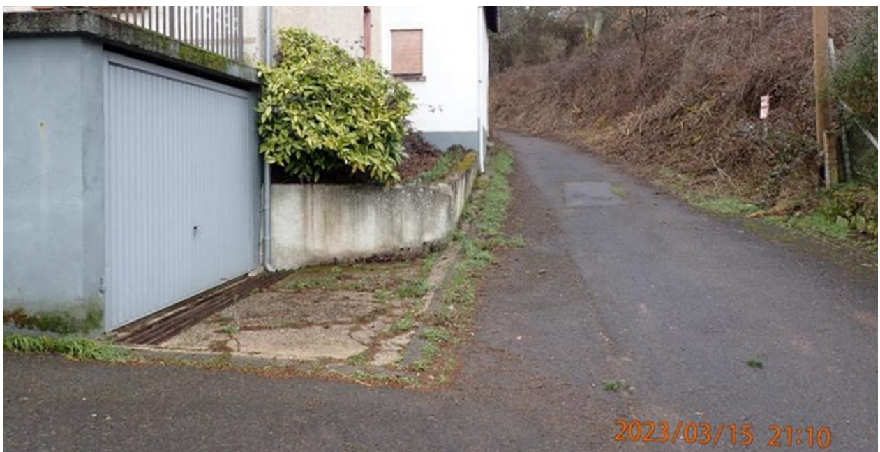
Abb. 207: Potenziell überflutungsgefährdete Garage
