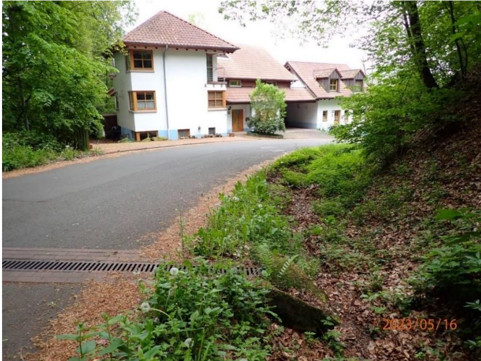
Abb. 55: Neuweg mit abgedeckter Querrinne und Seitengraben
