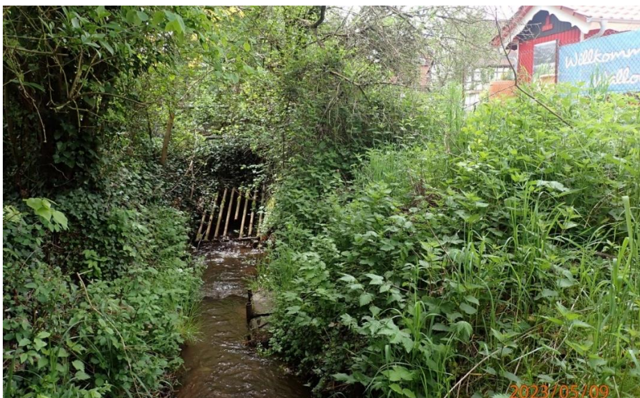
Abb. 53: Zulauf zur Otterbachverrohrung in der Johannisstraße
