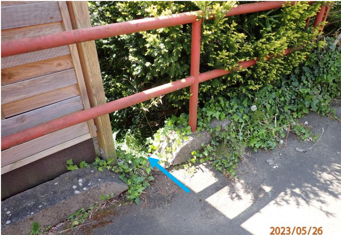
Abb. 82: Notabflussweg vom Fußweg in den Grafenthaler Bach
