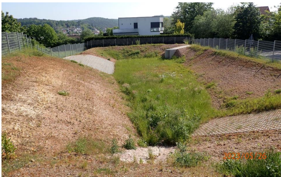
Abb. 133: Wasserwirtschaftliche Ausgleichsmaßnahme mit Mönchbauwerk und Dammscharte zur IGS
