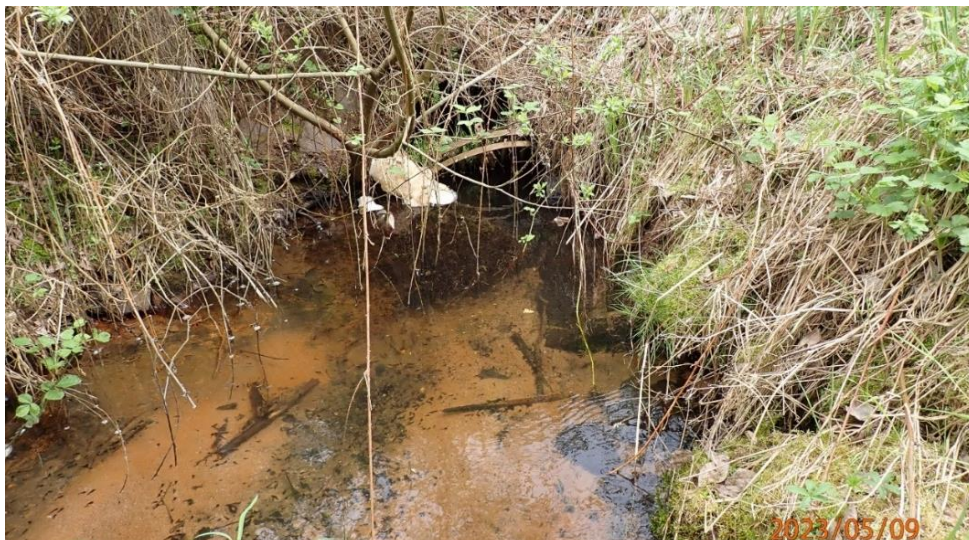
Abb. 50: Auslauf der Otterbachverrohrung unterhalb des Sportplatzes
