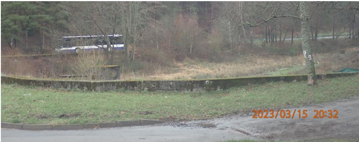
Abb. 43: Mauer als Oberkante des Rückhaltebeckens
