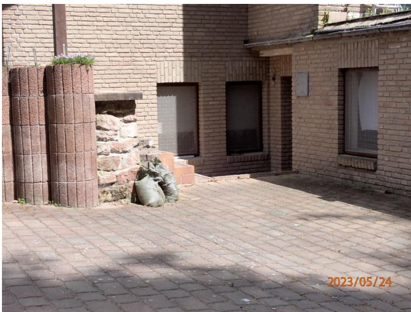
Abb. 195: Überflutungsgefährdete Bebauung in der Waldstraße
