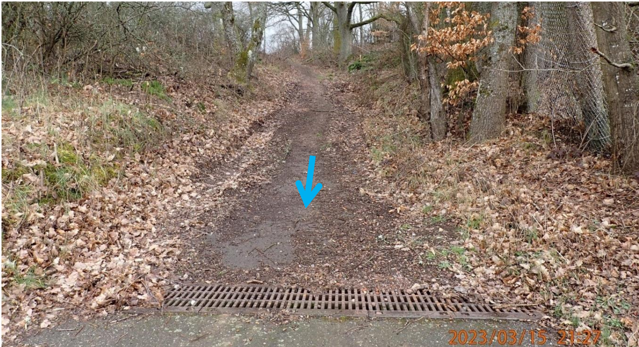
Abb. 209: Kastenrinne am Übergang zur Straße „Im Amseltal“
