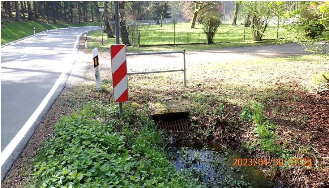
Abb. 31: Gewässerverrohrung mit Rechen an der Zufahrt zum Birotshof
