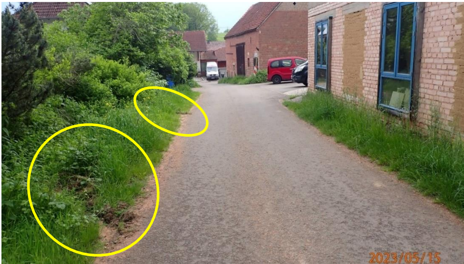
Abb. 107: Versandete Querschläge in den Wegseitengraben
