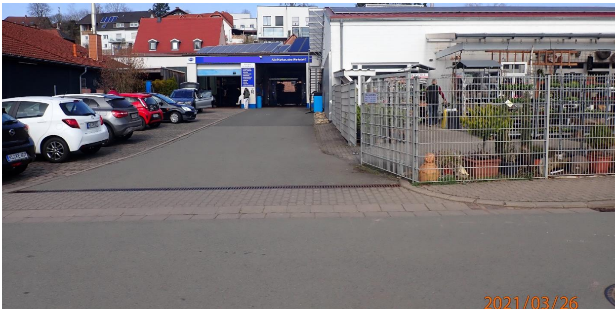
Abb. 163: Überflutungsgefährdete Betriebe zwischen Hauptstraße und Otterstraße
