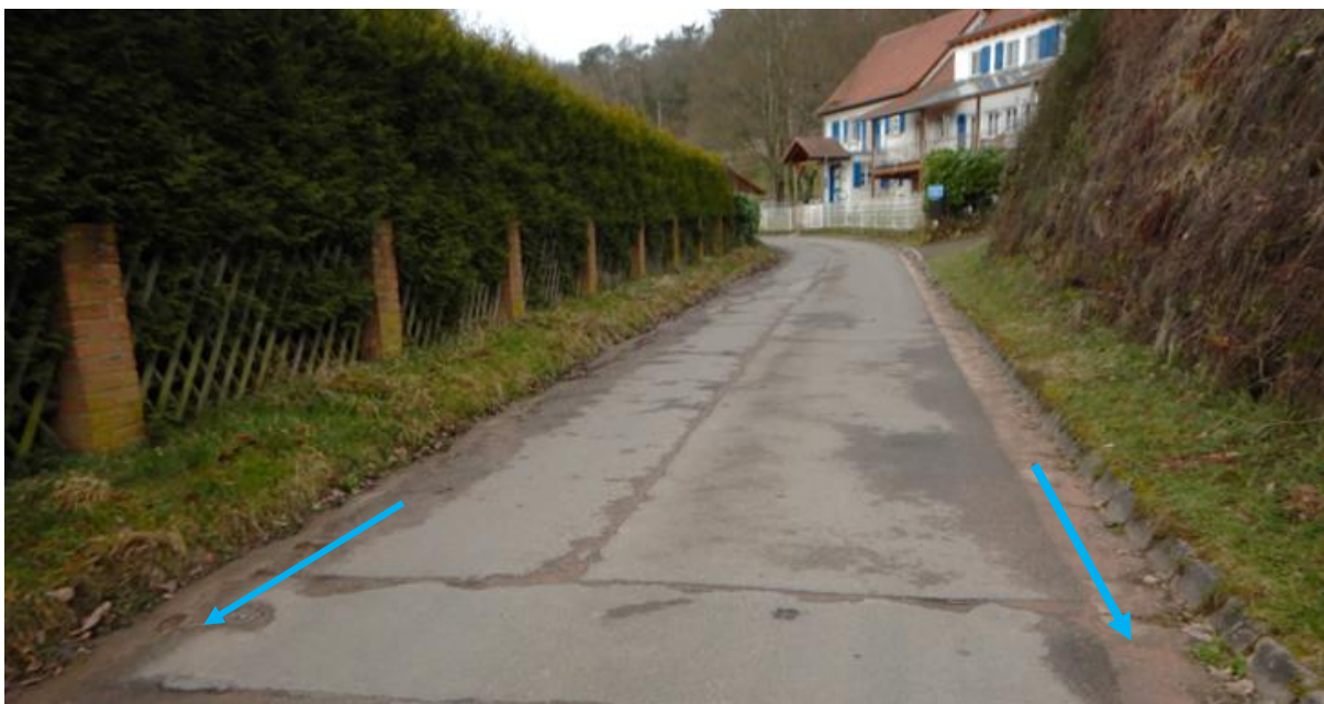
Abb. 94: HAUPTerschließungsstraße auf dem Lauerhof mit oberflächiger Entwässerung
