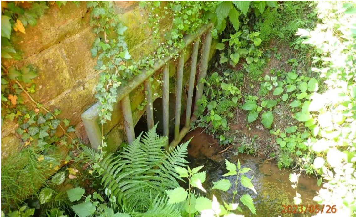
Abb. 84: Beginn der Verrohrung des Grafenthaler Baches in der Lauerhöfer Straße
