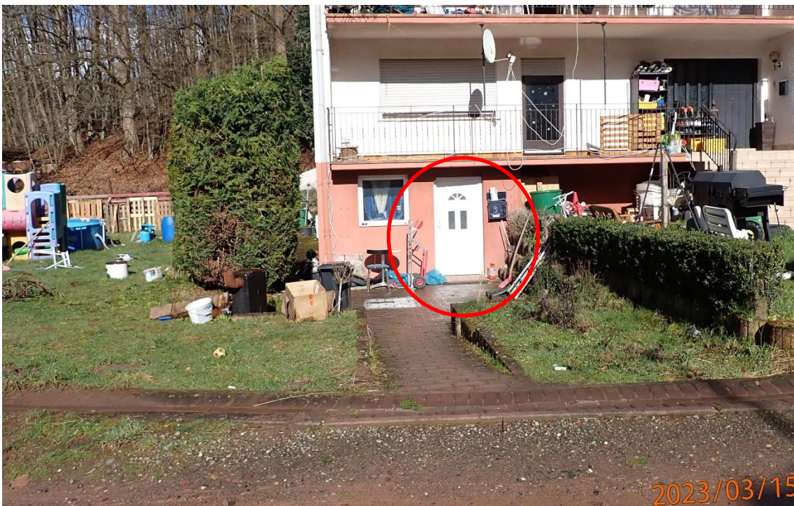
Abb. 256: Potenziell überflutungsgefährdete Bebauung
