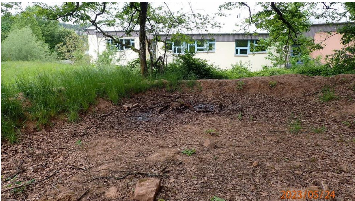
Abb. 127: Verwallung mit Kleinrückhalt oberhalb der Waldorfschule
