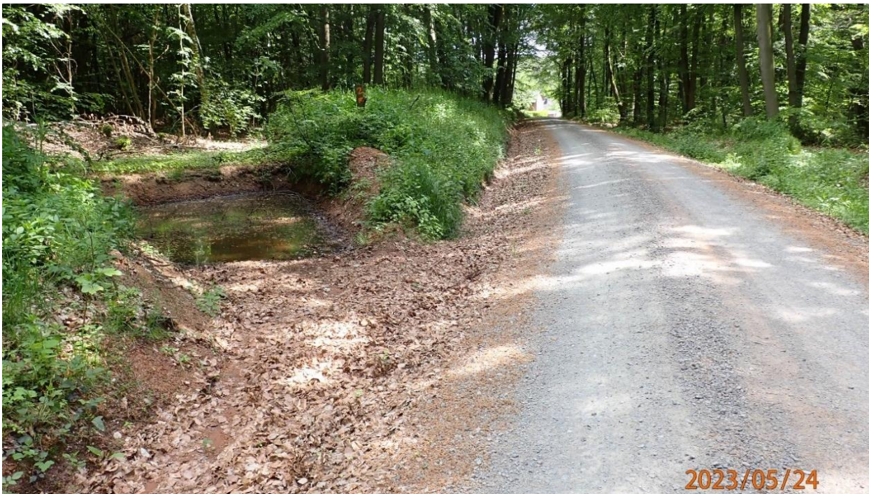
Abb. 11: Beispiel für einen Querabschlag von einem Waldweg in einen Kleinrückhalt in Otterberg/Drehenthalerhof
