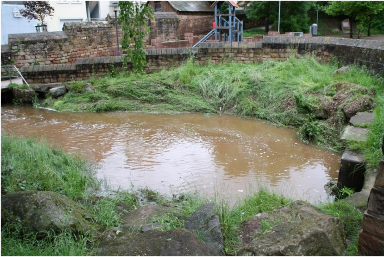
Abb. 138: Einstau des Otterbachs oberhalb der Stadthalle, 05/2016
