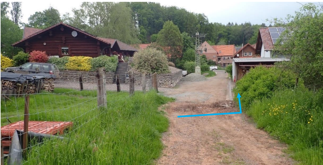
Abb. 104: Querentwässerung des Wirtschaftswegs
