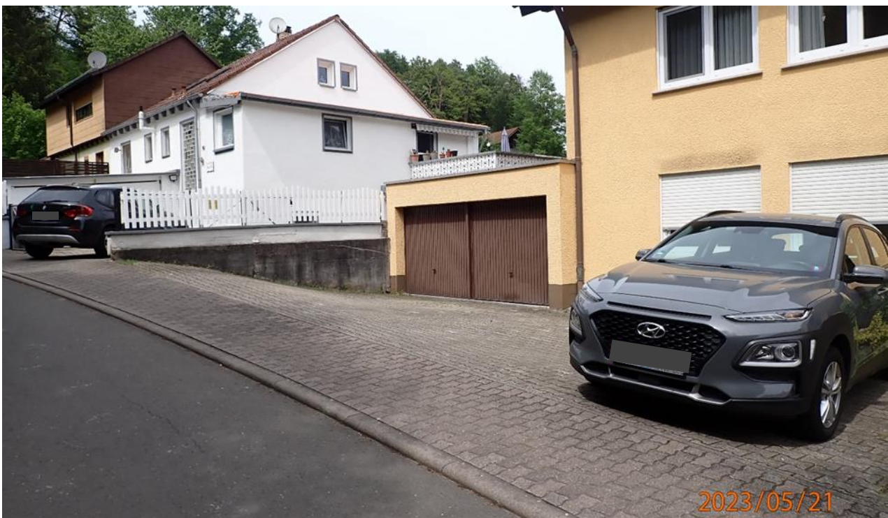
Abb. 57: Beispiel für potenziell überflutungsgefährdete Garagen
