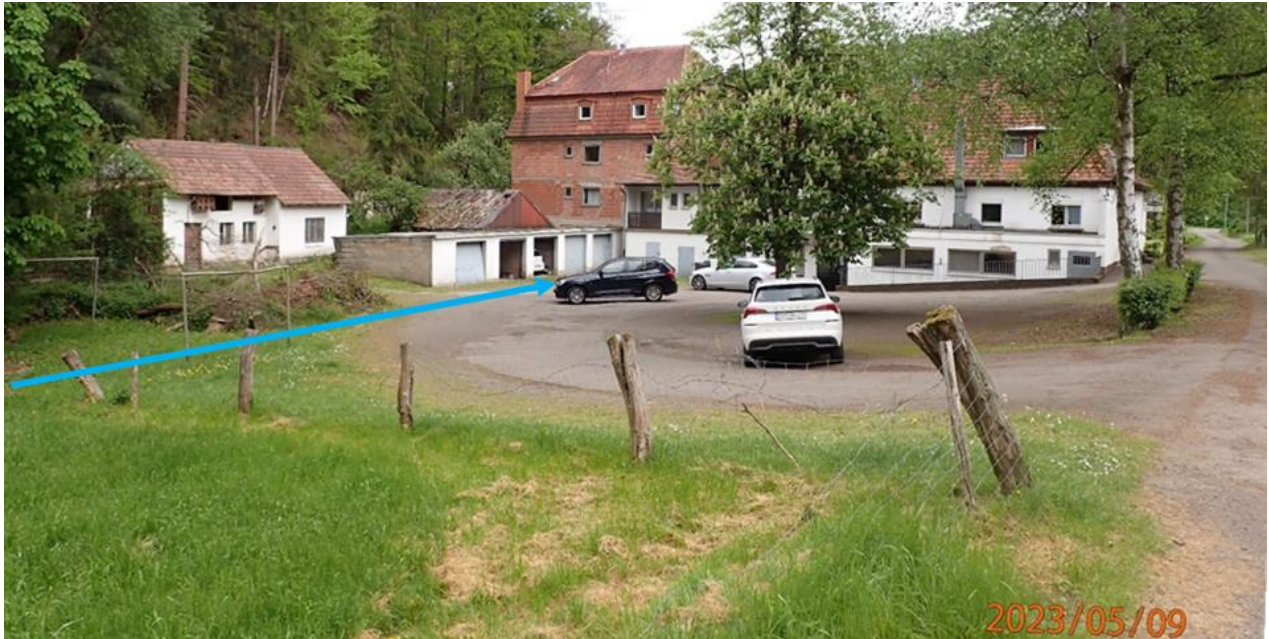
Abb. 49: Gastronomiebetrieb mit Trasse der Gewässerverrohrung (blauer Pfeil)
