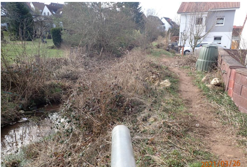
Abb. 169: Weinbrunnerbach/Aggenbach unterhalb der Fußwegquerung
