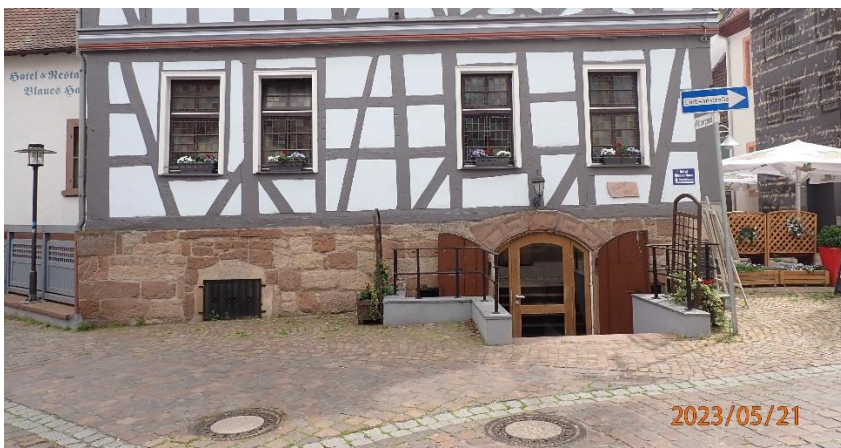
Abb. 62: Potenziell überflutungsgefährdete Bebauung
