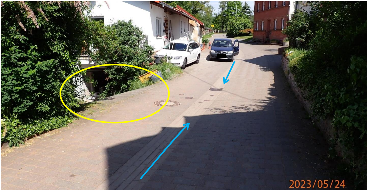
Abb. 247: Abschüssige Garagenzufahrt in der Straßensenke
