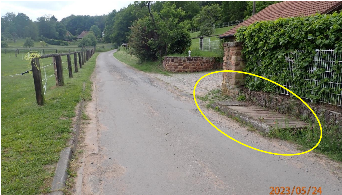
Abb. 93: Sandfang am Bebauungsrand
