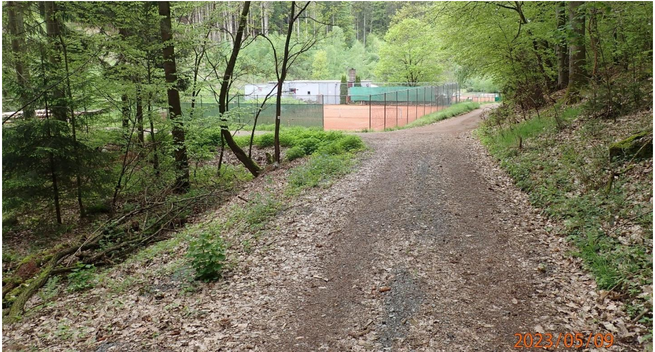
Abb. 45: Potenziell überflutungsgefährdete Tennisanlage
