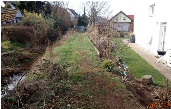
Abb. 171: Überflutungsgefährdete Gebäude am Weinbrunnerbach/Aggenbach
