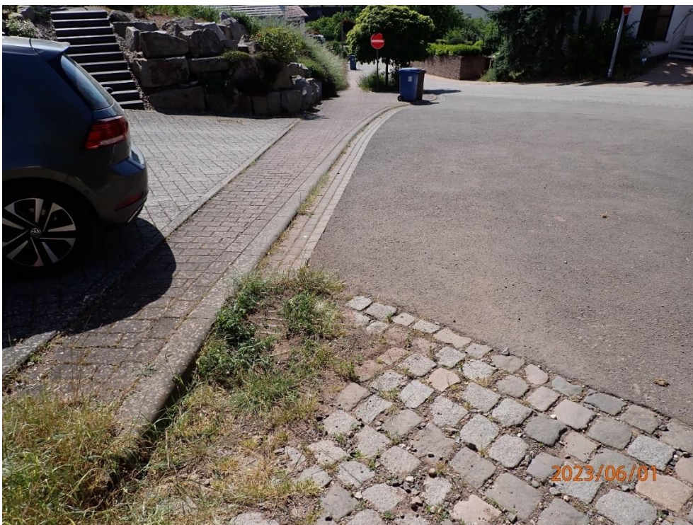
Abb. 178: Verschlammter Straßenablauf
