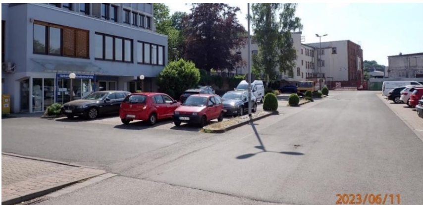
Abb. 87: Verbandsgemeindeverwaltung im überflutungsgefährdeten Bereich
