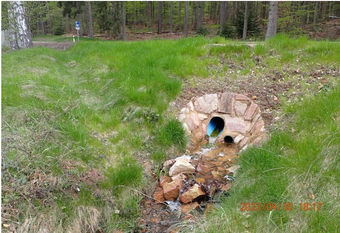
Abb. 33: Beispiel für Straßendurchlass unter der L 387 zum Otterbach
