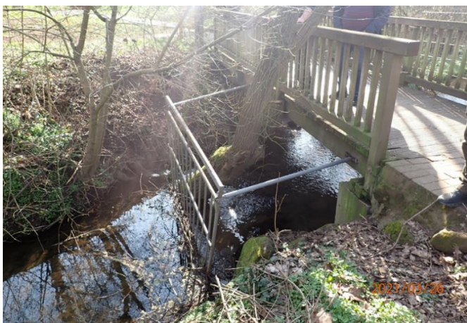
Abb. 144: Fußgängersteg über den Otterbach zur Grundschule mit vorgelagertem Rechen
