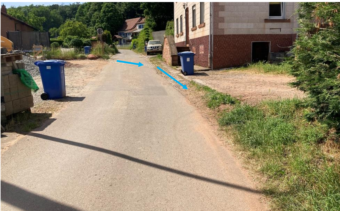
Abb. 95: Ungepflegte Entwässerungsrinnen
