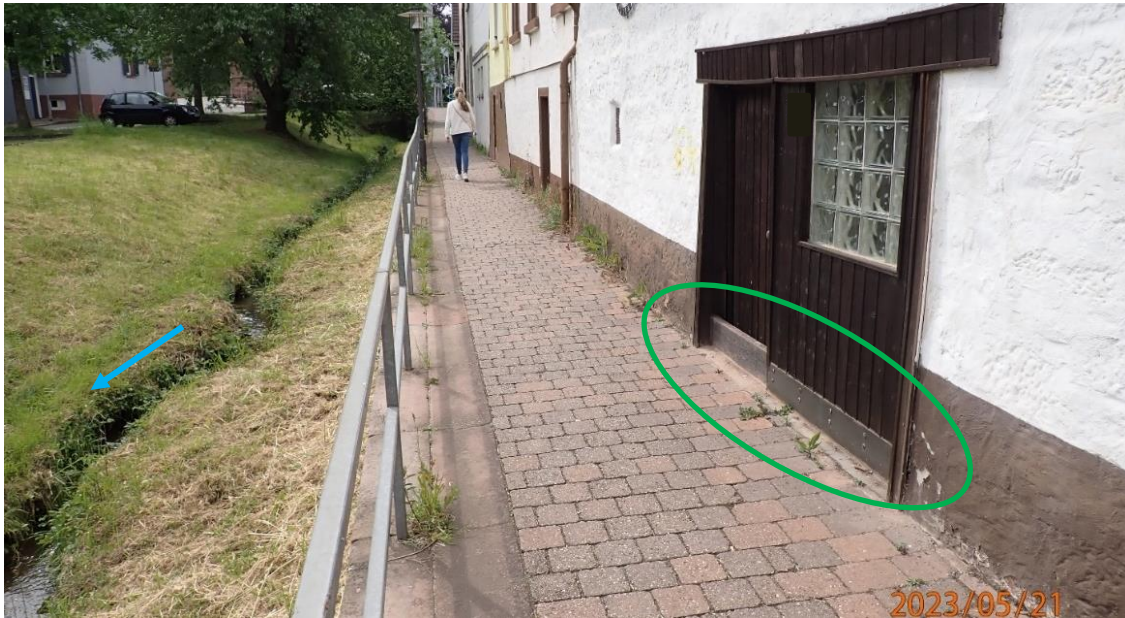
Abb. 88: Grafenthaler Bach unterhalb der Hauptstraße und Häuser mit Objektschutz (grün)
