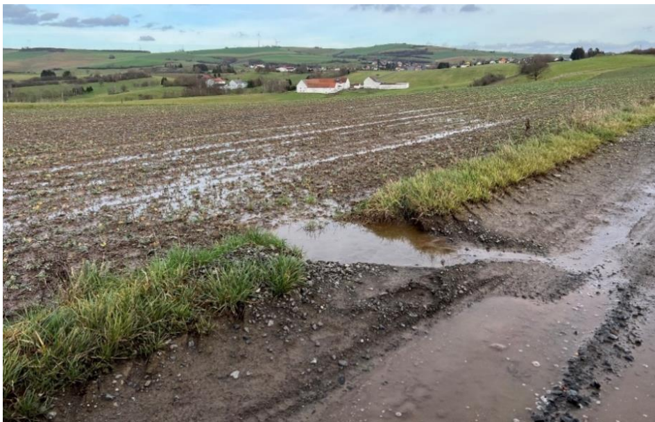
Abb. 12: Beispiel für Querentwässerung in die Fläche durch Öffnen des Banketts in der Verbandsgemeinde Otterbach-Otterberg
