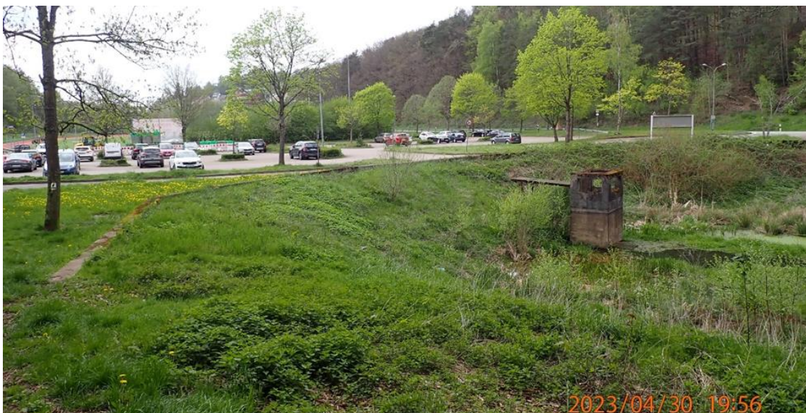
Abb. 42: Hochwasserrückhaltebecken mit Geländeaufschüttung als Sperrbauwerk
