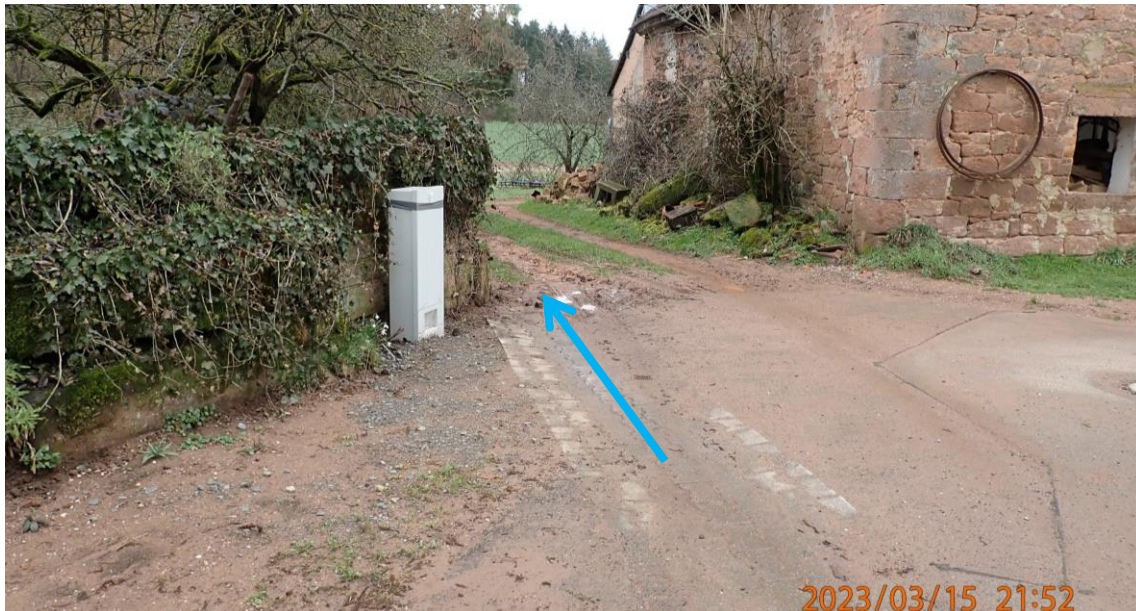
Abb. 244: Planmäßige Entwässerung (blauer Pfeil) zum Krebsbach
