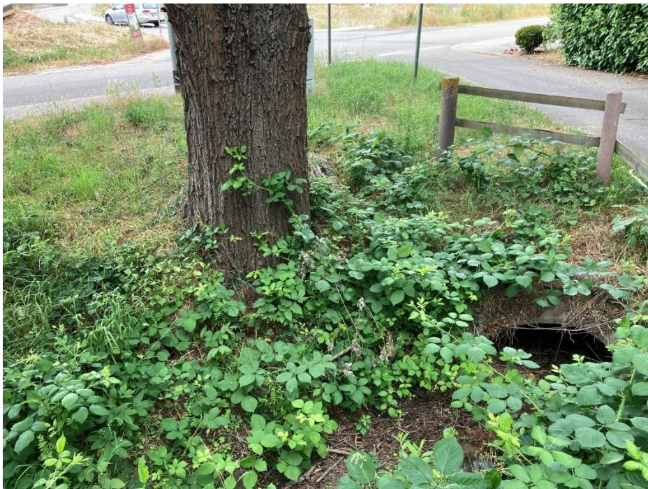
Abb. 185: Verlegter Straßendurchlass Kapellenweg
