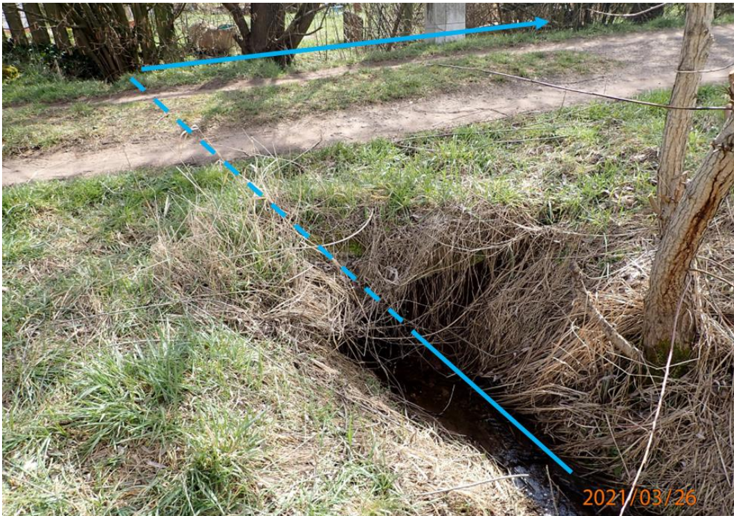
Abb. 111: 90°-Richtungswechsel im Gewässer „Lauertal“ am Bebauungsrand
