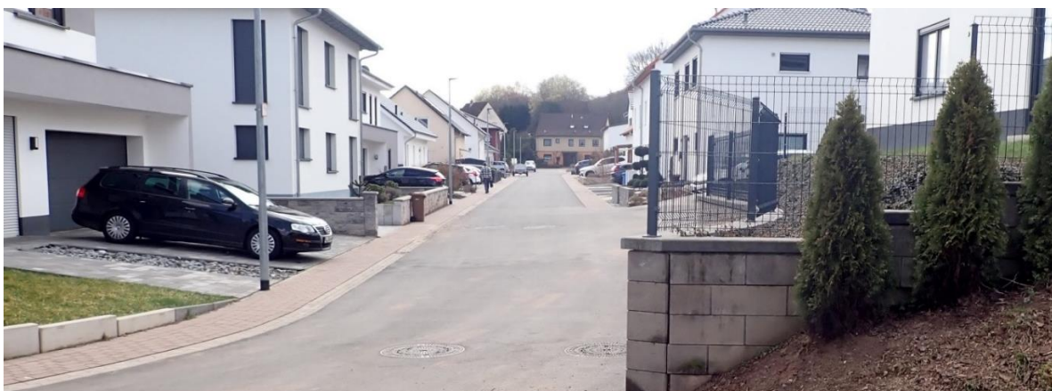
Abb. 23: Beispiel für überflutungsresiliente Erschließung und Neubebauung (querstehendes Haus am Ende der Straße ist überflutungsgefährdet)
