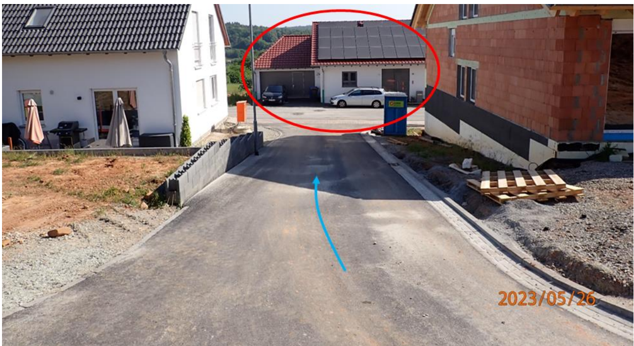
Abb. 19: Beispiele für verbaute Abflusswege in Otterberg
