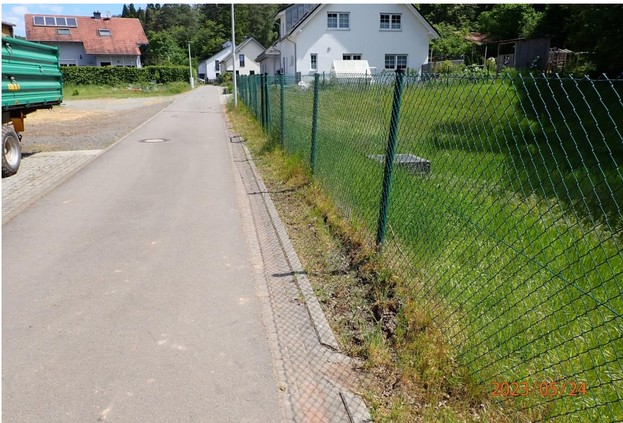
Abb. 224: Wasserwirtschaftliche Ausgleichsmaßnahme mit oberirdischen Zuläufen von der Straße
