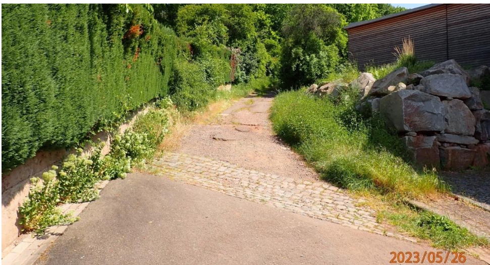
Abb. 177: Querrinne am Übergang zwischen unbefestigtem Weg und Baumstraße
