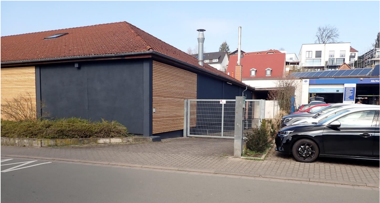
Abb. 164: Überflutungsgefährdeter Betrieb in der Otterstraße
