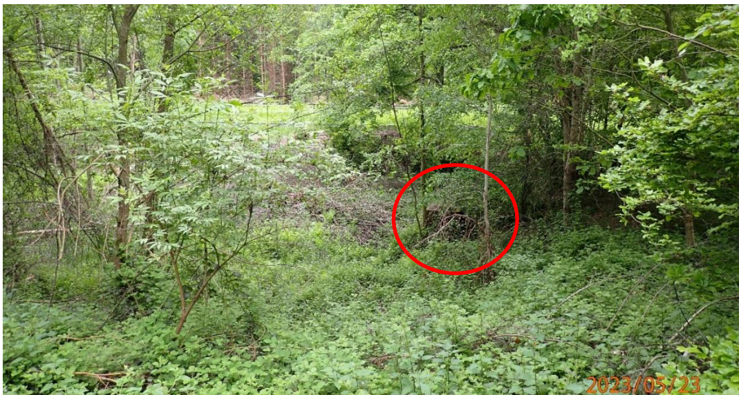
Abb. 72: Verwilderter ehemaliger Teich im Grafenthaler Bach mit Mönchbauwerk (rote Markierung)
