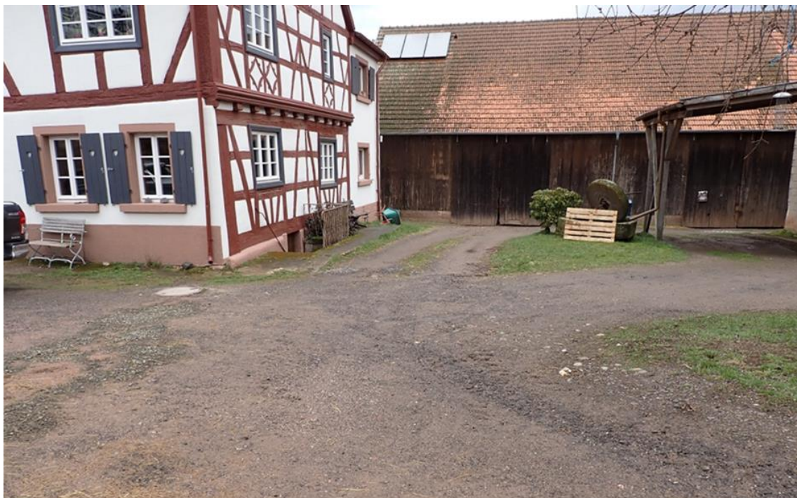
Abb. 245: Potenziell überflutungsgefährdete Bebauung
