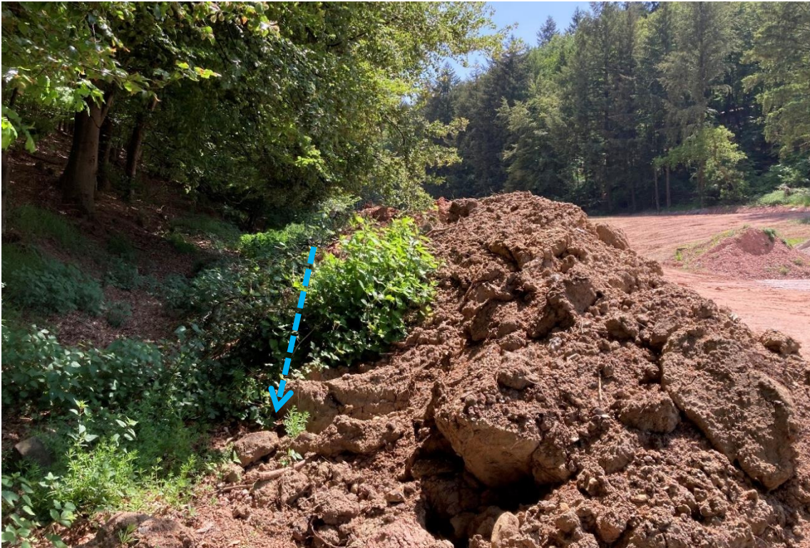
Abb. 255: Ursprüngliche Tiefenlinie (blauer Pfeil) und Geländeaufschüttung
