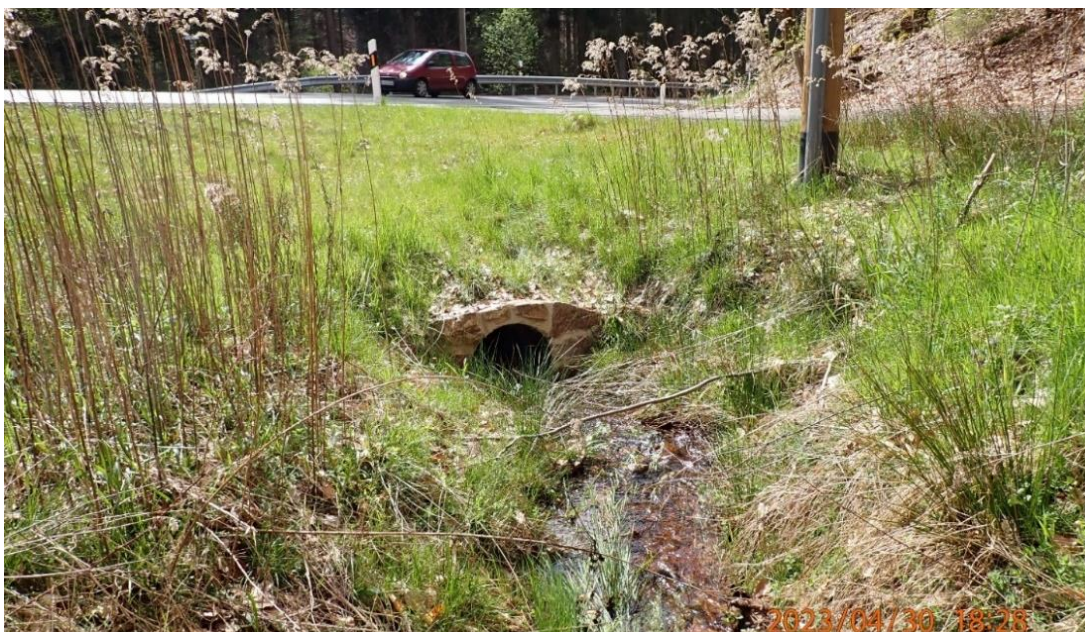
Abb. 34: Otterbachdurchlass unter der L 387
