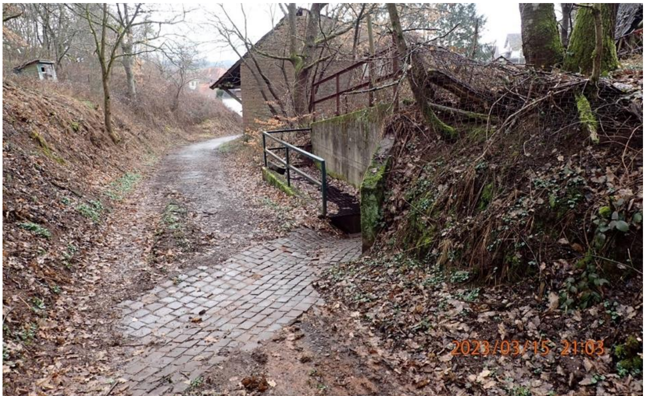
Abb. 203: Hohlweg mit Querrinne und Sandfang
