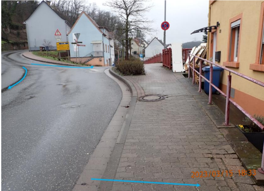
Abb. 69: Abflusswege auf der oberen Johannisstraße
