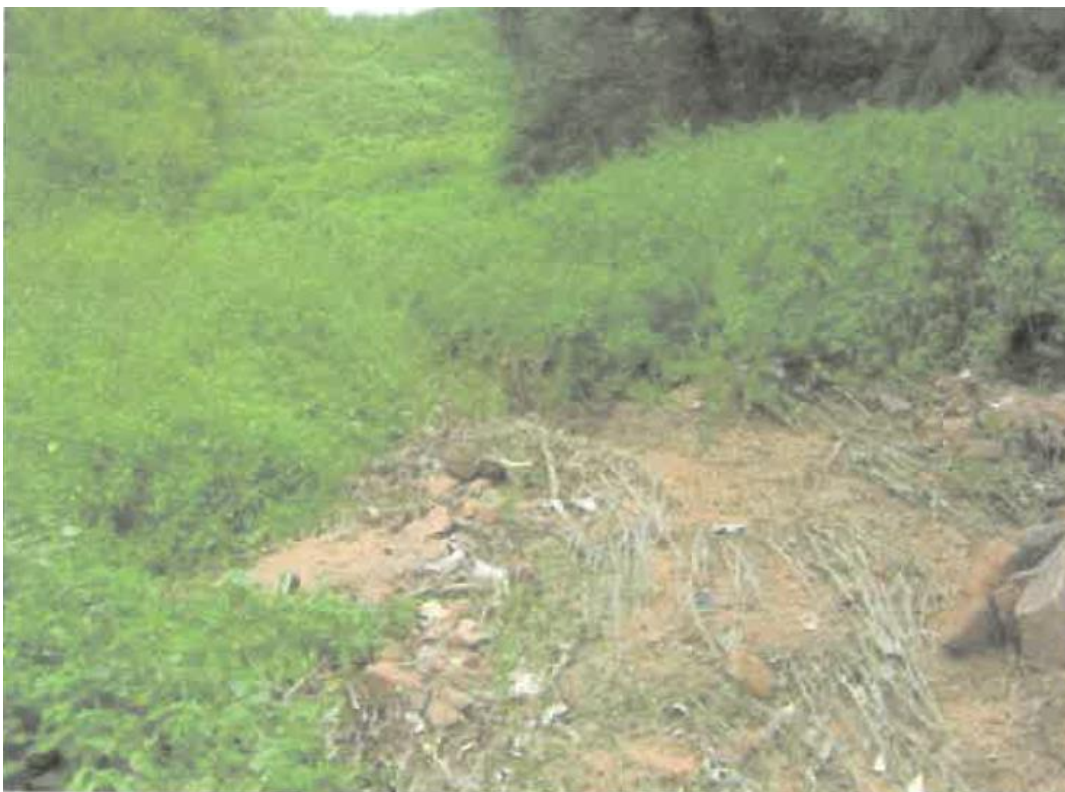
Abb. 152: Geröllablagerung und Erosionsschäden unterhalb der L 382, 2010, Foto: Fam. Markus
