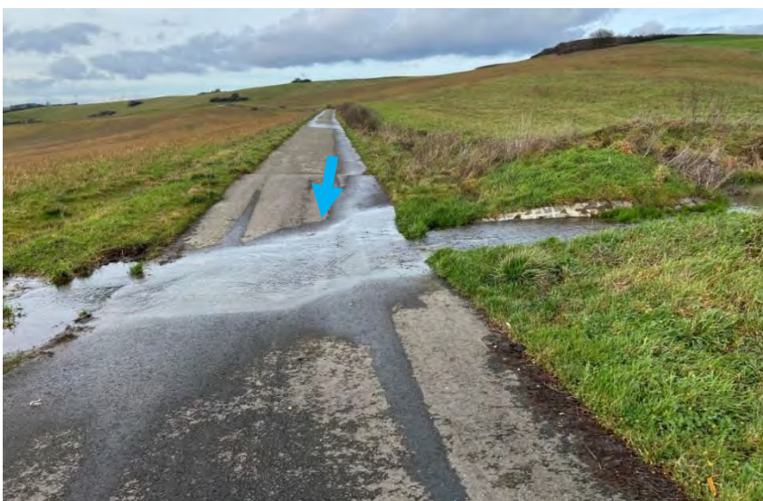
Abb. 72: Wirtschaftsweg zwischen Hofgewanne und Berggewanne mit Furt als Überlauf aus dem Kleinrückhalt (01/2023)
