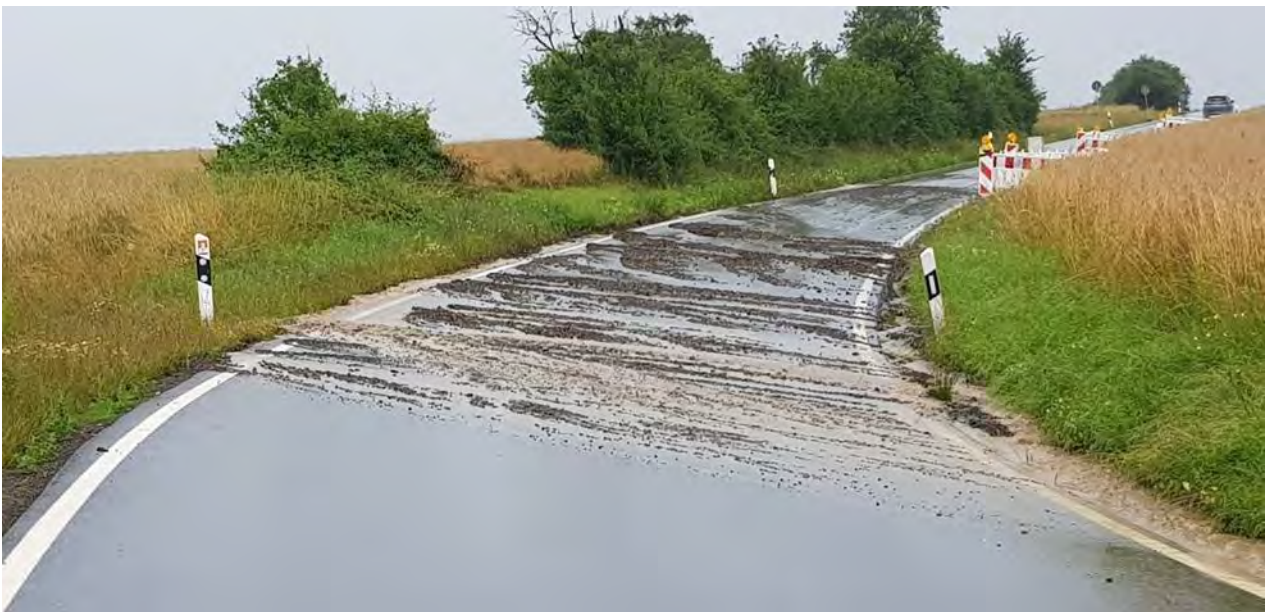
Abb. 78: Überströmung der K 31 im Sommer 2021, Foto: Rösner
