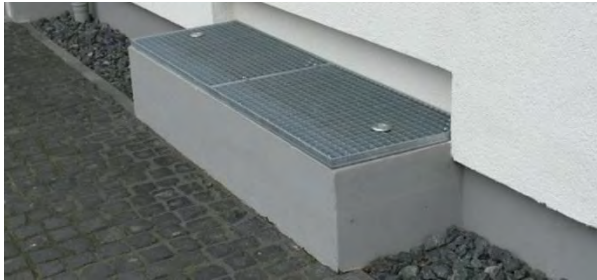
Abb. 18: Beispiel für die Sicherung eines niveaugleichen Lichtschachtes
