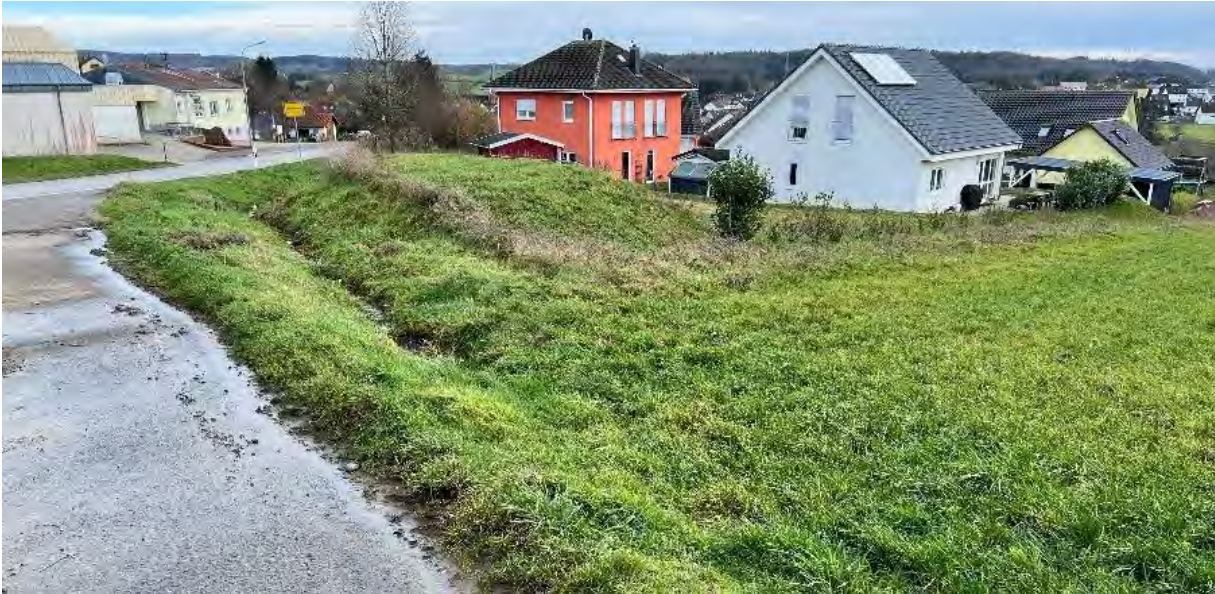
Abb. 81: Graben und Verwallung oberhalb des Baugebietes „Ochsenweiderweg“
