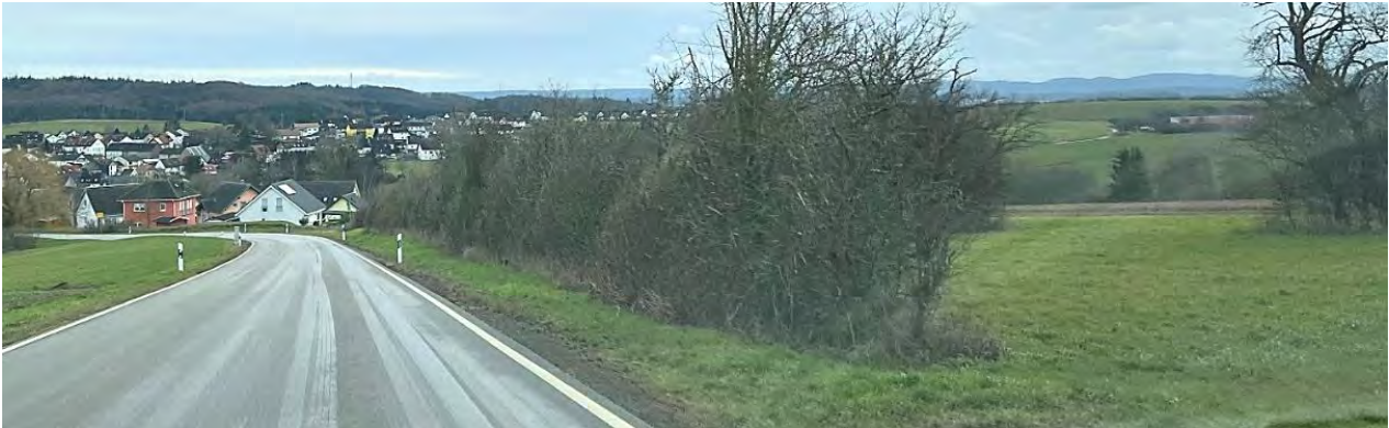
Abb. 77: K 31 und angrenzendes Gelände ohne Entwässerungseinrichtungen
