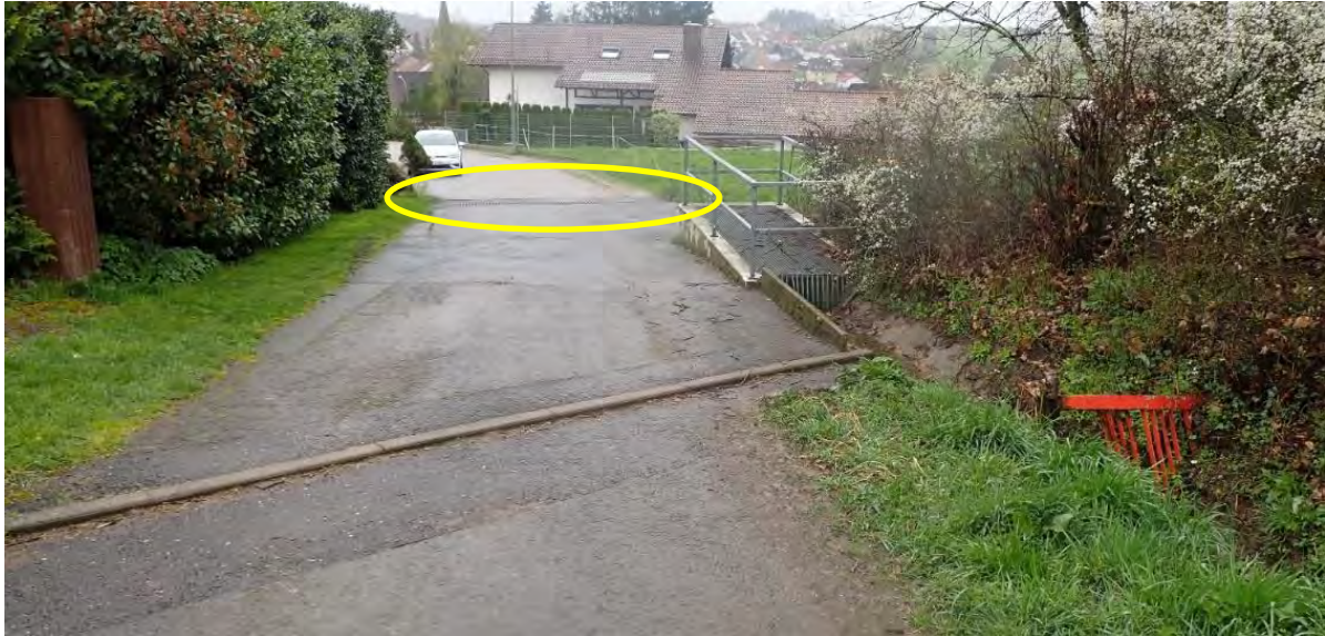
Abb. 62: Querrinnen und Sandfang mit Rechen im Übergang zur Flurstraße
