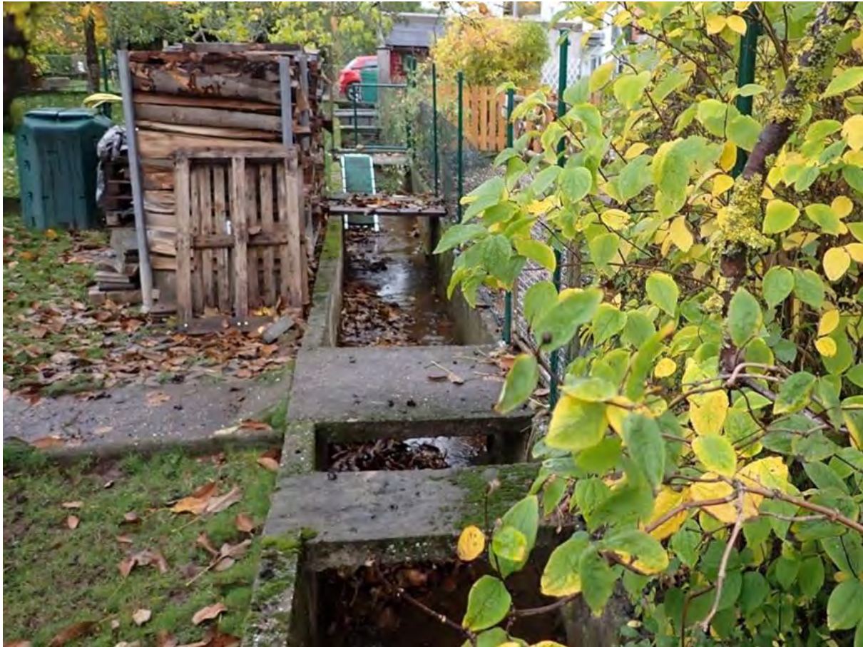
Abb. 9: Negativbeispiel für Nutzungen im 10-m-Bereich des Baierbachs (Gewässer III. Ordnung)
