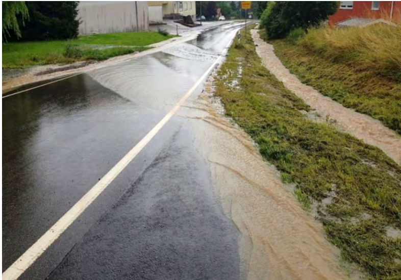
Abb. 66: Oberflächenabfluss von Außengebietswasser auf der K 31, Foto: Rösner
