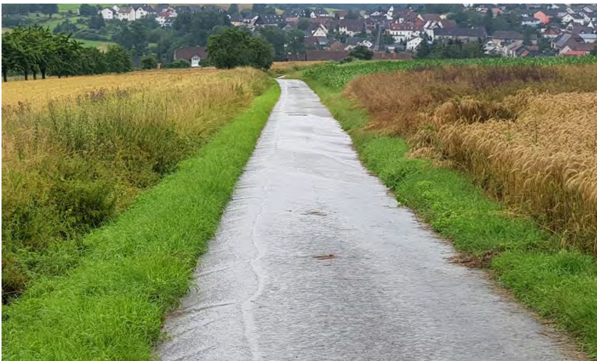
Abb. 10: Beispiel für Oberflächenabfluss auf dem Weg zur Flurstraße mit hohen Banketten im Juli 2021, Foto: Rösner
