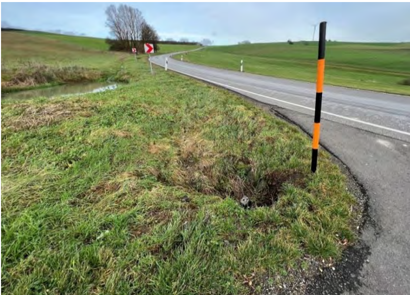
Abb. 74: Alter Wegdurchlass unterhalb des Kleinrückhaltes
