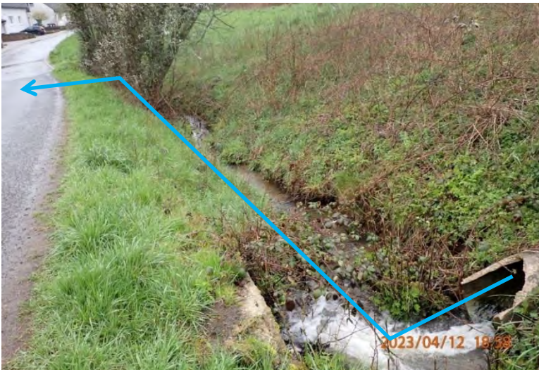
Abb. 45: Auslauf des Sellbachs aus der Verrohrung an der Wickelhöfer Straße
