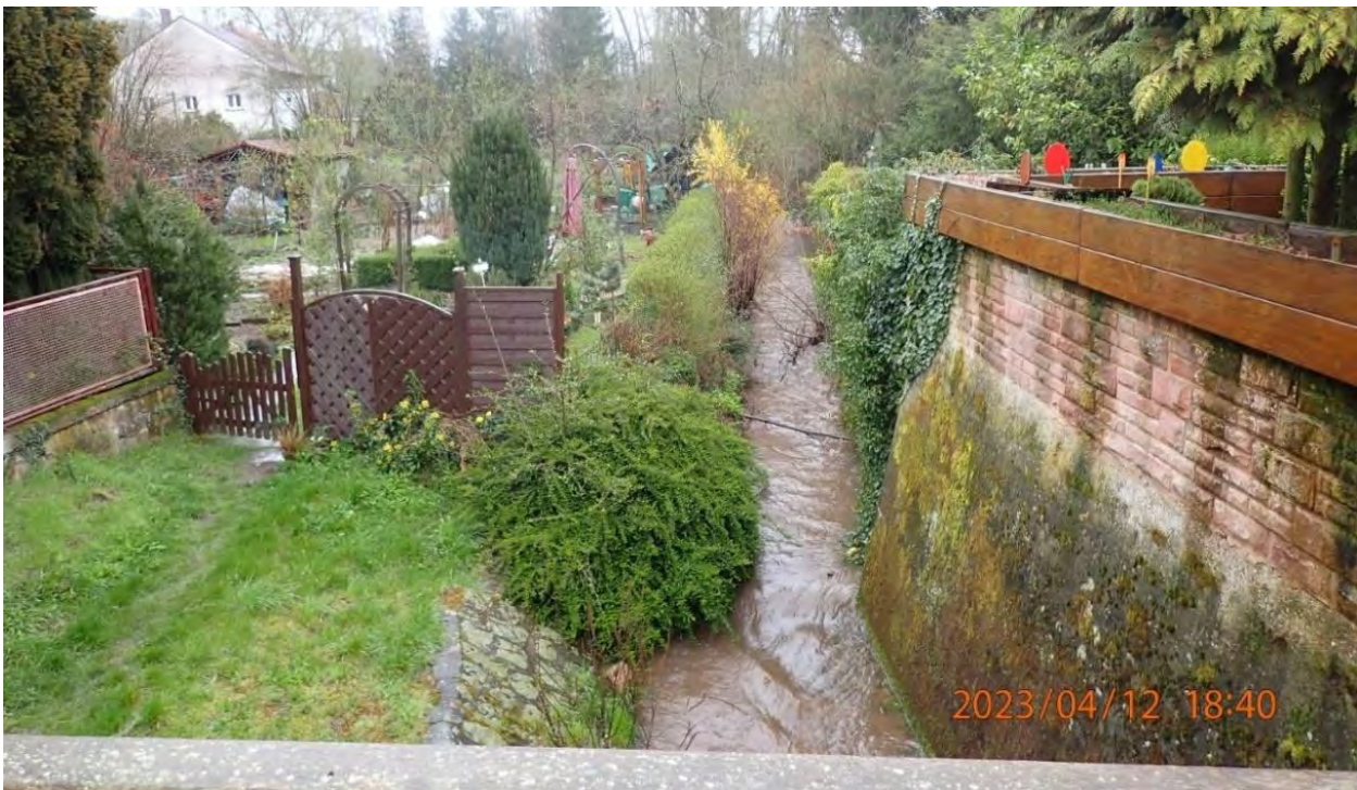
Abb. 29: Odenbach oberhalb der Straße „Große Gasse“
