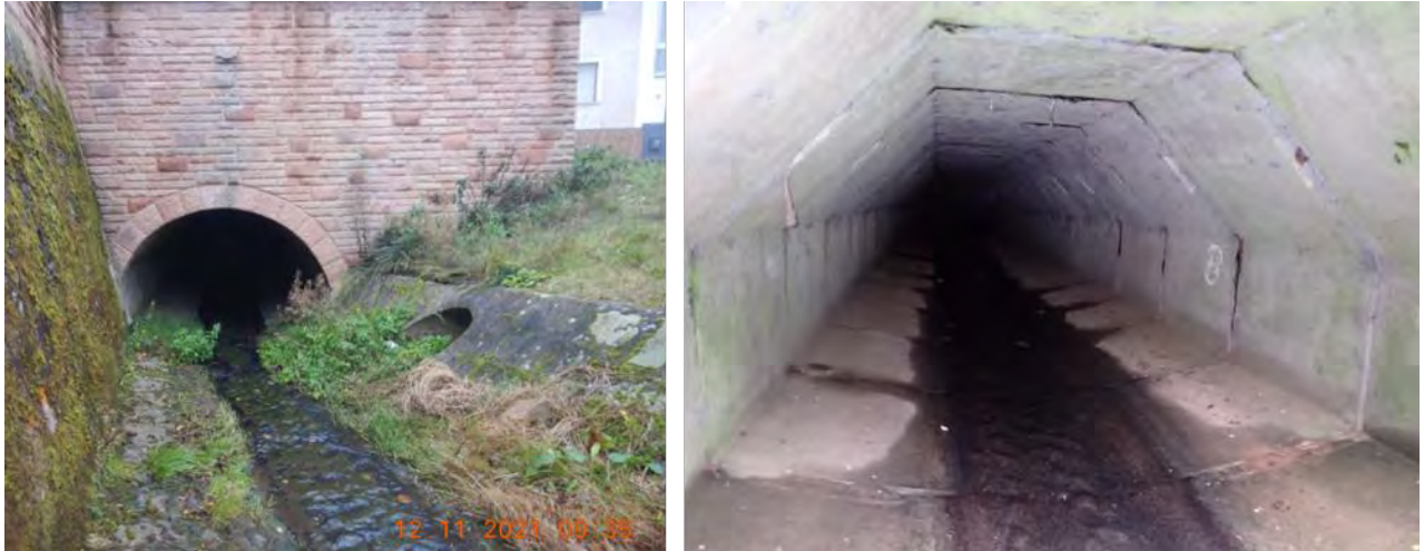
Abb. 30: Durchlass unter der Straße „Große Gasse“
