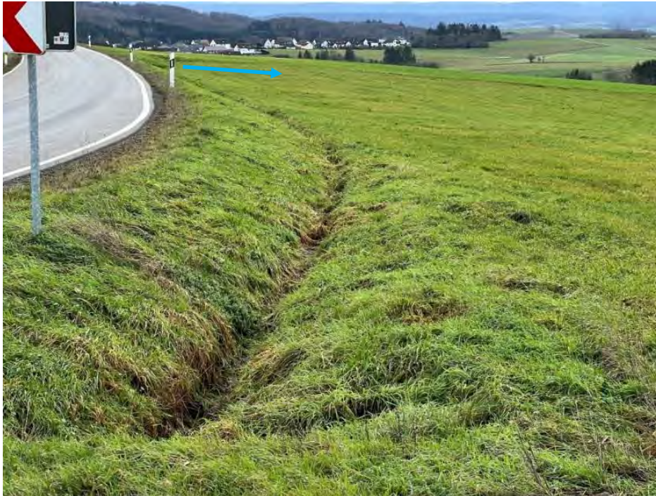
Abb. 75: Straßengraben an der K 31 mit empfohlenem Abschlag zum Odenbach (blauer Pfeil)
