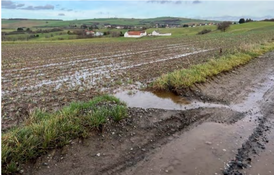
Abb. 11: Beispiel für die Querentwässerung in die Fläche durch Öffnen des Banketts in Schallodenbach
