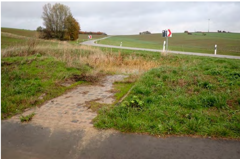
Abb. 71: Gepflasterter Überlauf aus dem Kleinrückhalt
