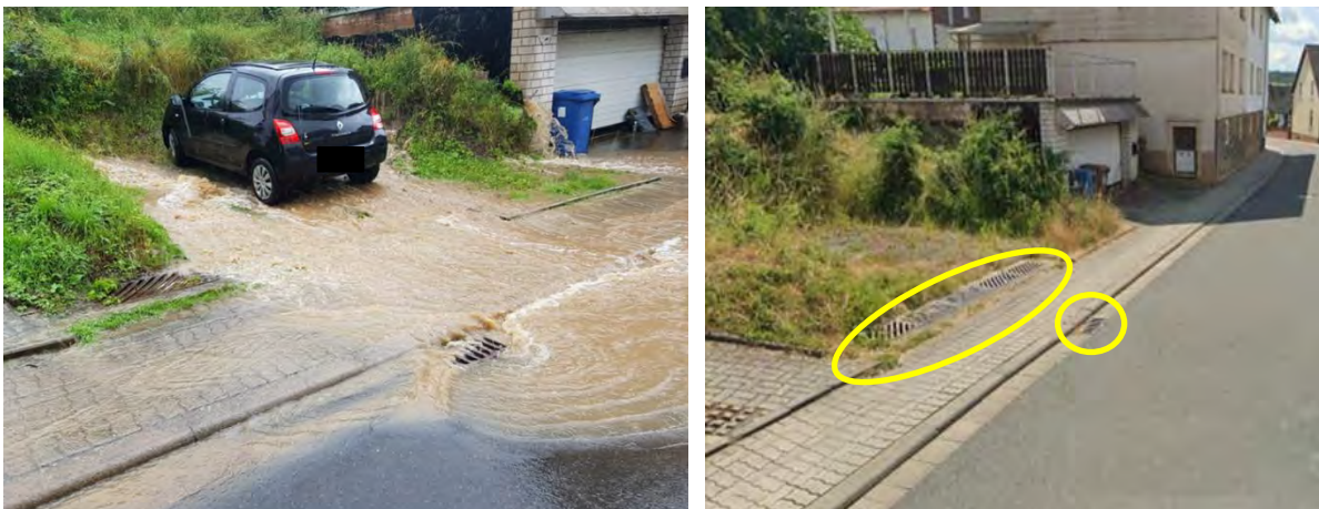
Abb. 127: Sturzfluten über eine lange Grundstückszufahrt auf die Felsstraße mit bestehenden Straßenabläufen (Bild rechts, gelbe Markierung), Juli 2021, Foto: Rösner
