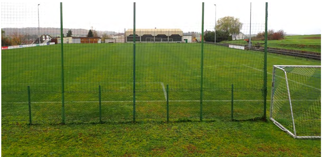
Abb. 111: Überflutungsgefährdeter Sportplatz mit Mehrzweckhalle
