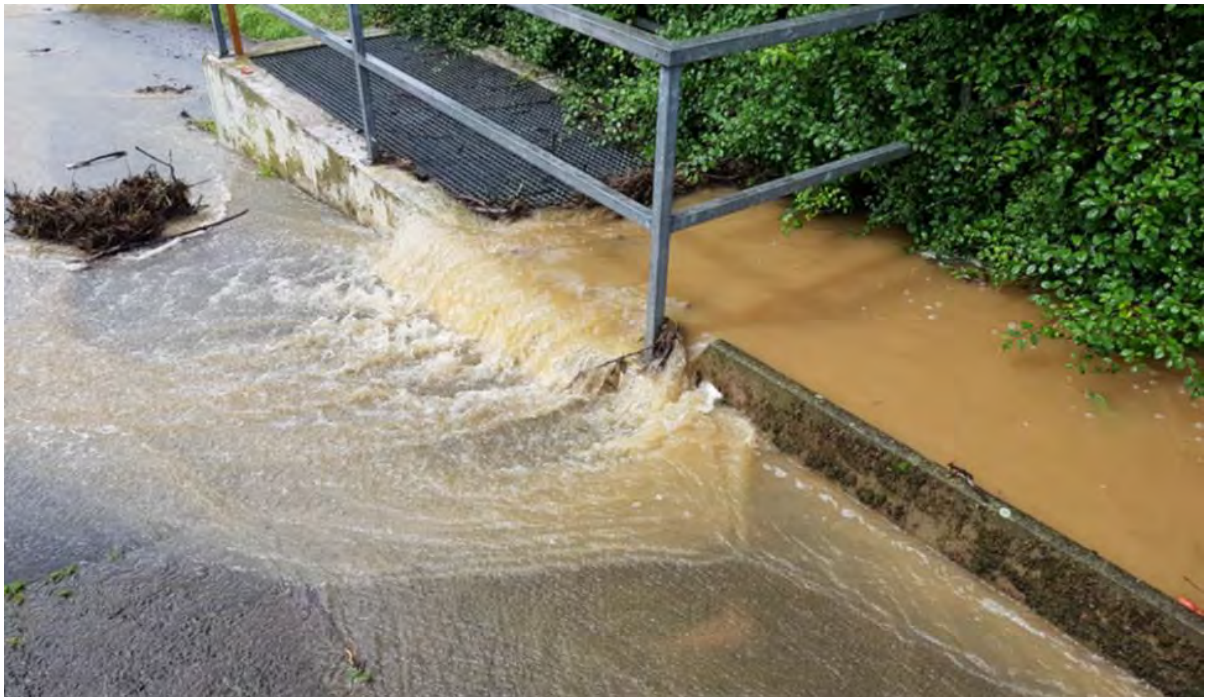
Abb. 63: Sandfang bei dem Starkregenereignis 2021, Foto: Rösner
