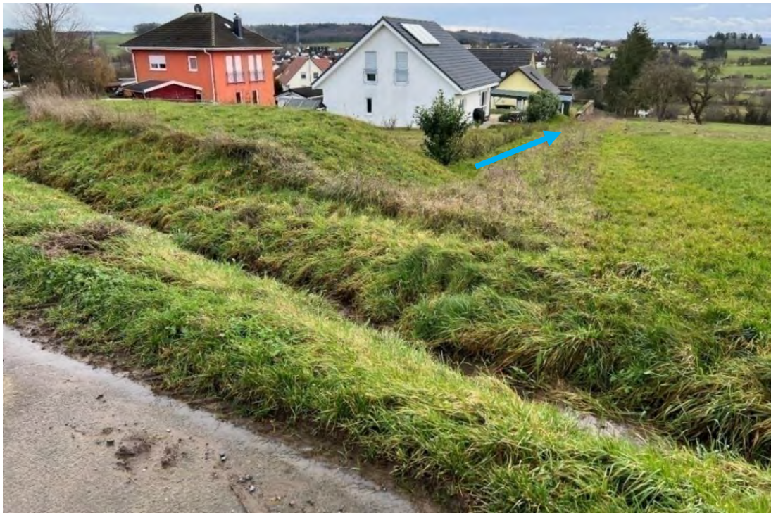
Abb. 86: Potenzielle Ableitungstrasse für Außengebietswasser zum Odenbach entlang des bestehenden und geplanten Bebauungsrandes
