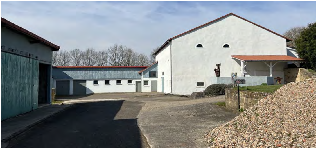
Abb. 130: Beispiele für potenziell überflutungsgefährdete Gebäude
