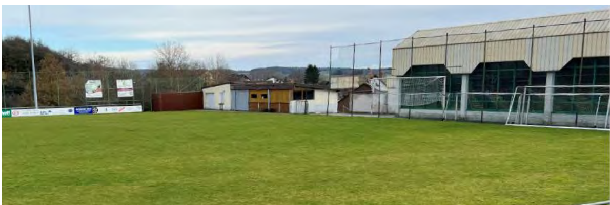
Abb. 112: Überflutungsgefährdung der Mehrzweckhalle bei extremen Starkregen, Sturzflutgefahrenkarte [1], SRI 10, 4 Std.
