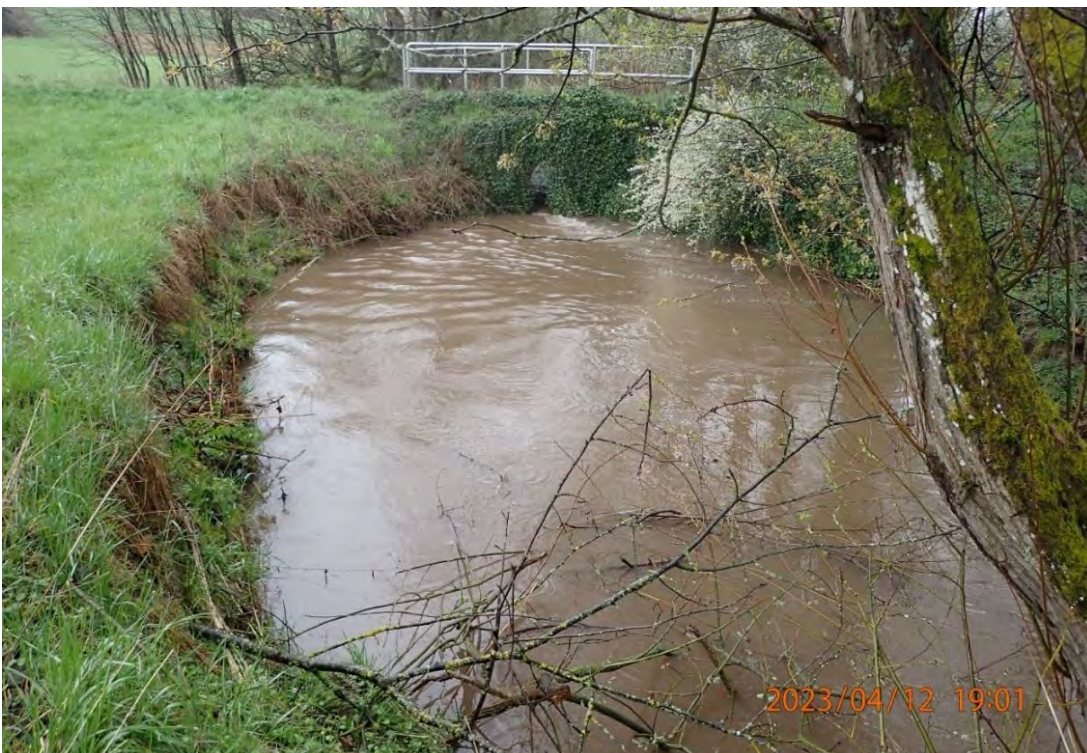
Abb. 25: Wegdurchlass mit Kolk im Odenbach
