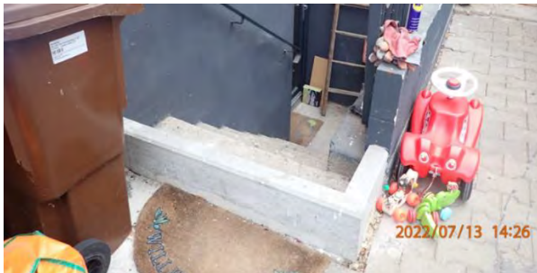
Abb. 19: Beispiel für die Sicherung eines außenliegenden Kellerzugangs
