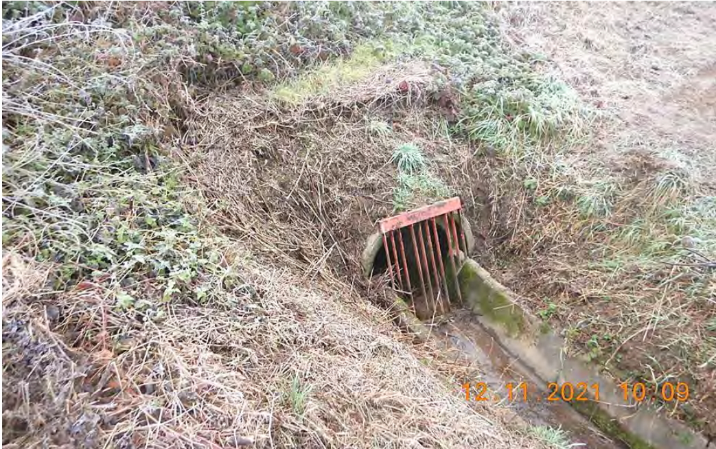
Abb. 96: Zulauf zur Baierbachverrohrung oberhalb des Sportplatzes
