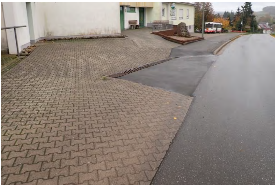
Abb. 7: Negativbeispiel für vollversiegelte Flächen an der Mehrzweckhalle in Schallodenbach
