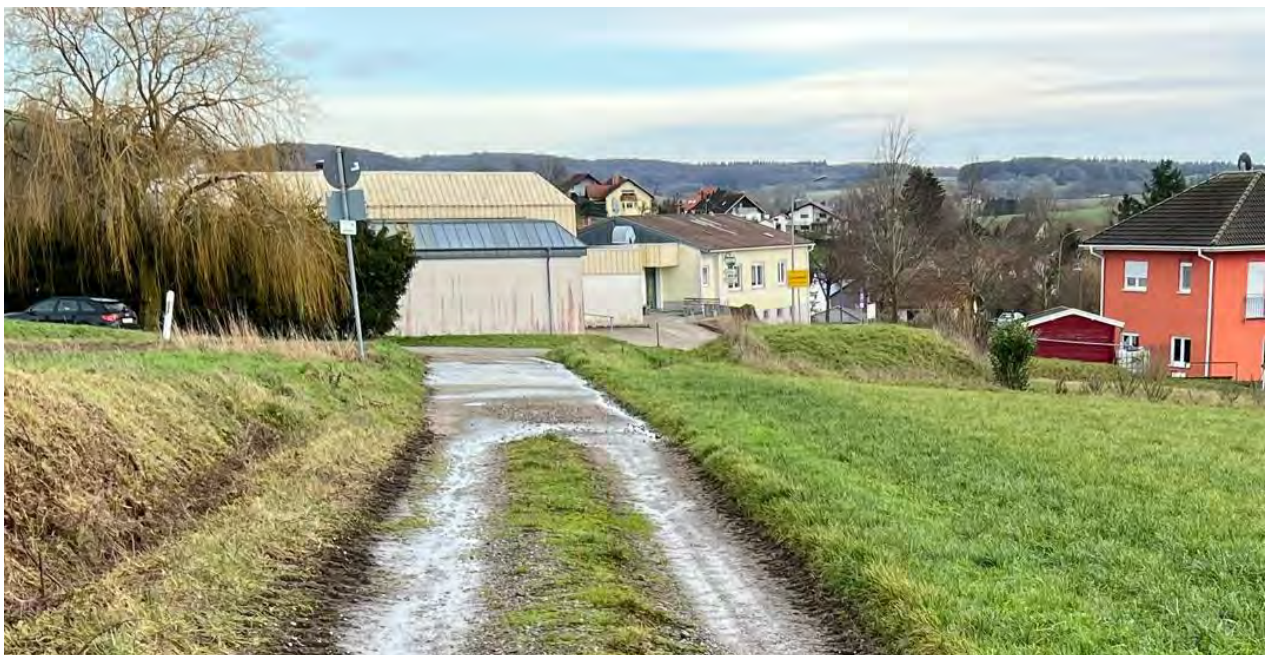
Abb. 84: Wegentwässerung an der Einmündung in die K 31 (01/2023)
