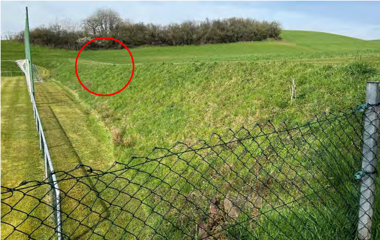
Abb. 99: Tiefpunkt der Verwallung oberhalb des Sportplatzes
