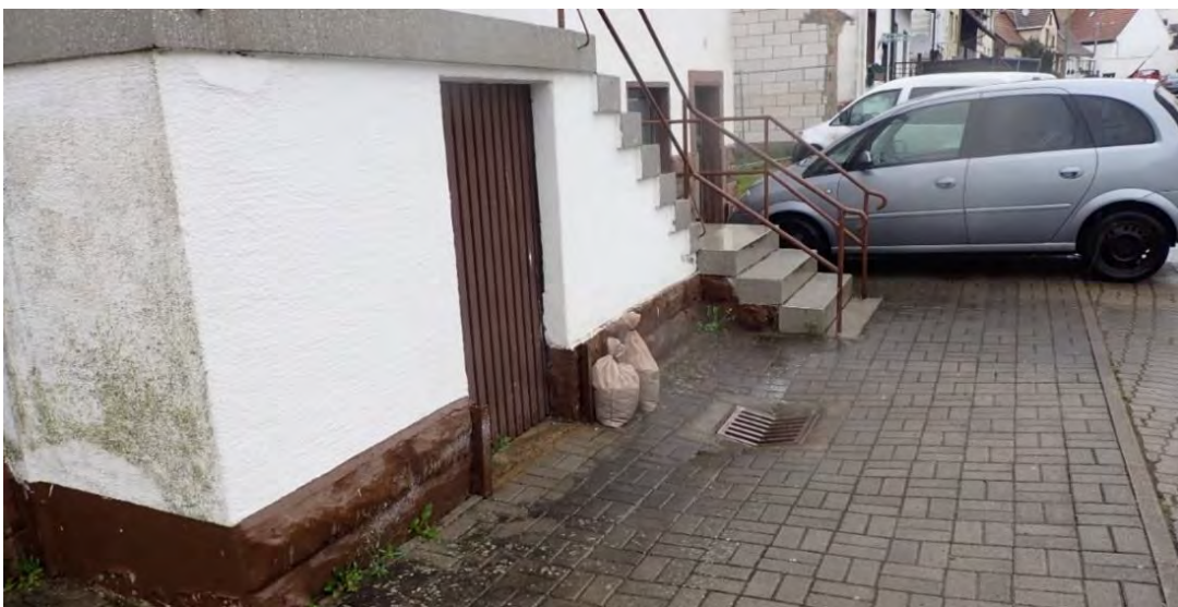
Abb. 32: Sandsäcke als bestehender Objektschutz in der "Kleinen Gasse"
