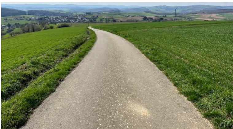
Abb. 54: Wegabschnitt mit talseitigem Seitengraben
