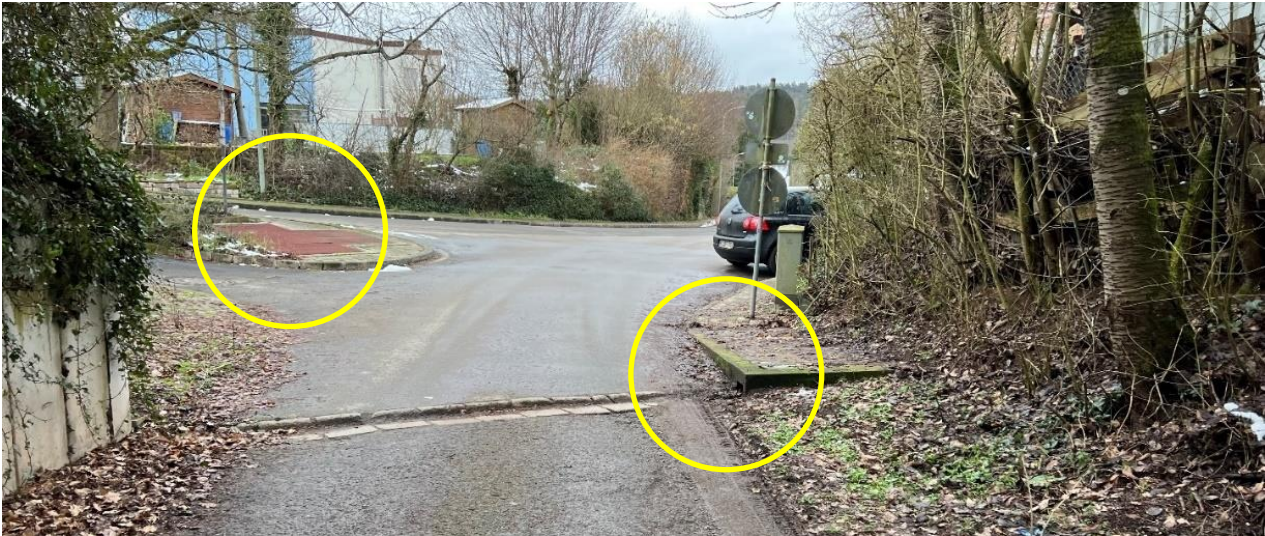
Abb. 56: Sandfänge an der Kreuzung Reichenbacher Weg - Steinstraße
