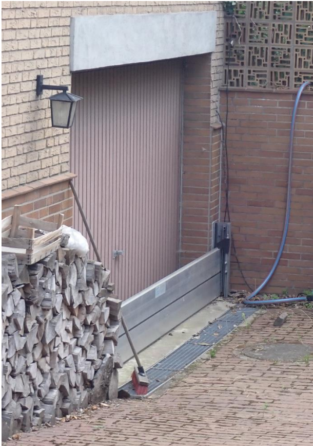
Abb. 26: Dammbalkenverschluss (links) und Schott (rechts)
