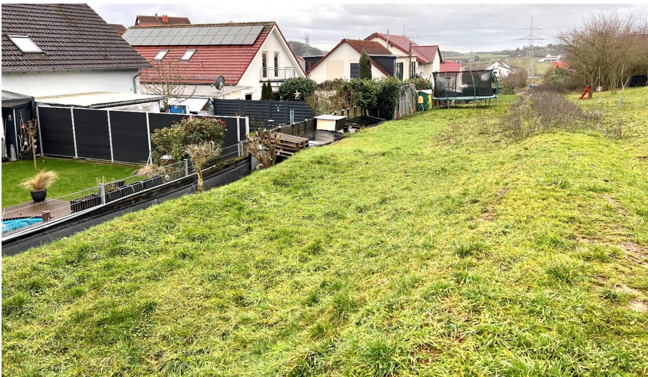
Abb. 132: Im Extremfall überflutungsgefährdete Bebauung in der Schwalbenstraße
