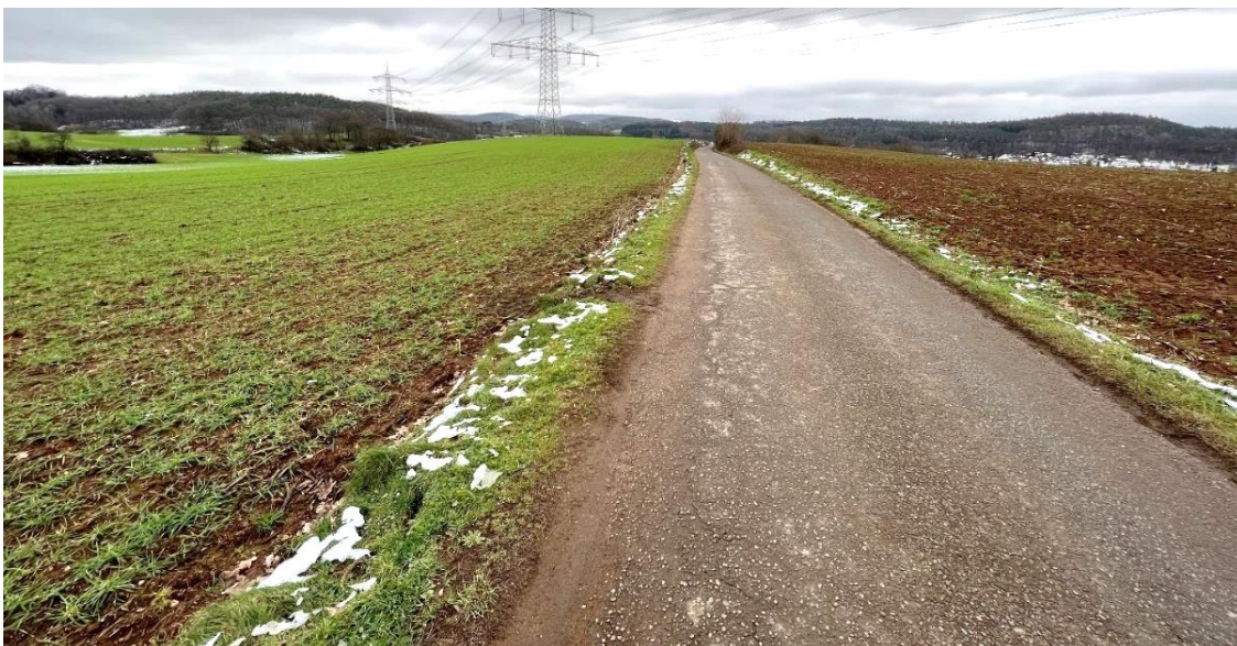
Abb. 49: Wirtschaftsweg zum Himmelreich mit Potenzial zur Querentwässerung
