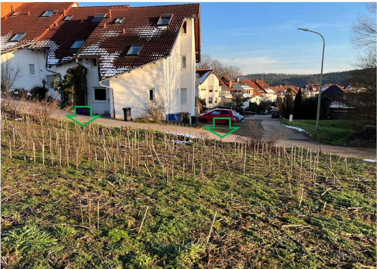
Abb. 82: Verwallung (grüne Pfeile) zum Schutz der Bebauung vor wildem Außengebietszufluss
