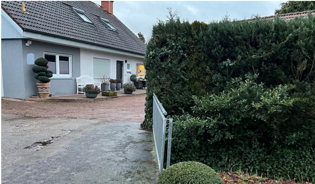
Abb. 154: Überflutungsgefährdetes Anwesen an einem Dutenbachdurchlass
