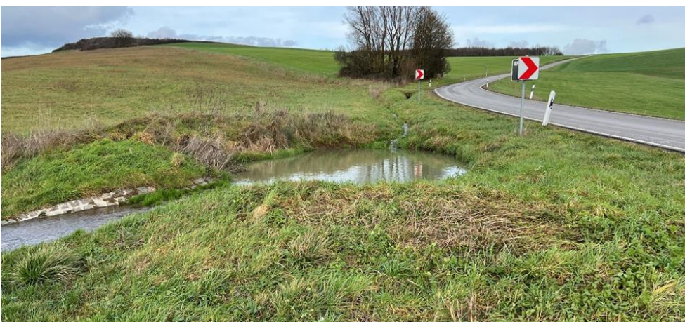
Abb. 16: Beispiele für gelungene Querentwässerung und Kleinrückhalte in landwirtschaftlichen Flächen Örtliches Hochwasser- und Starkregenvorsorgekonzept Otterbach
