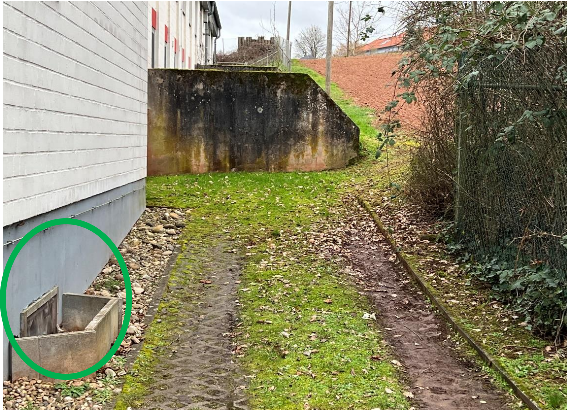
Abb. 95: Objektschutzmaßnahme am Kellerfenster des Kindergartens
