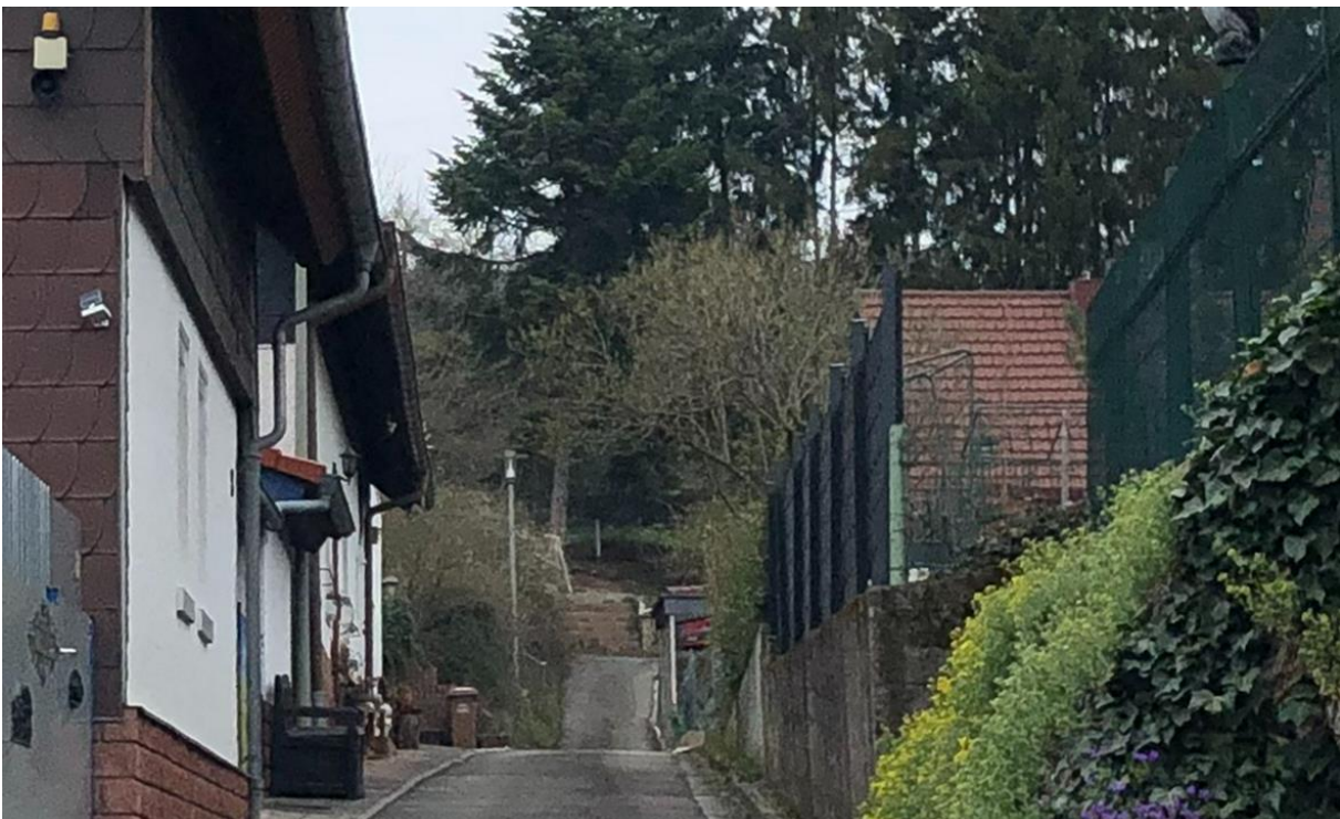
Abb. 90: Potenziell überflutungsgefährdete Randbebauung der Straße Sonnenhof
