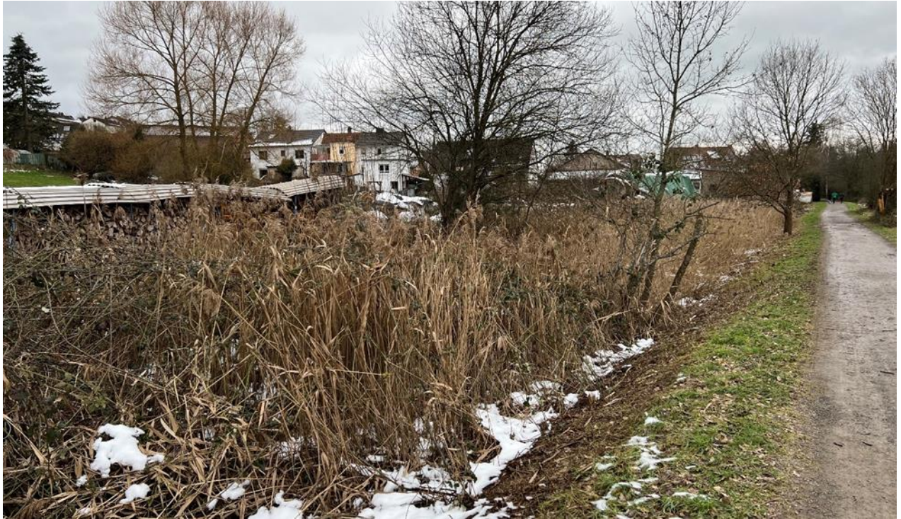
Abb. 31: Überflutungsgefährdete Bebauung südlich des Radwegs am Ortsrand von Otterbach
