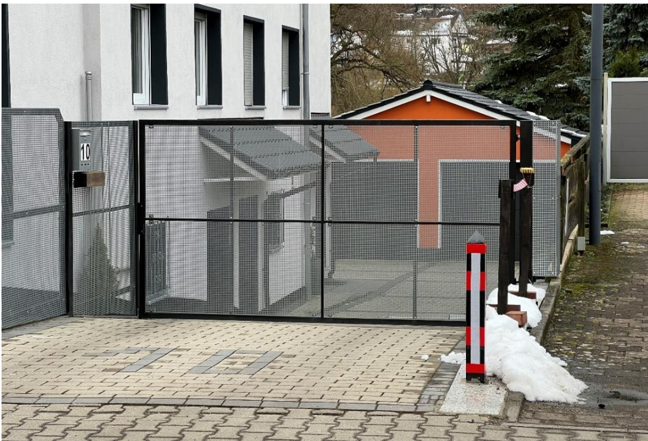
Abb. 20: Beispiel für überflutungsgefährdete tiefliegende Gebäudeteile
