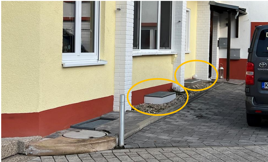
Abb. 62: Objektschutz an Lichtschächten
