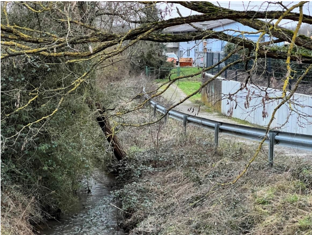
Abb. 78: Überflutungsgefährde Senke neben dem Otterbach
