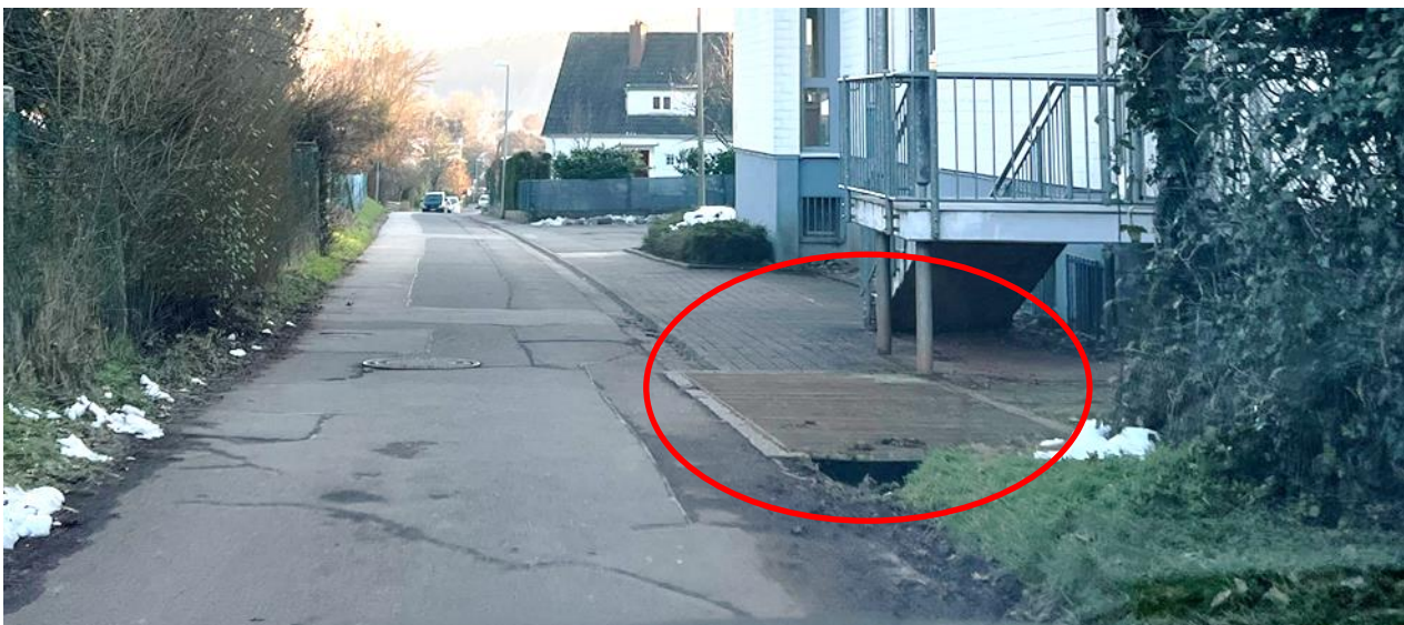
Abb. 94: Sandfang neben dem Kindergarten in der oberen Kirchthalstraße
