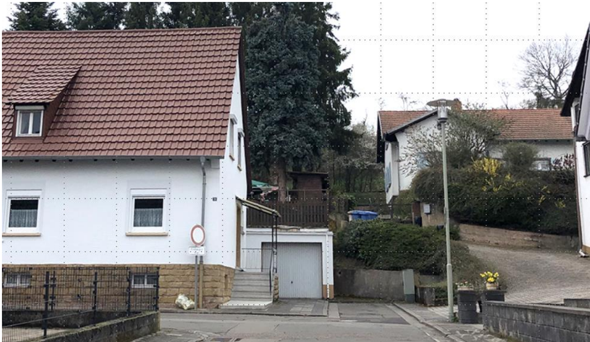
Abb. 91: Potenziell überflutungsgefährdete Randbebauung in der Straße „In der Delle“
