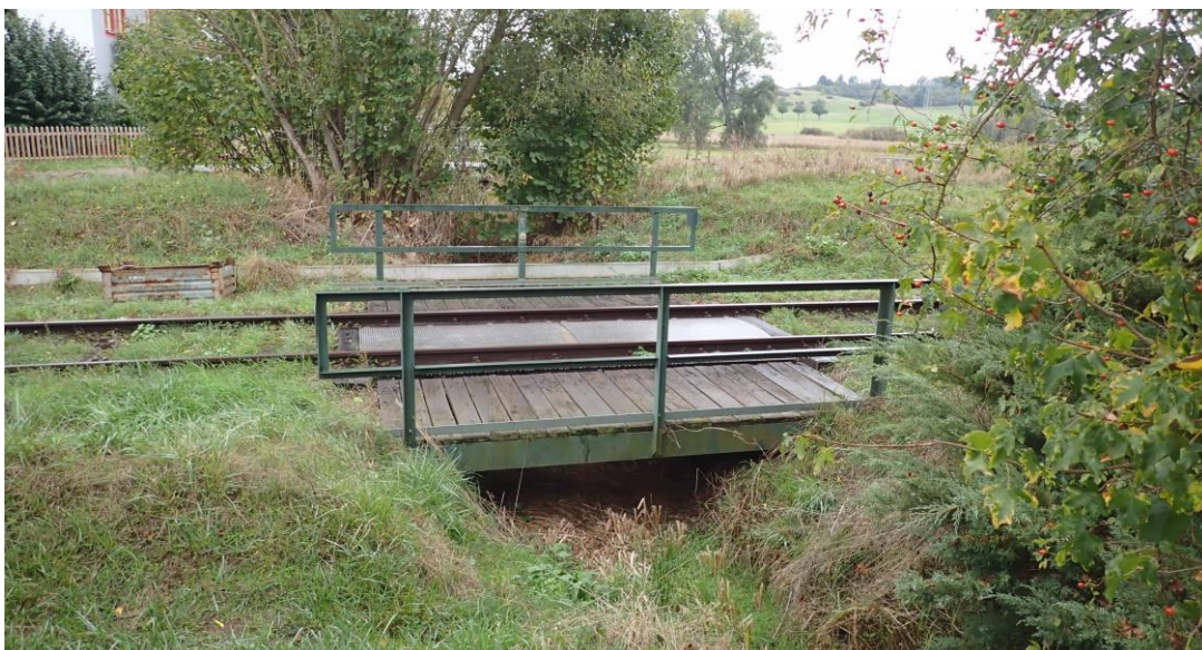
Abb. 155: Überflutungsgefährdeter Bahndurchlass
