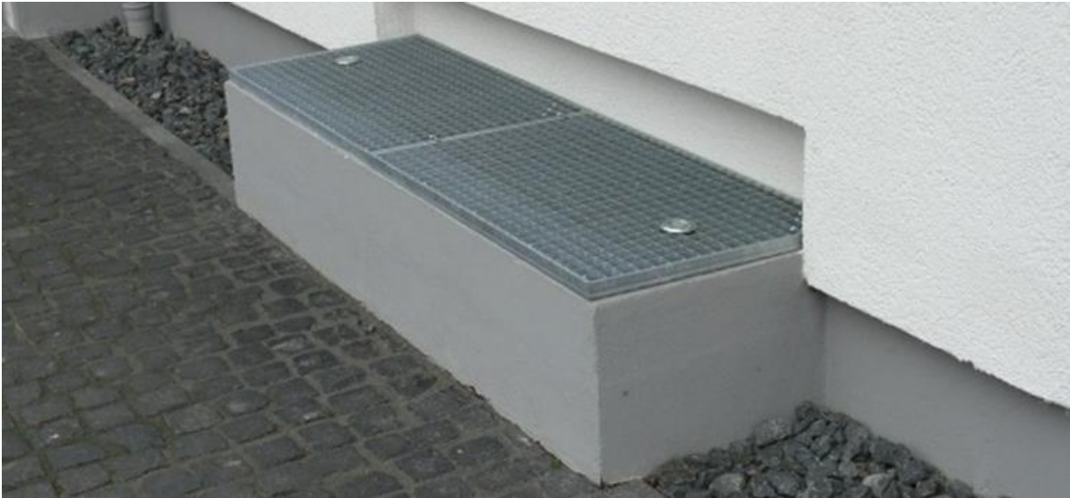
Abb. 24: Beispiel für die Sicherung eines niveaugleichen Lichtschachtes
