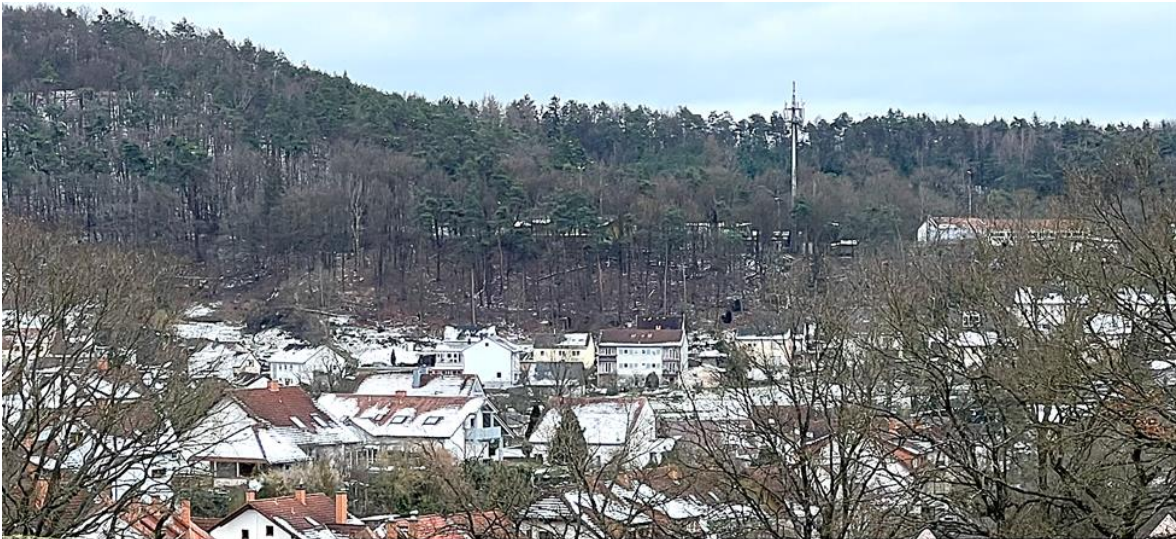
Abb. 60: Bewaldetes Außengebiet und überflutungsgefährdete Ortslage
