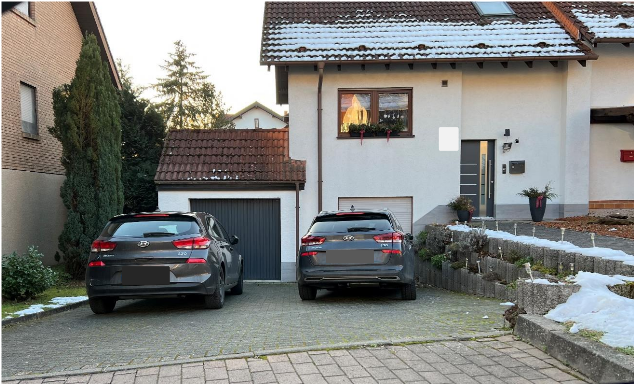
Abb. 87: Beispiel für überflutungsgefährdete Gebäudeteile tiefer als die Straße
