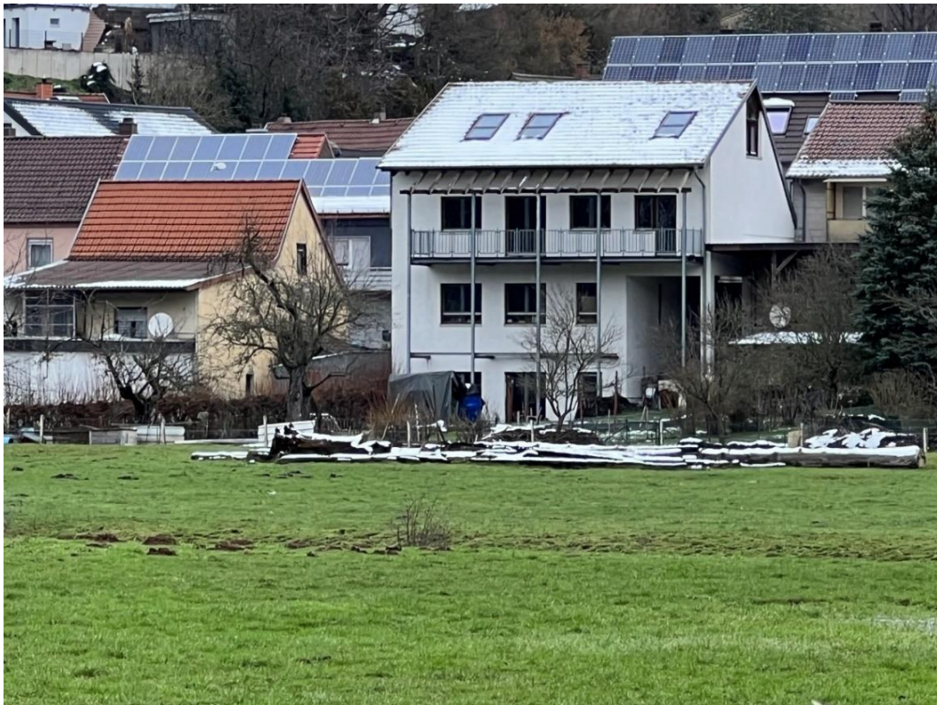
Abb. 37: Potenziell überflutungsgefährdetes Anwesen an der Otterstraße
