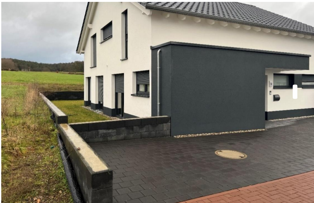
Abb. 163: Exponiert liegende, überflutungsgefährdete Wohngebäude
