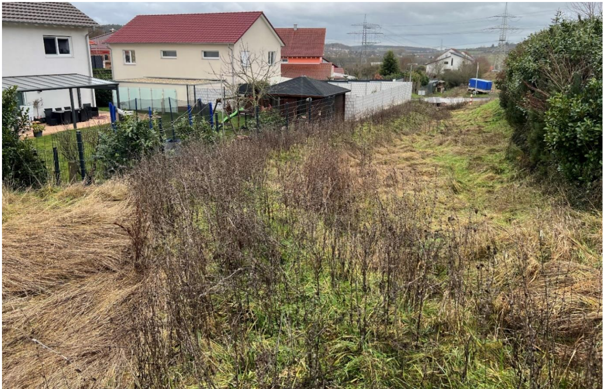
Abb. 123: Rückhaltemulde mit Unterhaltungsbedarf
