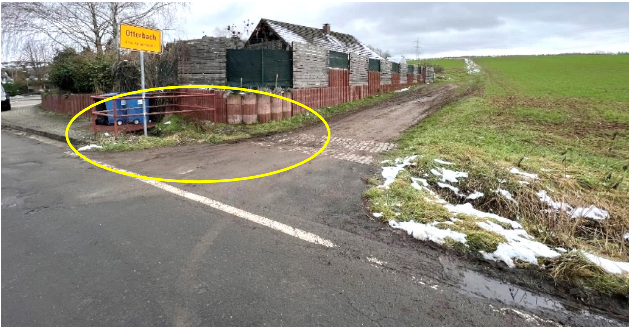
Abb. 57: Sandfang am Reichenbacher Weg
