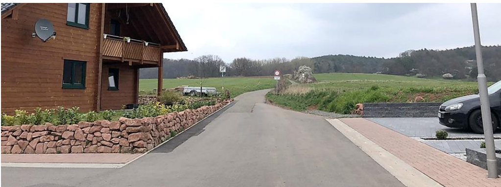
Abb. 159: Potenziell wasserführender Weg aus dem Außengebiet in das Neubaugebiet
