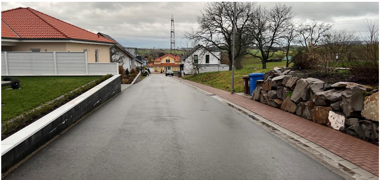
Abb. 22: Beispiel für potenziell überflutungsgefährdete Bebauung am Ende einer abschüssigen Straße
