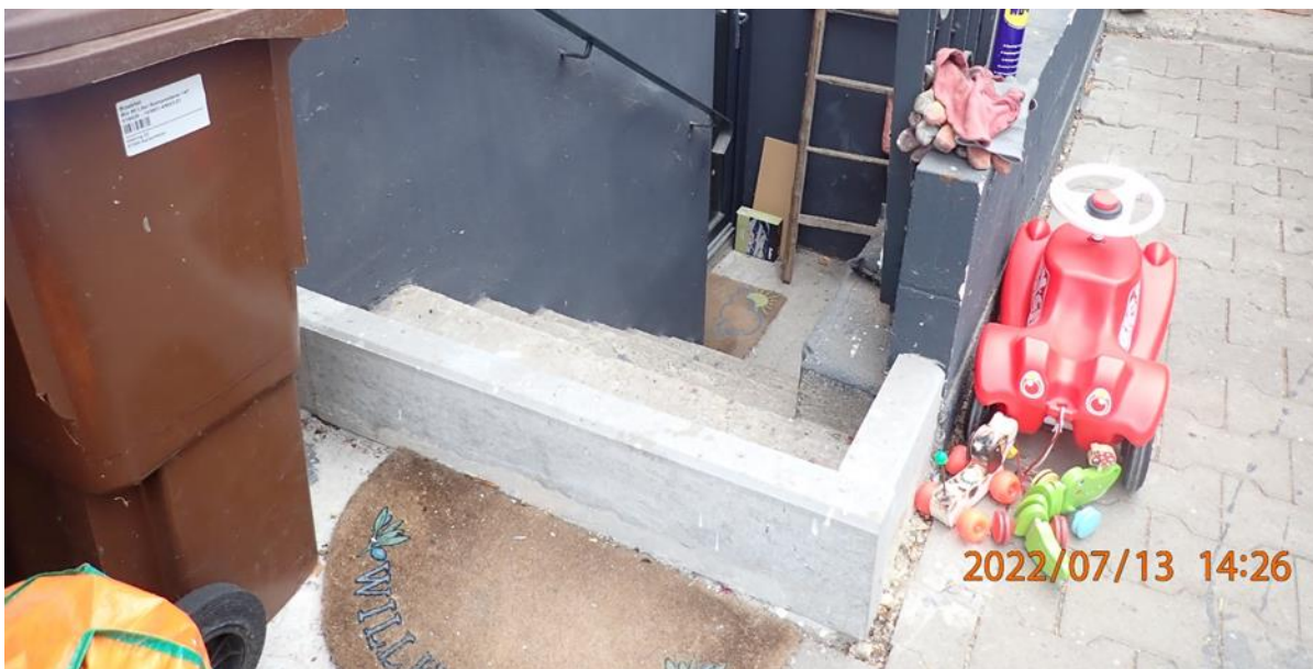
Abb. 25: Beispiel für die Sicherung eines außenliegenden Kellerzuganges
