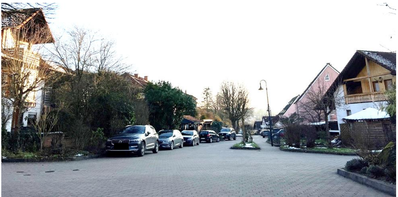
Abb. 86: Straße „In der Zeil“ als Notabflussweg für Oberflächenwasserabfluss
