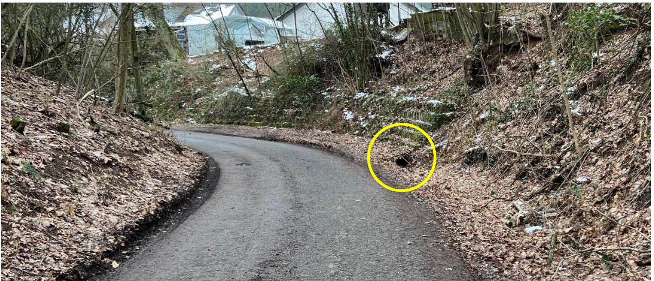
Abb. 55: Beginn der Kanalisation
