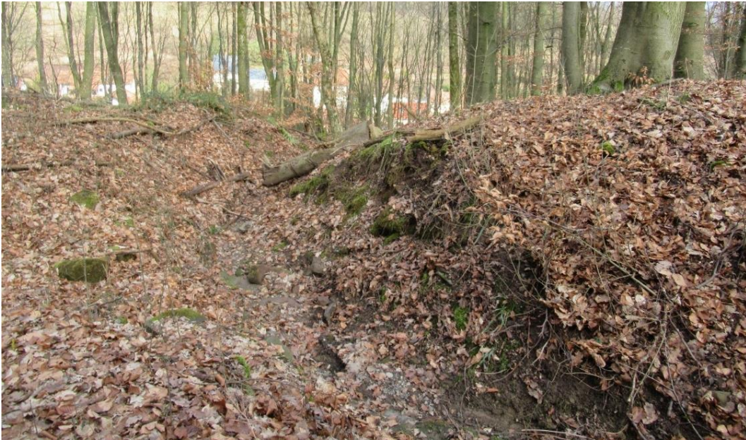
Abb. 14: Beispiel für einen Querabschlag von einem Waldweg in die Fläche
