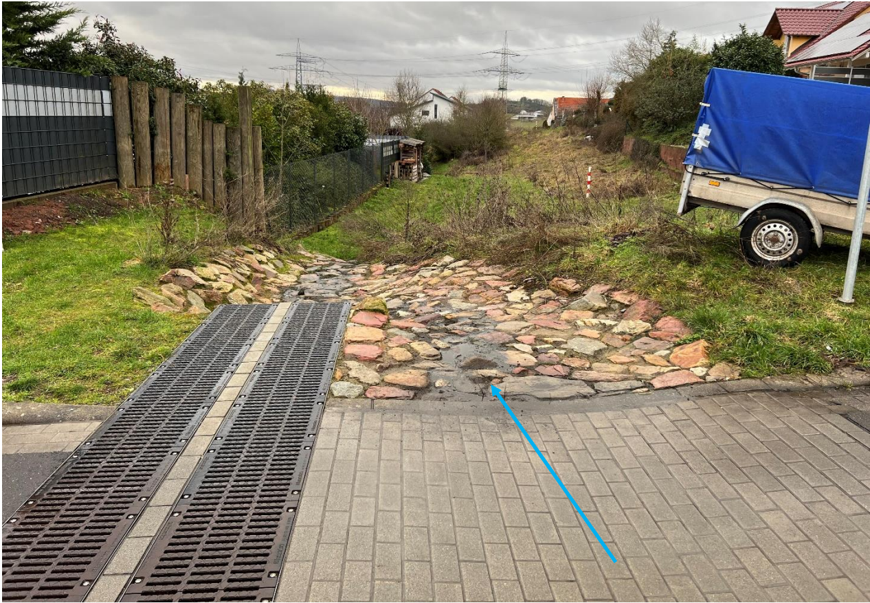
Abb. 124: Querung der Fasanenstraße und Zuflussmulde für Oberflächenabfluss von Norden
