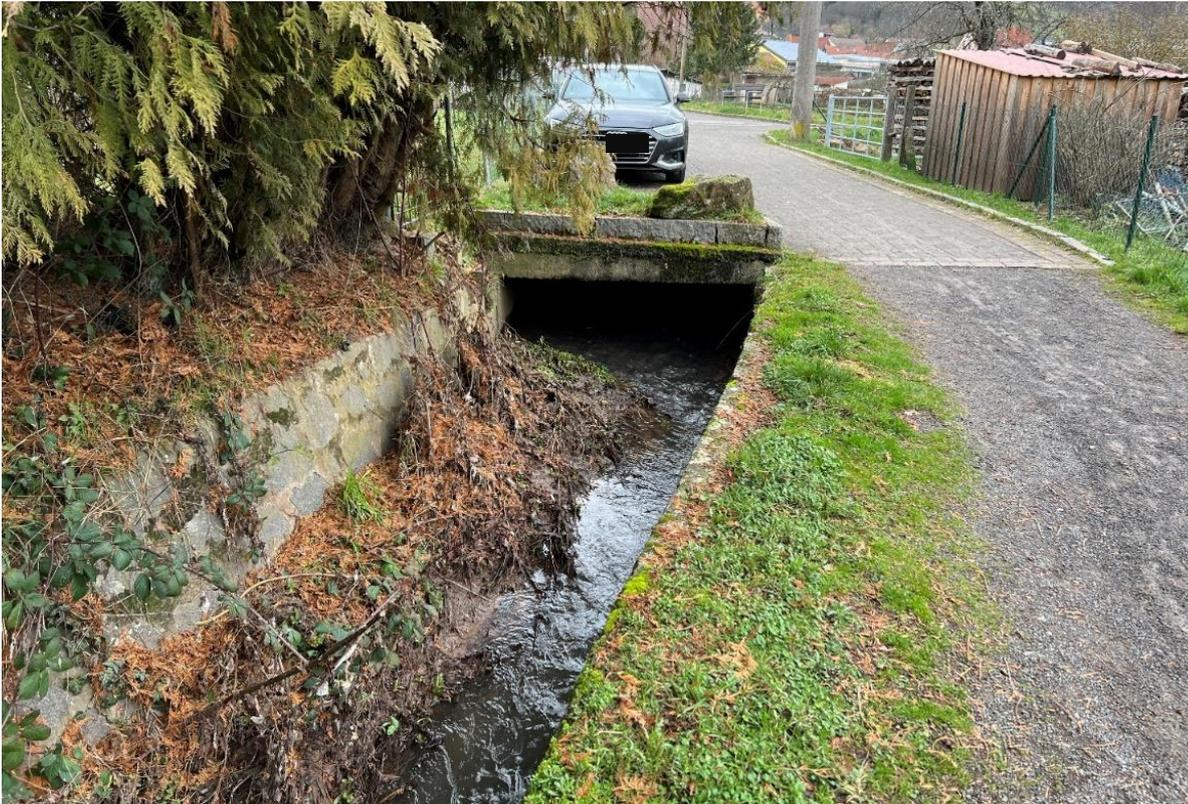
*Abb. 118: Ausmündung der Holzgrabenverrohrung in der Lauteraue*
