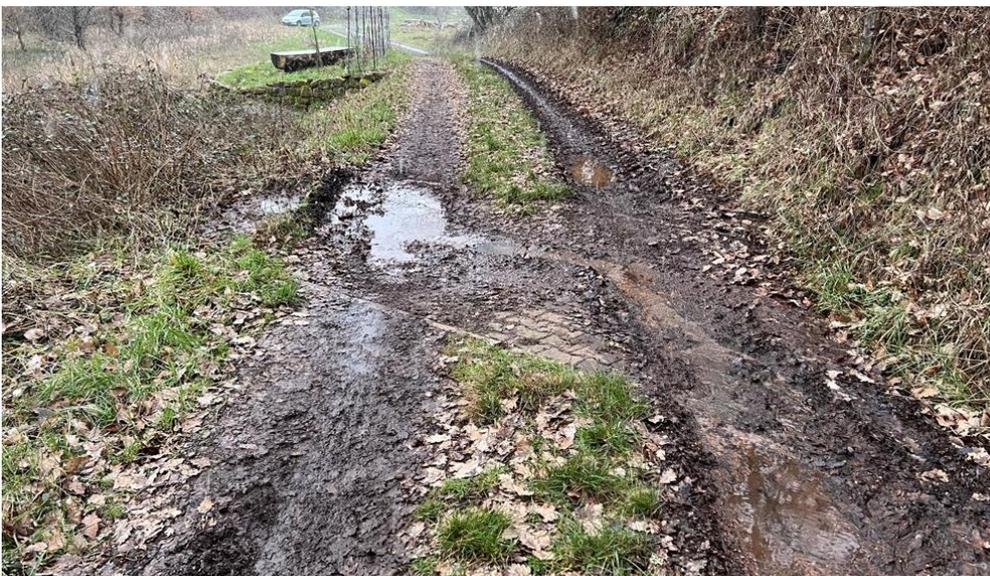
Abb. 17: Beispiele für die punktuelle Querentwässerung in die Fläche in Olsbrücken
