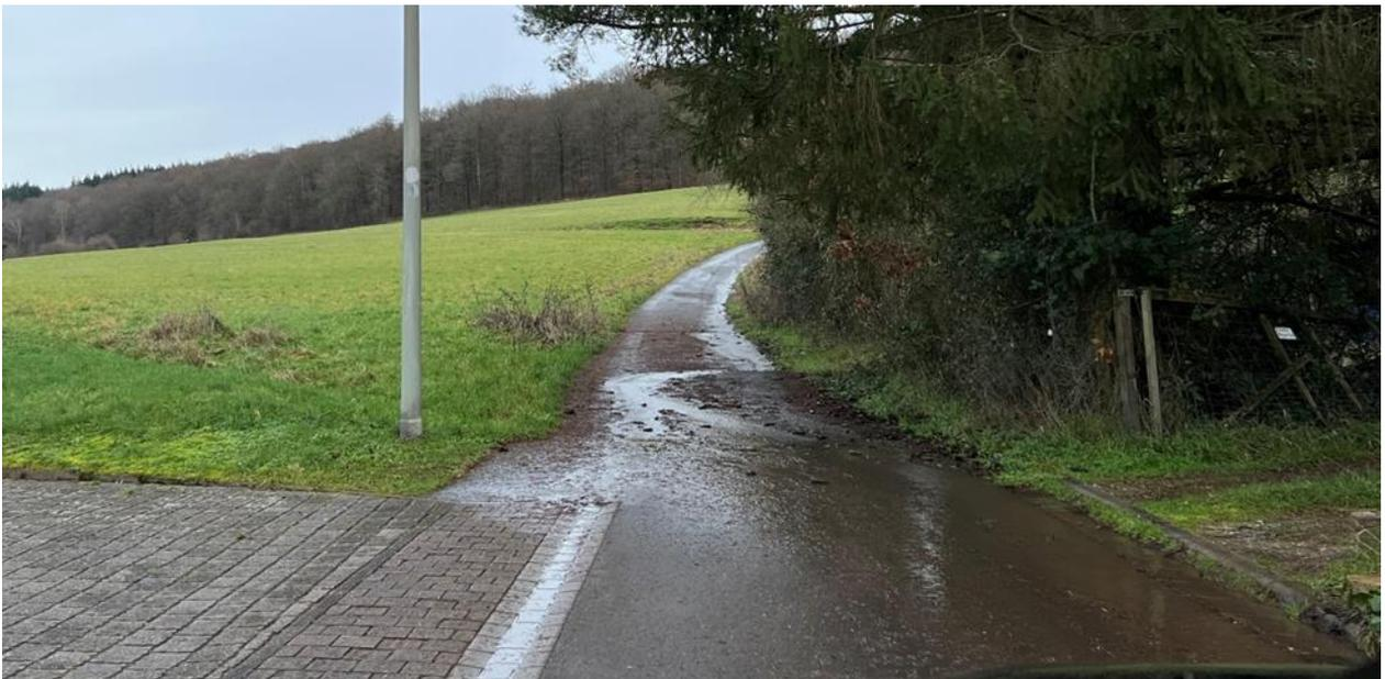
*Abb. 90: Wilder Zufluss von Außengebietswasser am Standort des aufgelassenen Sandfangs*
