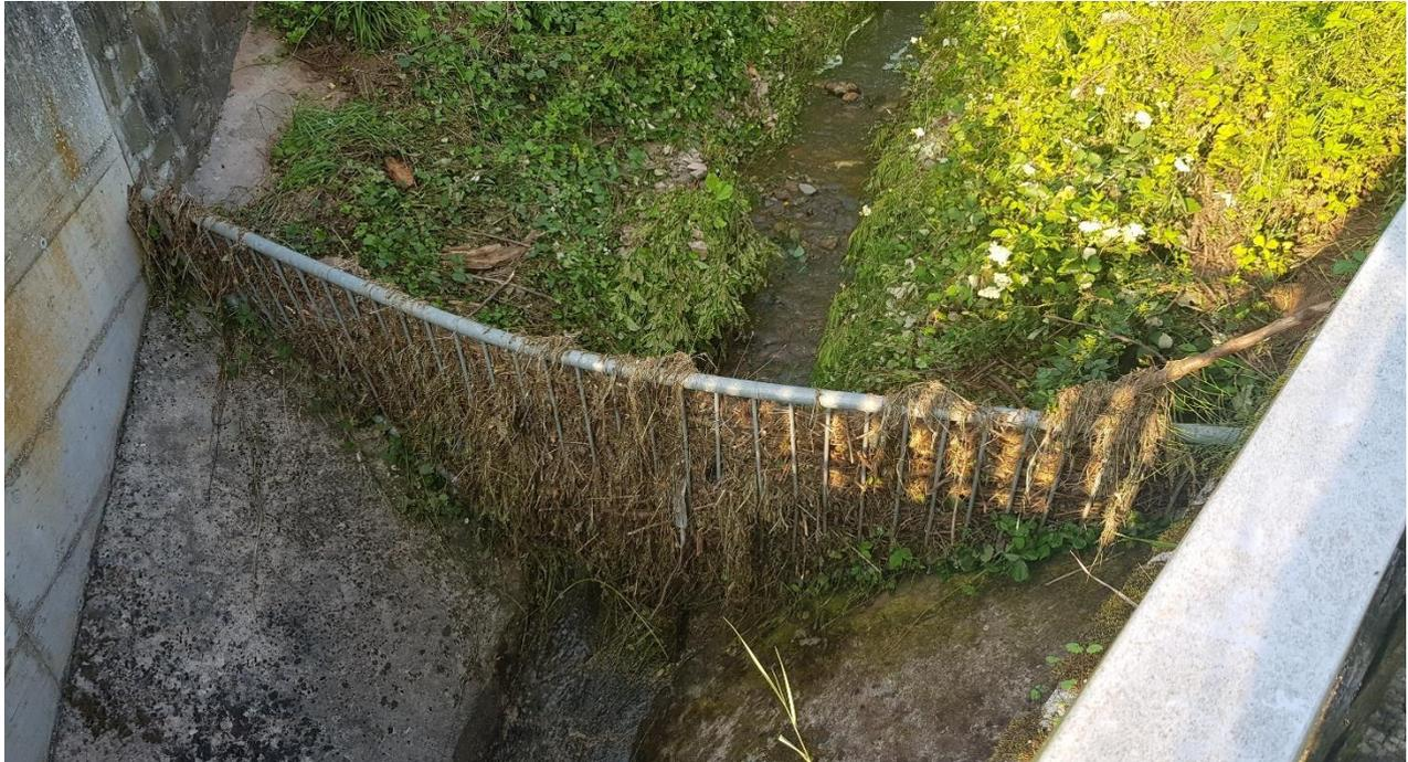
Abb. 73: Verlegter Rechen an der Rutzenbachverrohrung am 16.07.2021, Foto: Rösner
