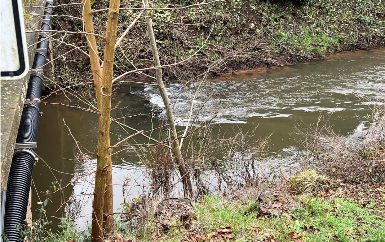
*Abb. 52: Sohlschwelle aus Geschiebe an der Brücke Bahnhofstraße*
