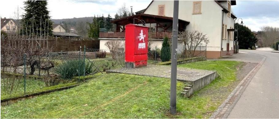
Abb. 7: Beispiel für einen hochstehenden Stromverteilerkasten im überflutungsgefährdeten Bereich
