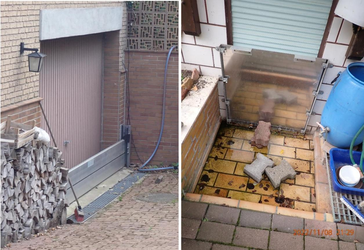
Abb. 27: Dammbalkenverschluss (links) und Schott (rechts)
