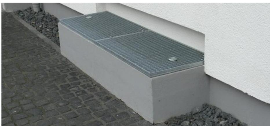
Abb. 25: Beispiel für die Sicherung eines niveaugleichen Lichtschachtes
