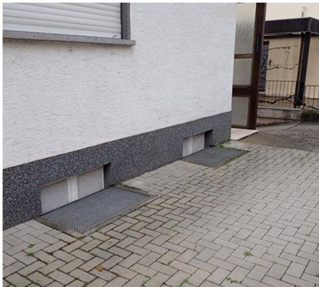
Abb. 24: Beispiele für überflutungsgefährdete Untergeschosse
