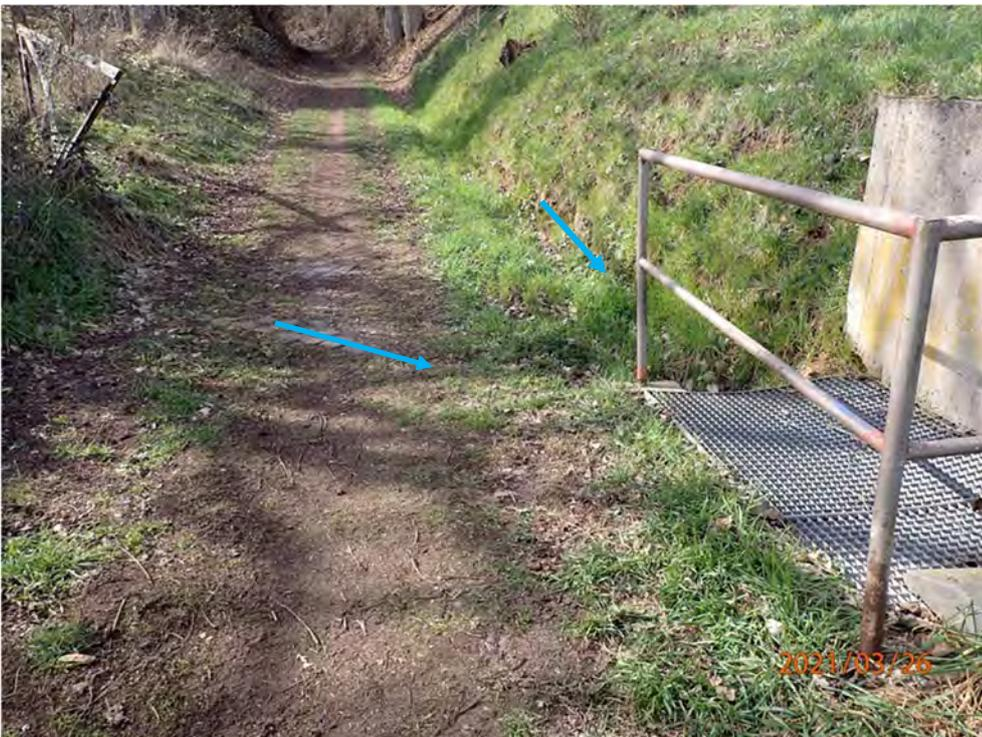
Abb. 42: Sandfang mit zuführendem Graben und Querrinne
