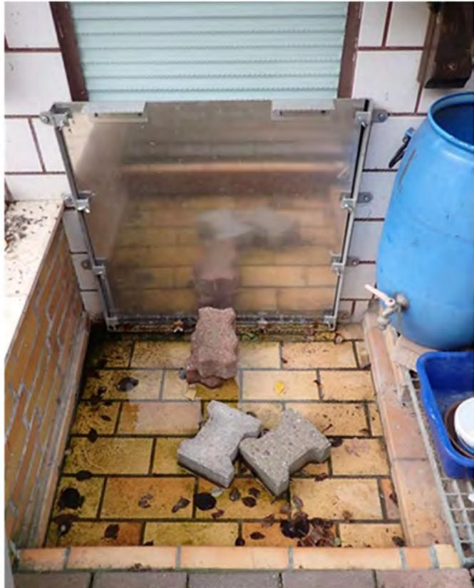
Abb. 22: Dambalkenverschluss (links) und Schott (rechts)
