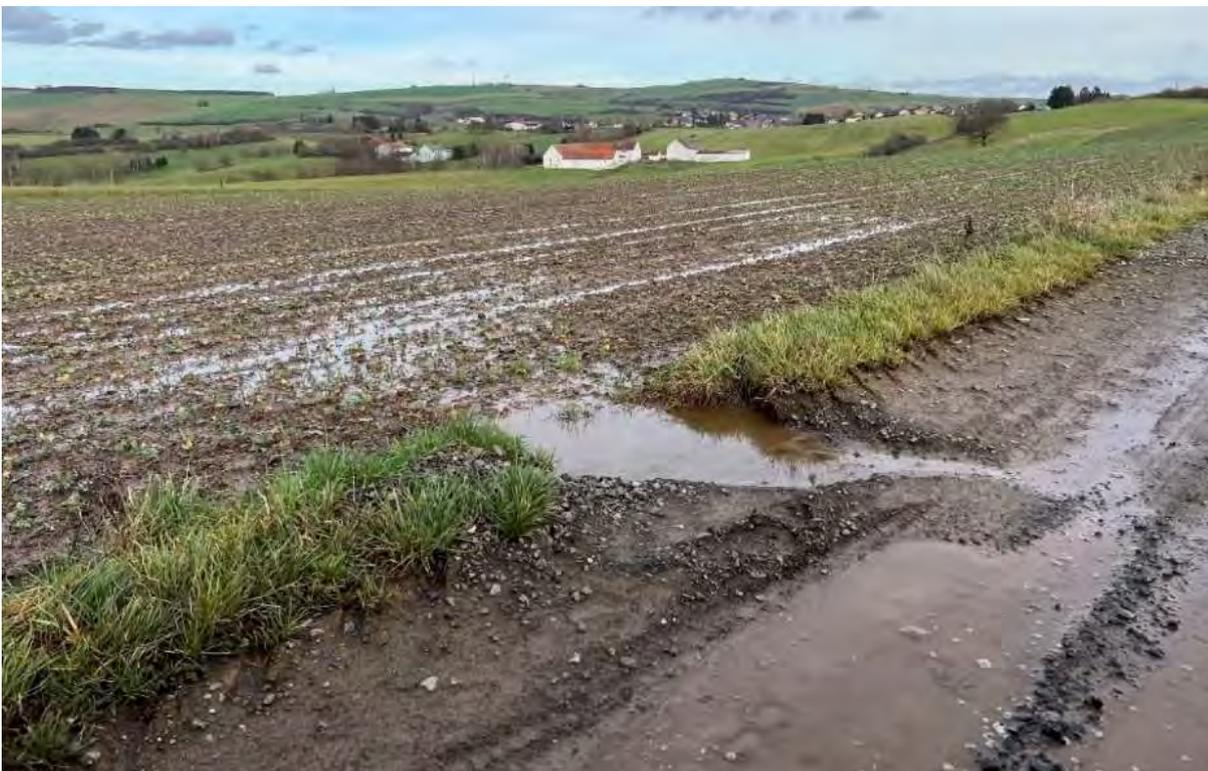
Abb. 11: Beispiel aus Schallodenbach für Querentwässerung in die Fläche durch Öffnen des Banketts
