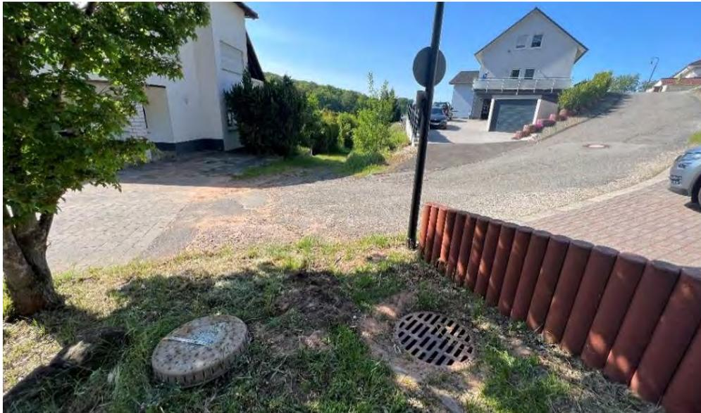
Abb. 55: Muldenablauf und oberirdischer Fließweg zum Fußweg
