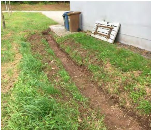
Abb. 28: Bestehender Abfangegraben für Außengebietswasser am Feuerwehrgerätehaus
