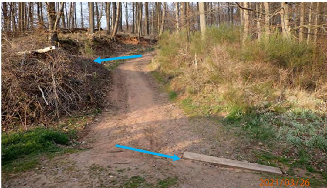
Abb. 78: Bestehende Querschläge im Weg zur Mobilfunkstation
