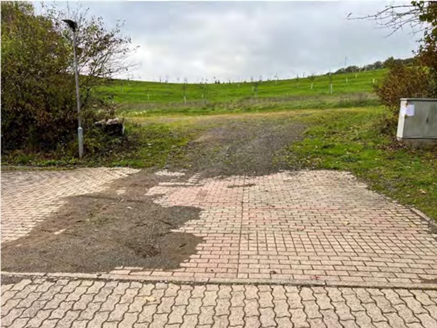
Abb. 30: Erosionsspuren hinter der Pfalzwaldhalle
