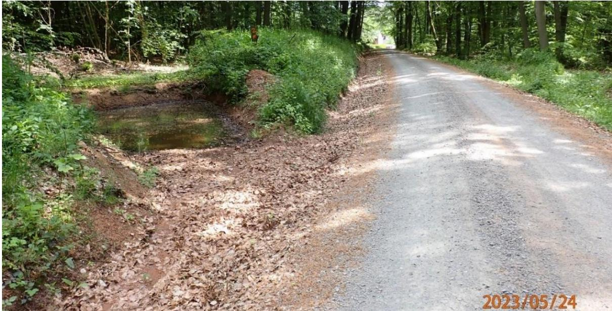
Abb. 6: Beispiel für einen Querabschlag von einem Waldweg in einen Kleinrückhalt
