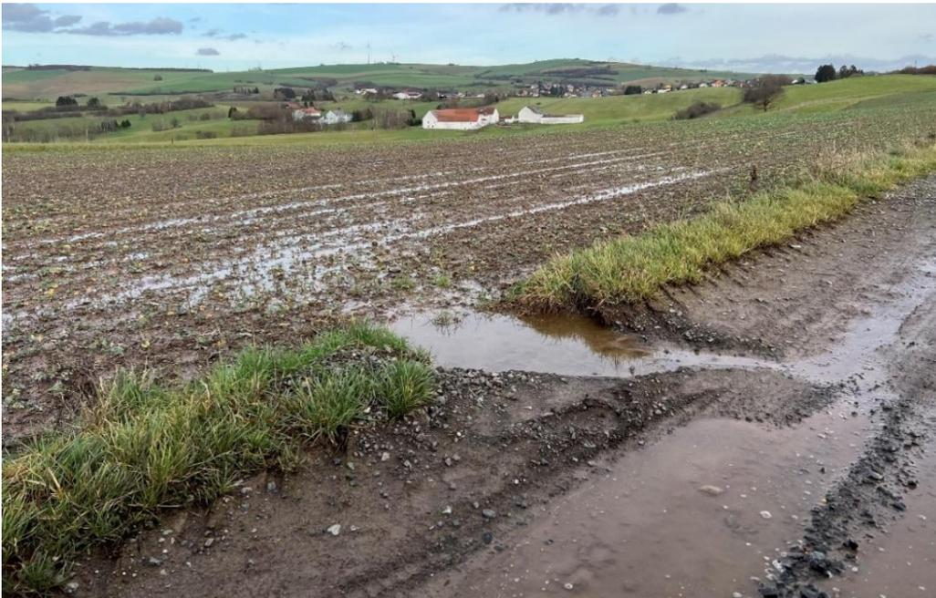
*Abb. 7: Beispiel für Querentwässerung in die Fläche durch Öffnen des Banketts*
