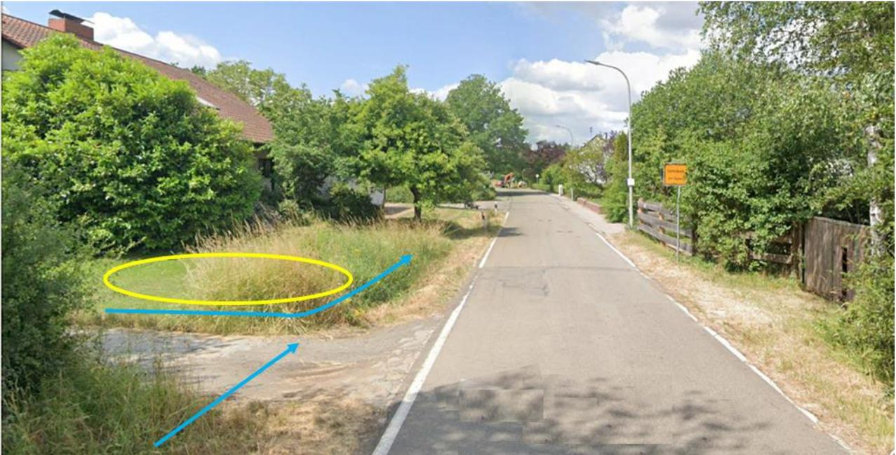
Abb. 60: Entwässerungsgräben und möglicher Standort für einen Kleinrückhalt (gelb)
