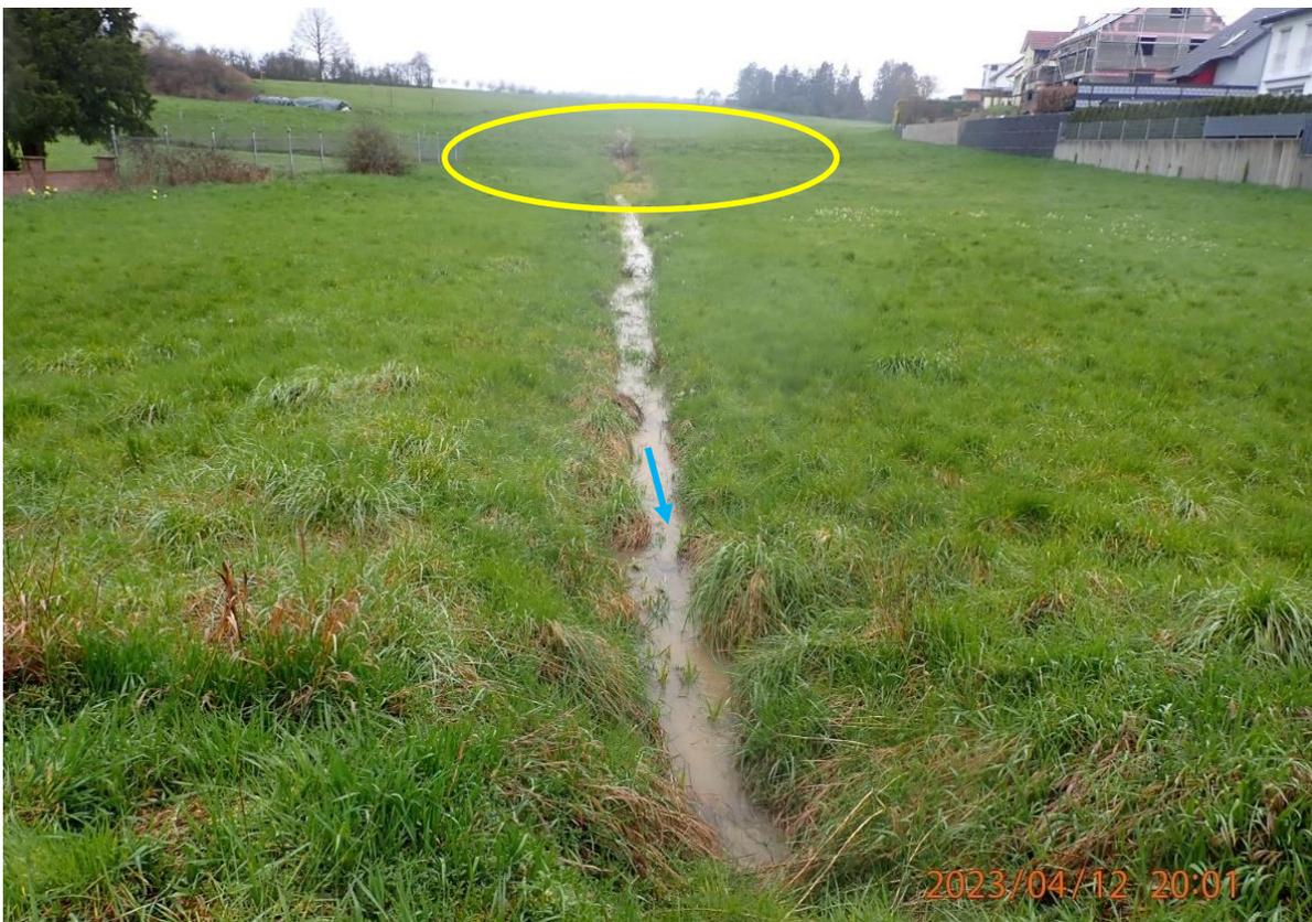
Abb. 99: Ablaufgraben aus dem Rückhaltebeckens
