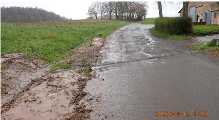
Abb. 39: Oberflächenabfluss auf dem Weg und im Wegseitengraben bei leichtem Regen im April 2023
