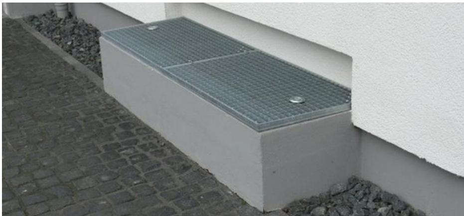
Abb. 13: Beispiel für die Sicherung eines niveaugleichen Lichtschachtes
