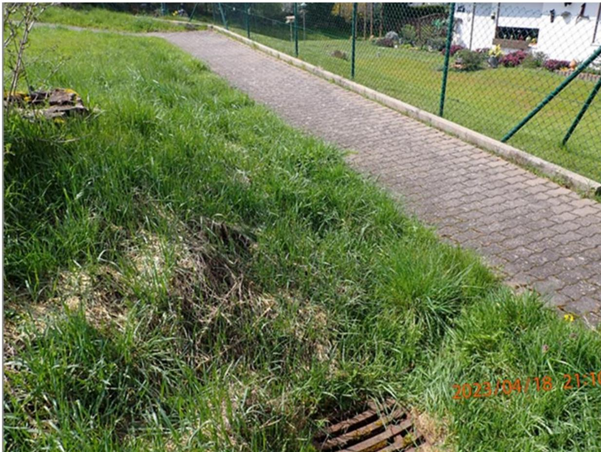
Abb. 72: Befestigter Fußweg mit angrenzendem Muldenablauf
