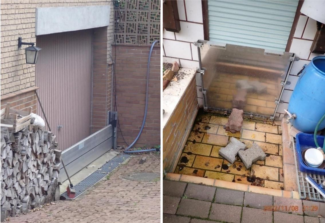
Abb. 15: Dammbalkenverschluss (links) und Schott (rechts)
